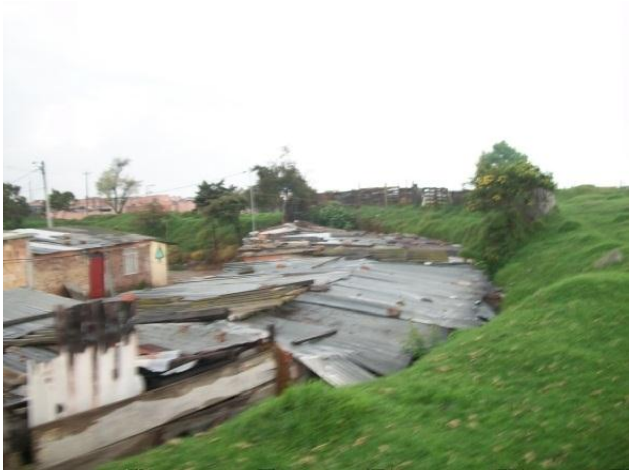
Figura 32 vivienda de invasión adosado a la ronda del río
