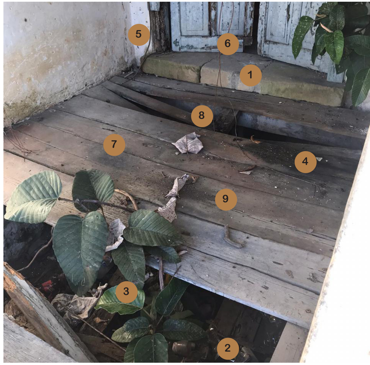
1. EDIFICIO DE ADMINISTRACIÓN (FOTO DETALLE MADERA - ENTREPISO)
