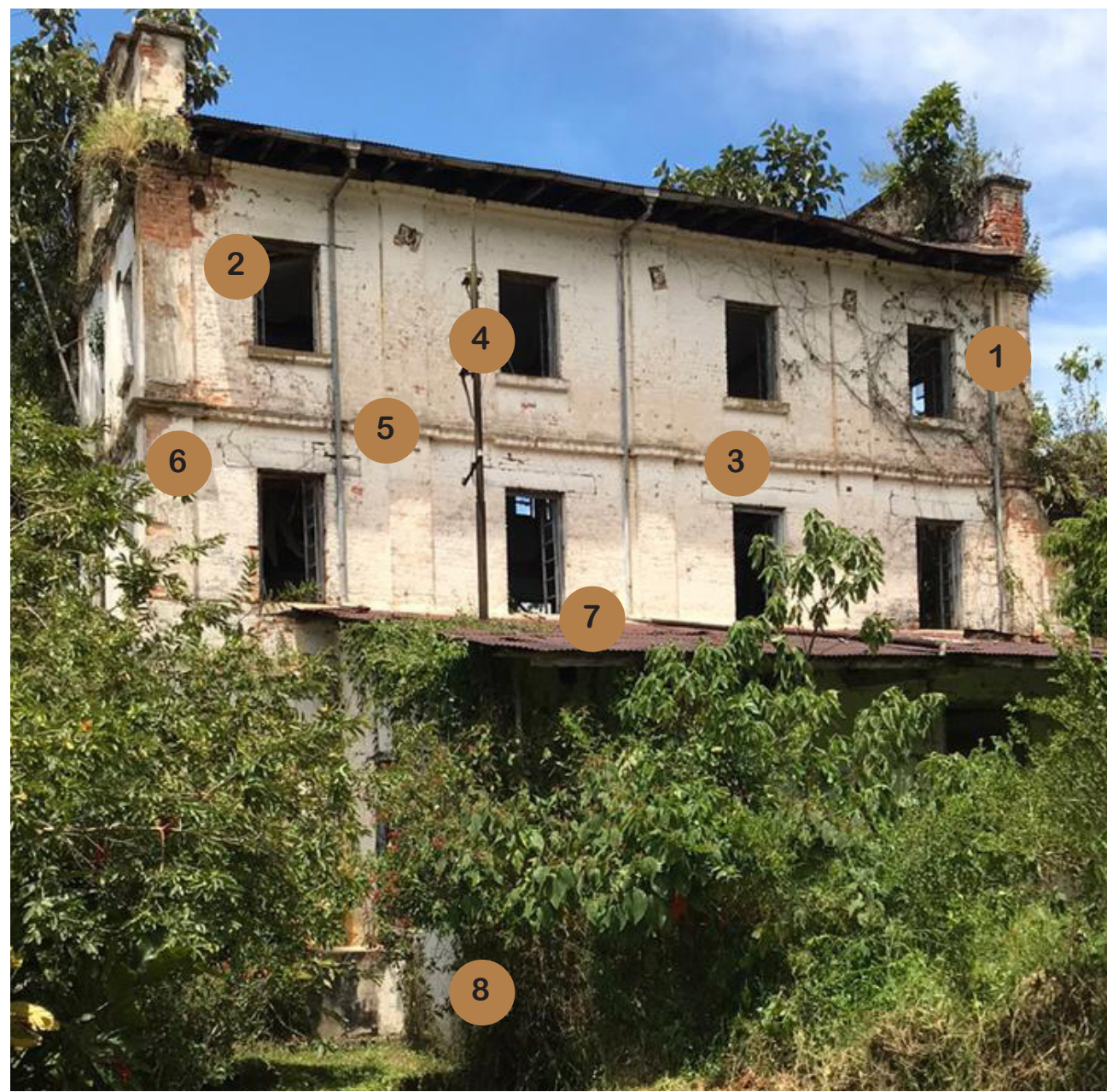
1. EDIFICIO DE ADMINISTRACIÓN (FOTO GENERAL - FACHADA LATERAL DERECHA)
