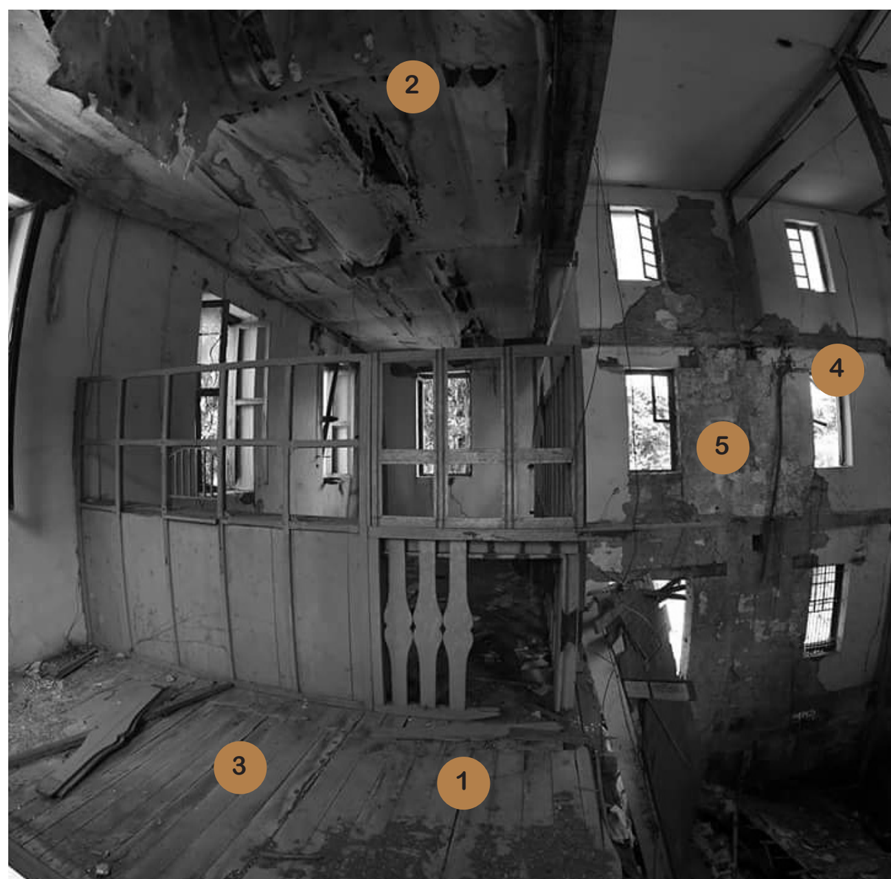
1. EDIFICIO DE ADMINISTRACIÓN (FOTO DETALLE - INTERIOR)
