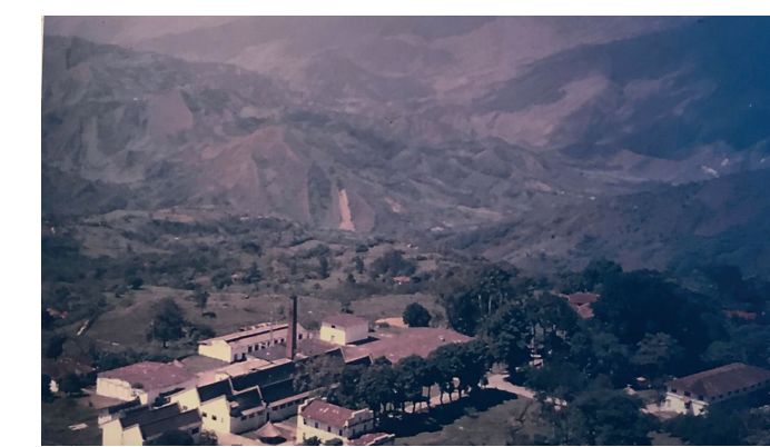
Vista general de las Fábricas de Hilados y Tejidos de San José de Suaita. (Ana Teresa Guzmán Vargas y Ana Isabel Rivera Prada)
