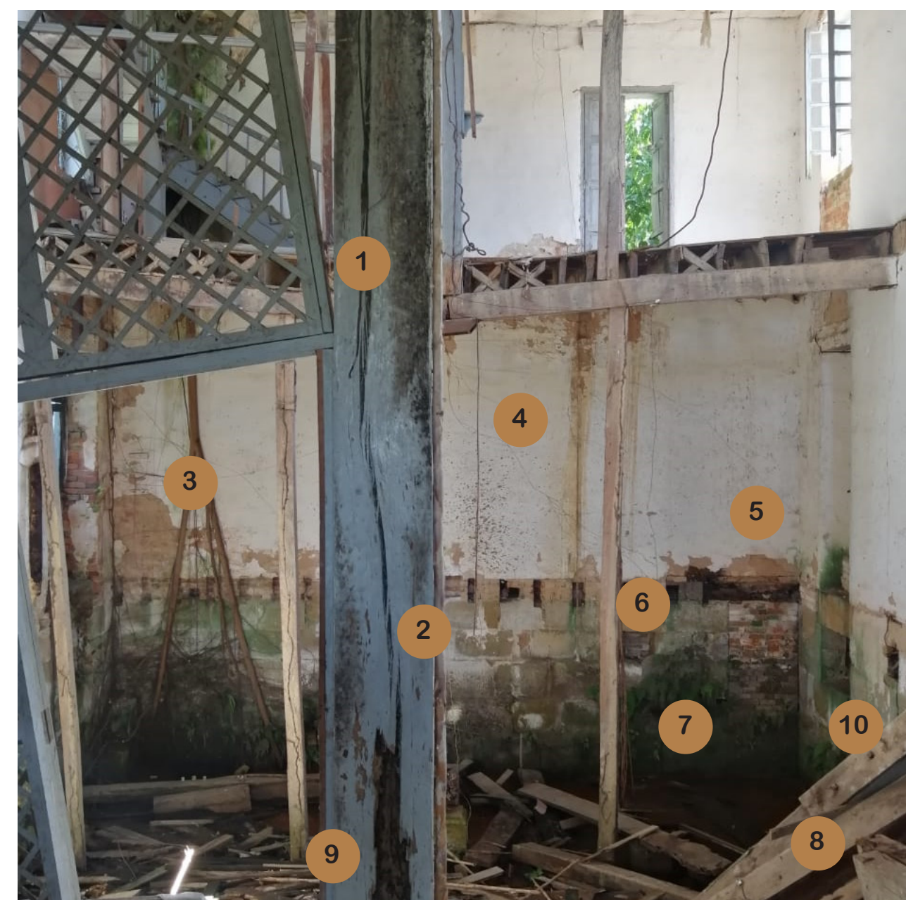
1. EDIFICIO DE ADMINISTRACIÓN (FOTO DETALLE - INTERIOR)
