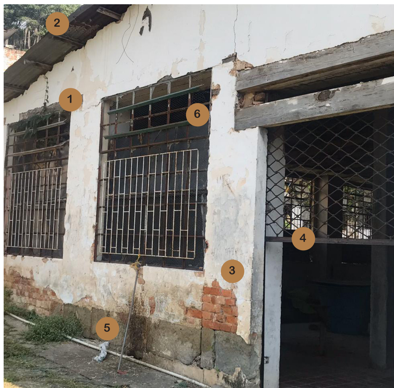
3. EDIFICIO DE COSTURA (FOTO GENERAL - FACHADA POSTERIOR)
