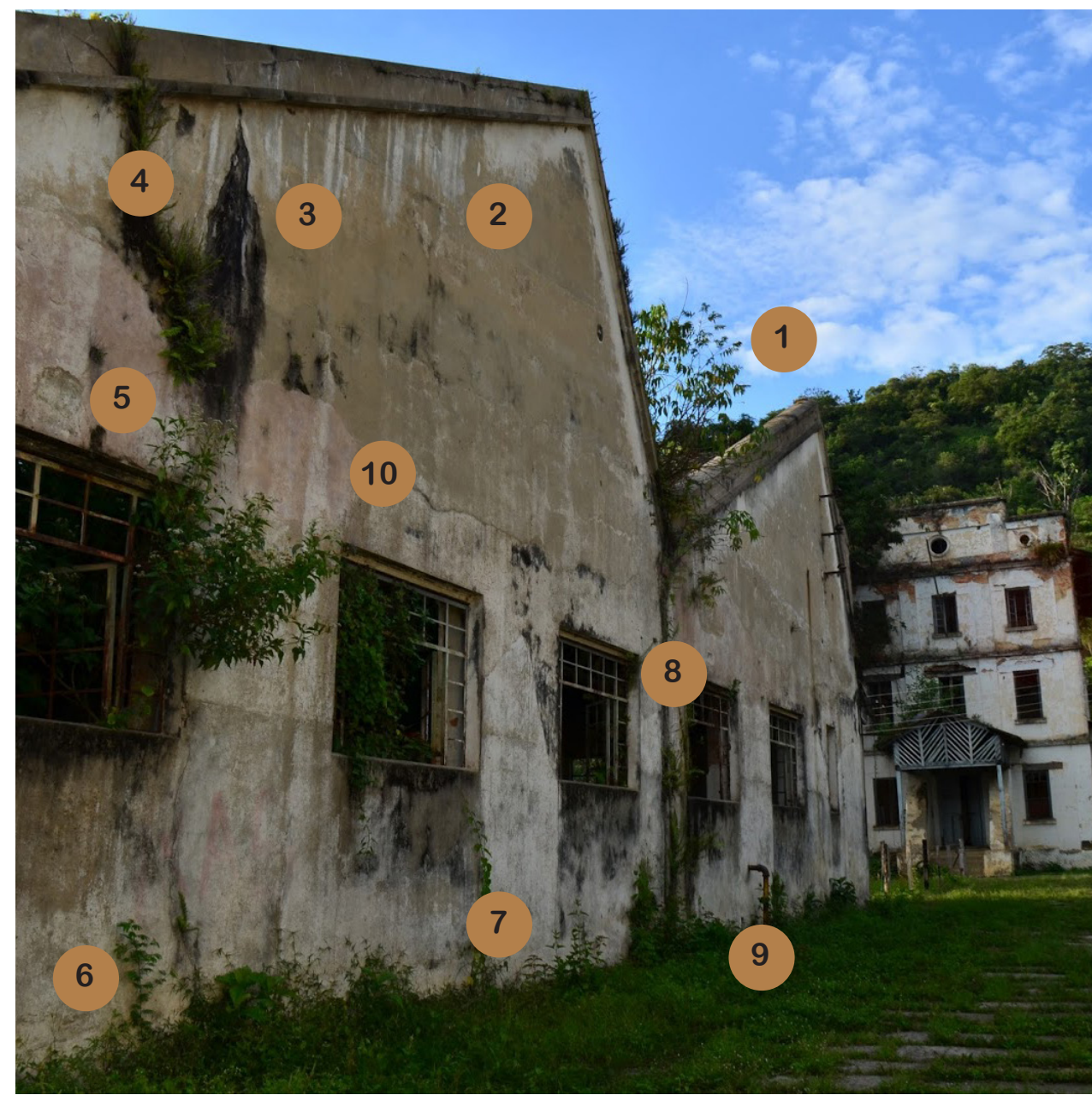
2. EDIFICIO DE HILADOS (FOTO DETALLE)
