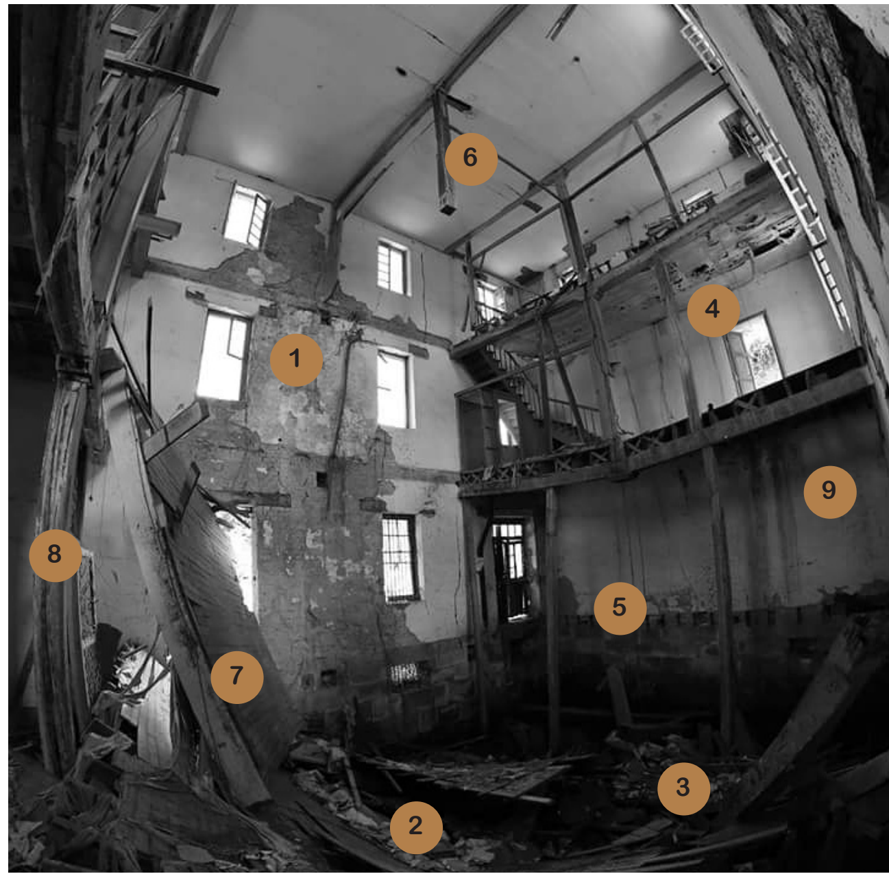
1. EDIFICIO DE ADMINISTRACIÓN (FOTO DETALLE - INTERIOR)
