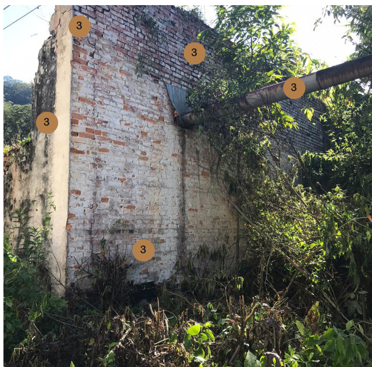
6. EDIFICIO DE ALMACENAMIENTO No. 2 (FOTO GENERAL - FACHADA POSTERIOR)
