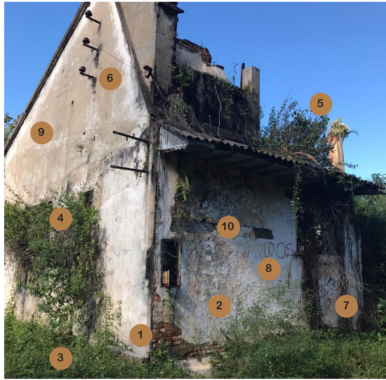
2. EDIFICIO DE HILADOS (FOTO GENERAL - FACHADA LATERAL IZQUIERDA)
