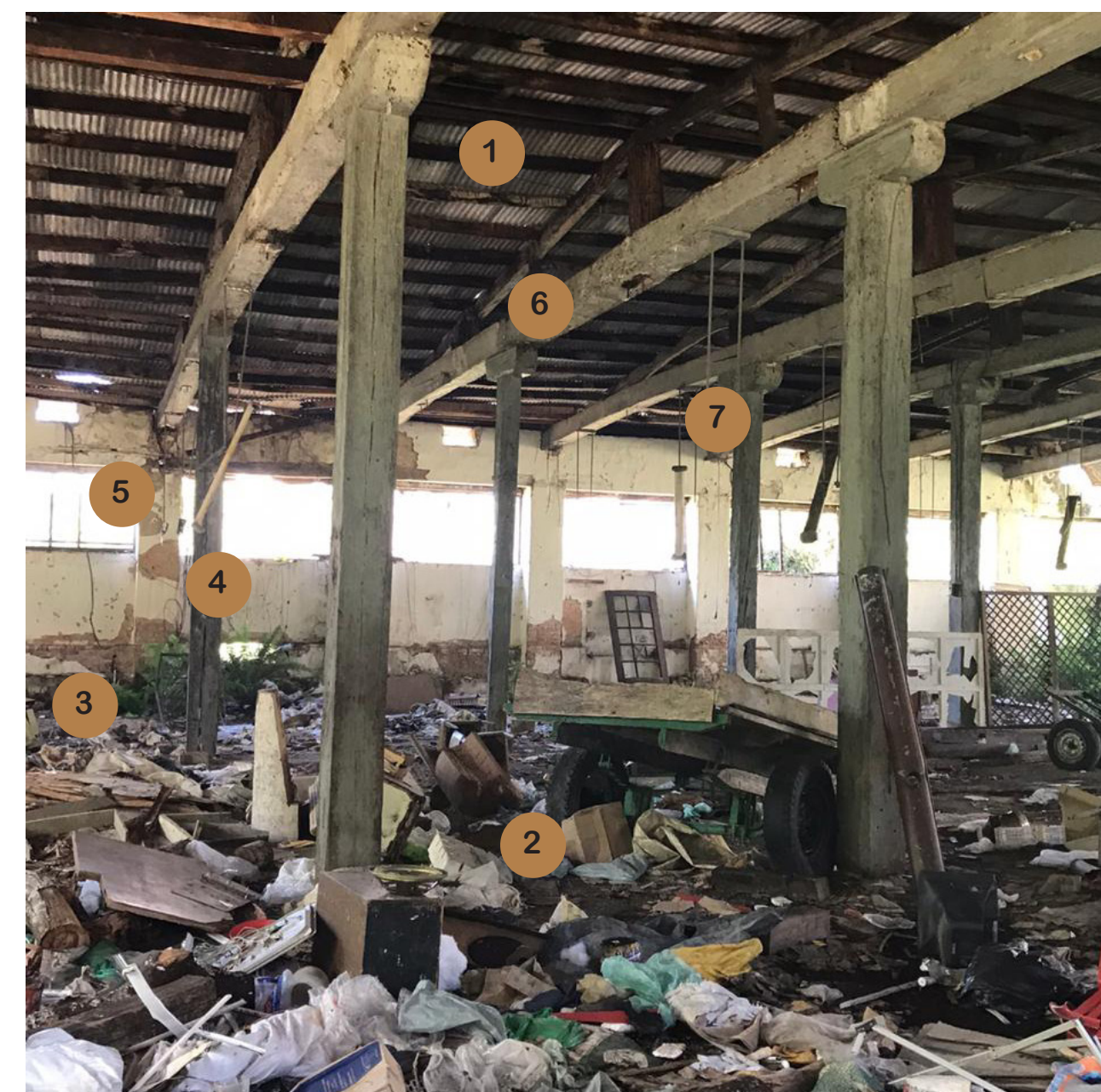
3. EDIFICIO DE COSTURA (FOTO DETALLE - INTERIOR)
