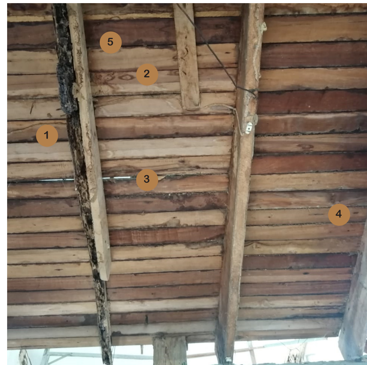
1. EDIFICIO DE ADMINISTRACIÓN (FOTO DETALLE MADERA - ENTREPISO)
