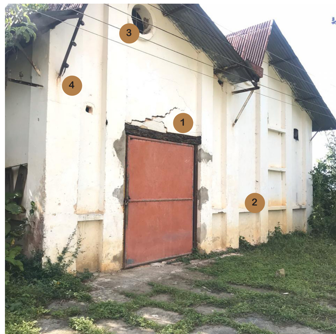
5. EDIFICIO DE ALMACENAMIENTO No. 1 (FOTO GENERAL - FACHADA FRONTAL)
