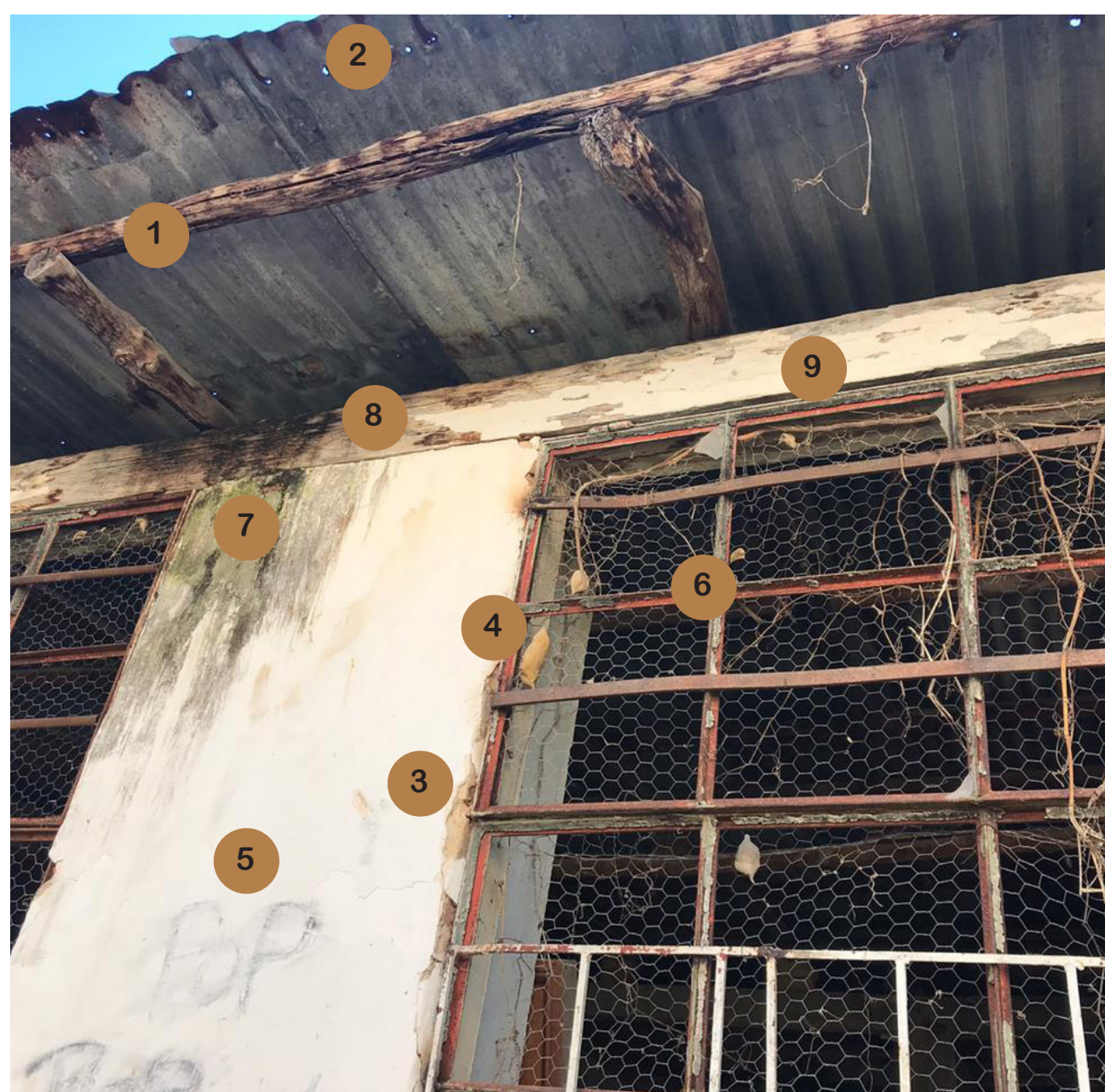
3. EDIFICIO DE COSTURA (FOTO GENERAL - FACHADA POSTERIOR)
