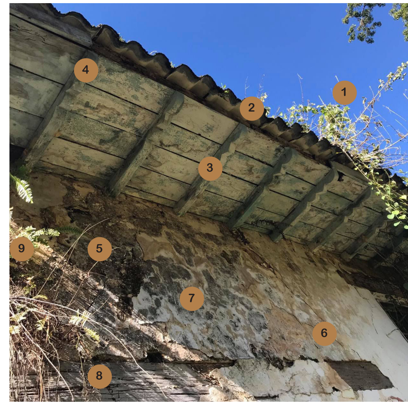
2. EDIFICIO DE HILADOS (FOTO DETALLE)
