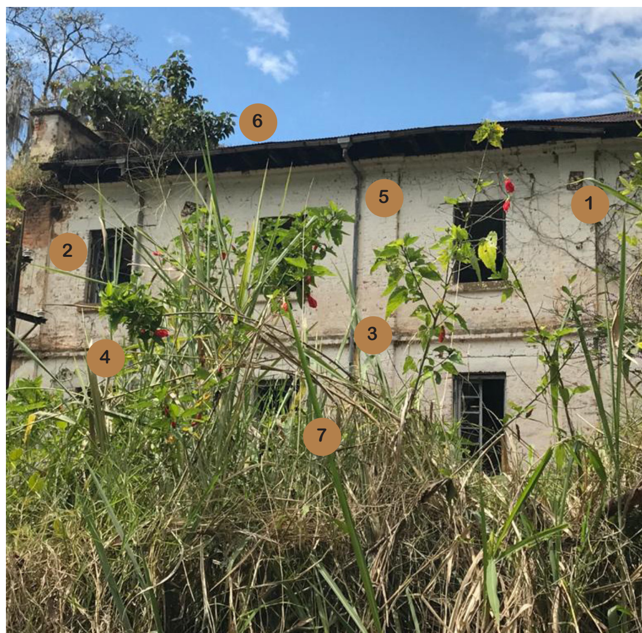
1. EDIFICIO DE ADMINISTRACIÓN (FOTO DETALLE)
