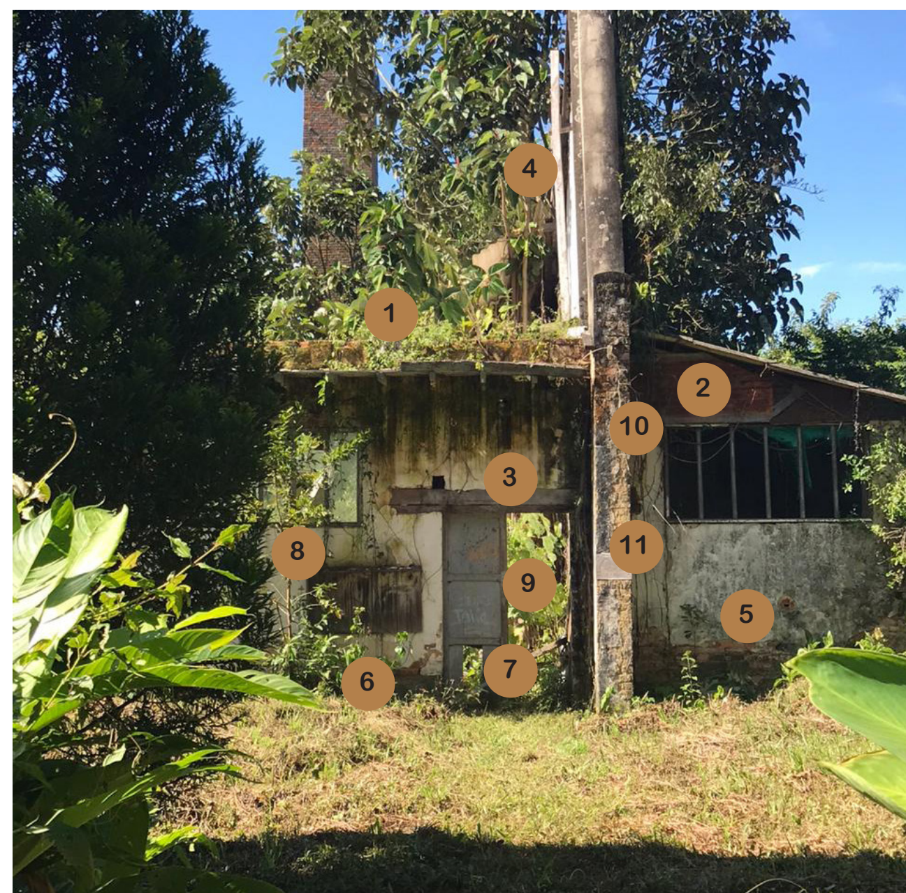
2. EDIFICIO DE HILADOS (FOTO DETALLE)
