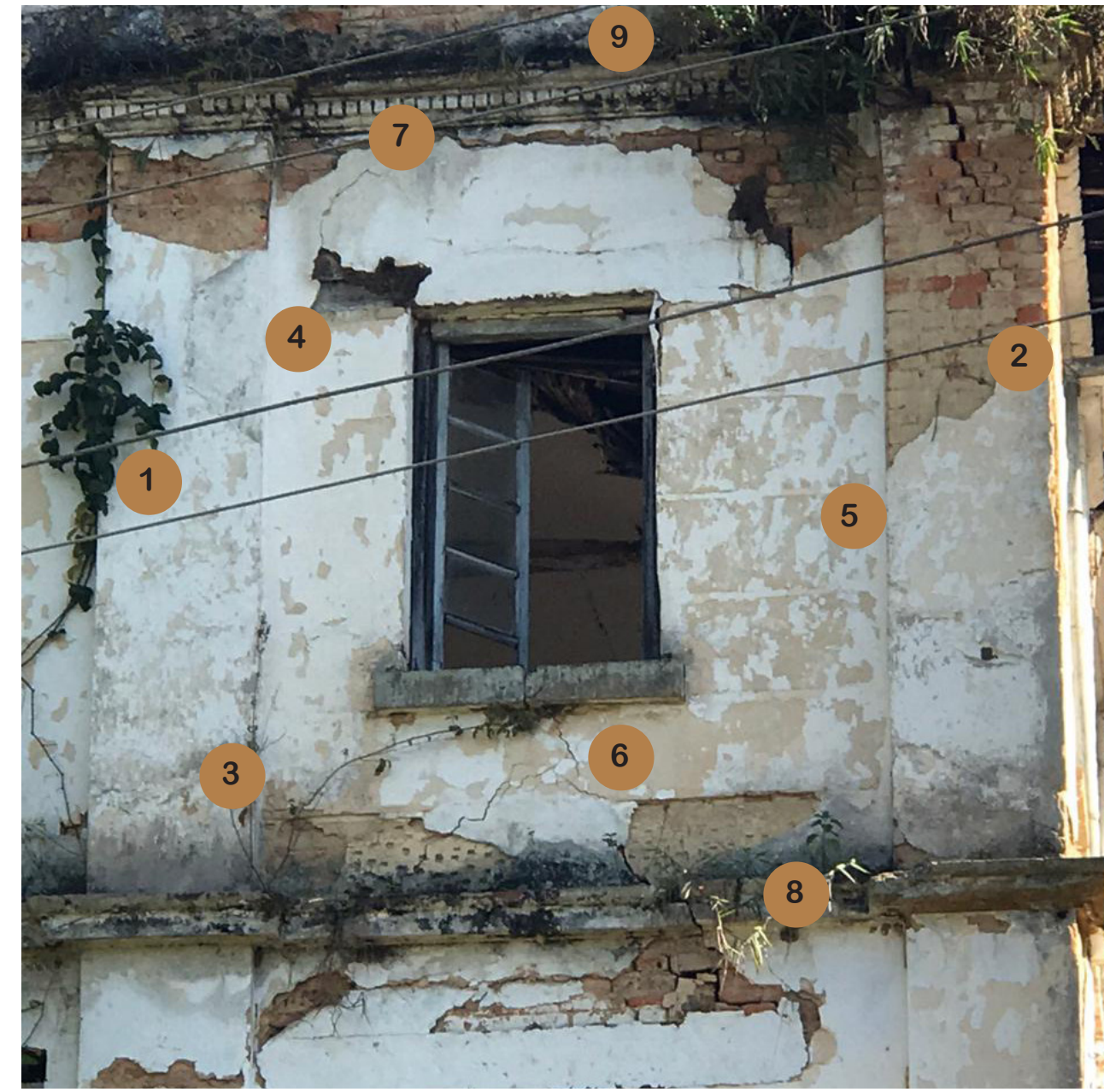
1. EDIFICIO DE ADMINISTRACIÓN (FOTO DETALLE)
