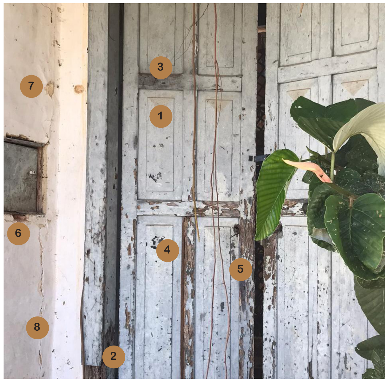
1. EDIFICIO DE ADMINISTRACIÓN (FOTO DETALLE MADERA - PUERTA PRINCIPAL)
