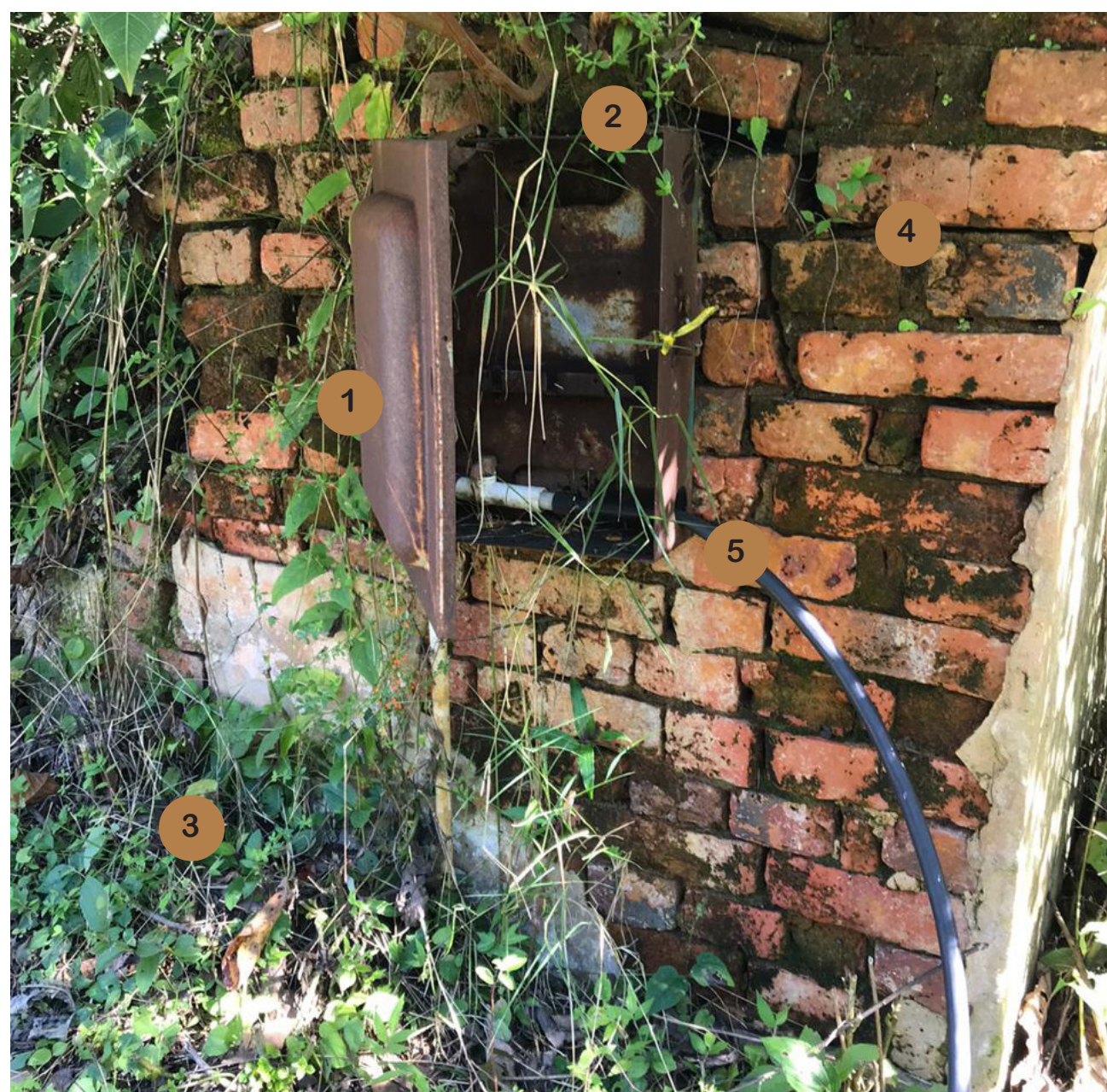
2. EDIFICIO DE HILADOS (FOTO GENERAL - FACHADA POSTERIOR)
