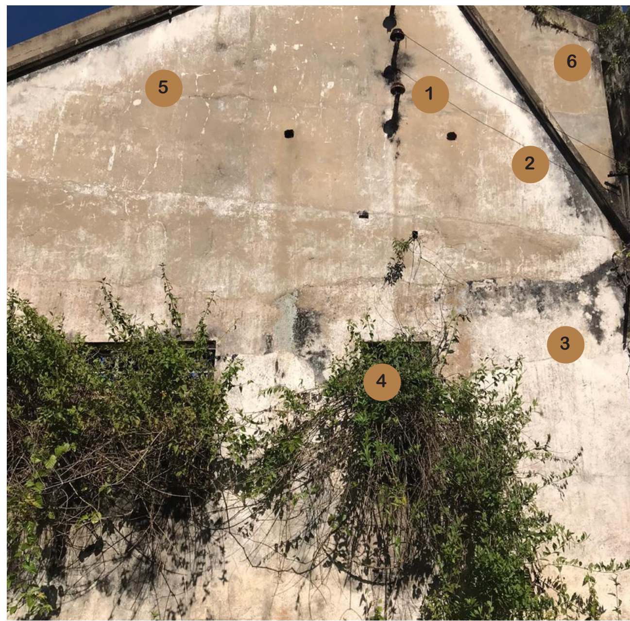
2. EDIFICIO DE HILADOS (FOTO DETALLE)
