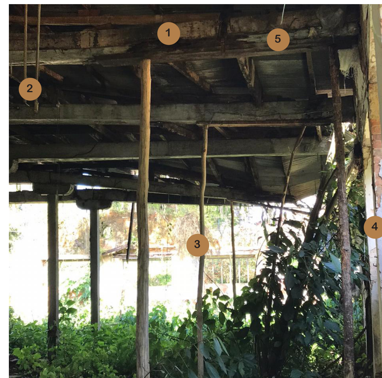
3. EDIFICIO DE COSTURA (FOTO DETALLE - INTERIOR)
