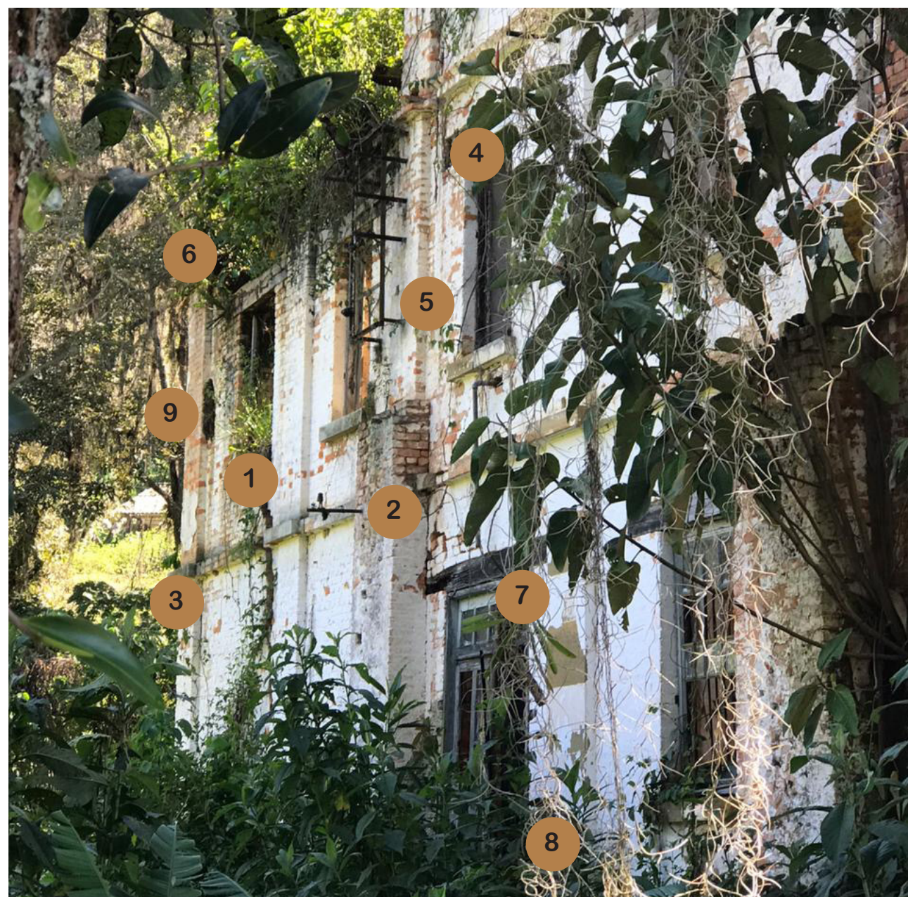
1. EDIFICIO DE ADMINISTRACIÓN (FOTO DETALLE)
