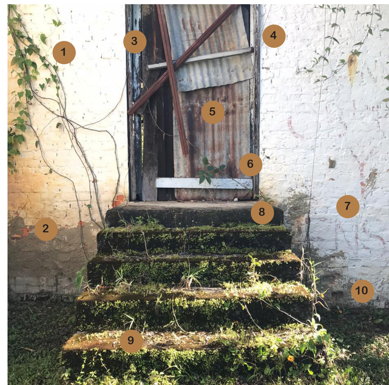
1. EDIFICIO DE ADMINISTRACIÓN (FOTO DETALLE)
