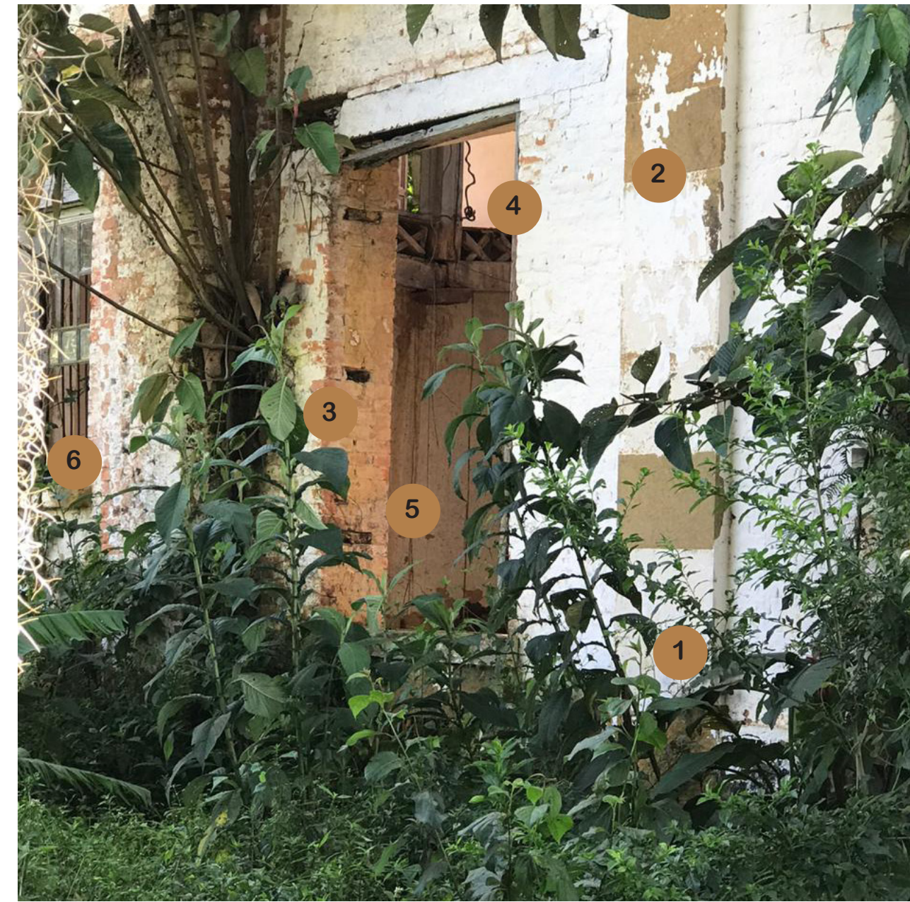
1. EDIFICIO DE ADMINISTRACIÓN (FOTO DETALLE)
