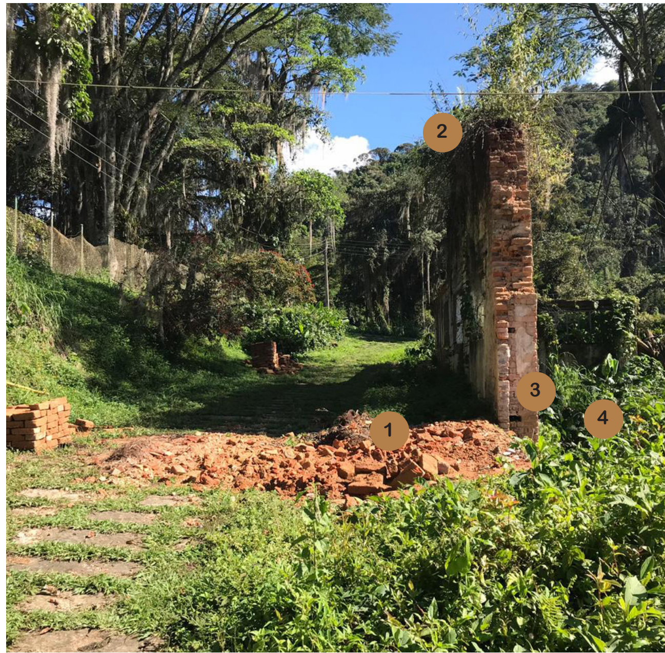
3. EDIFICIO DE COSTURA (FOTO GENERAL - FACHADA LATERAL DERECHA)
