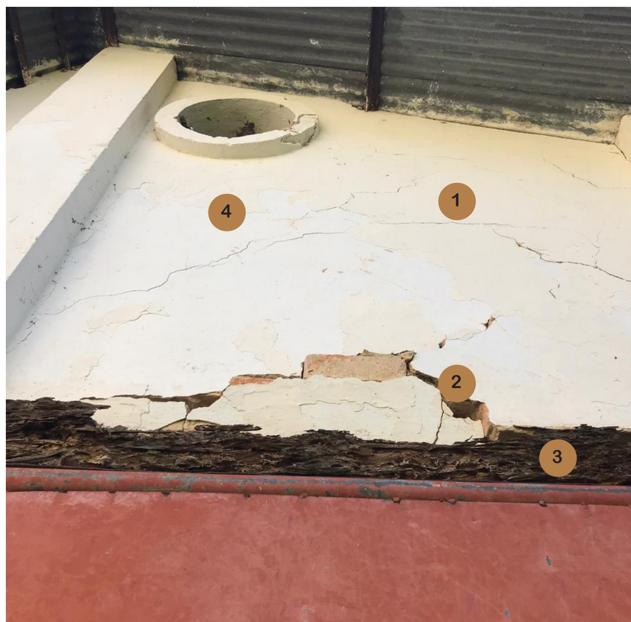
5. EDIFICIO DE ALMACENAMIENTO No. 1 (FOTO DETALLE)
