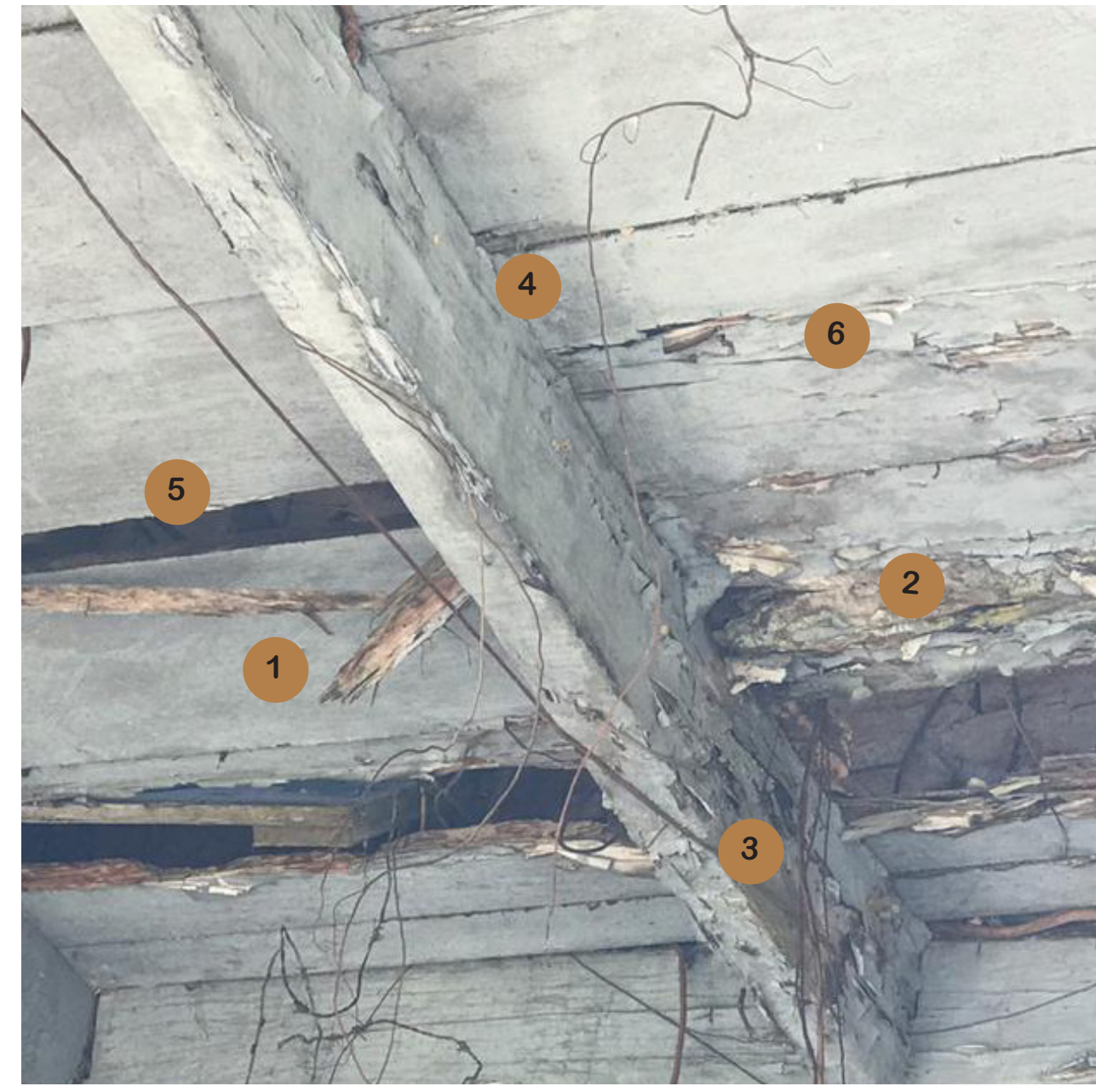
1. EDIFICIO DE ADMINISTRACIÓN (FOTO DETALLE MADERA - VIGAS)
