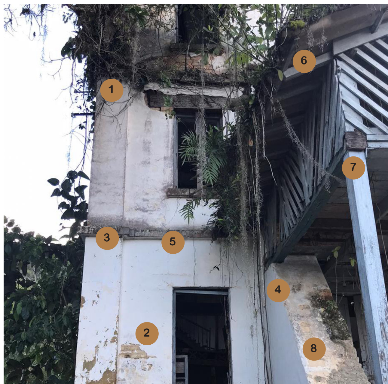
1. EDIFICIO DE ADMINISTRACIÓN (FOTO DETALLE)
