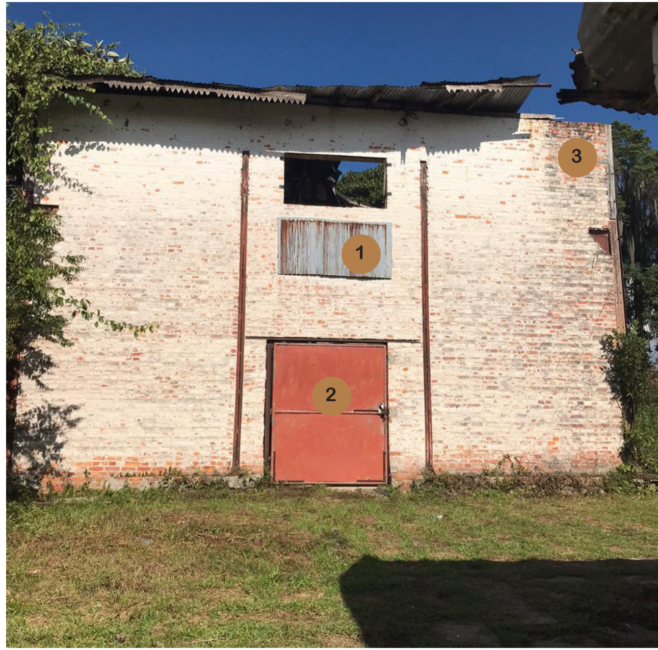
4. EDIFICIO - TIENDA DE ALGODÓN (FOTO GENERAL - FACHADA FRONTAL)
