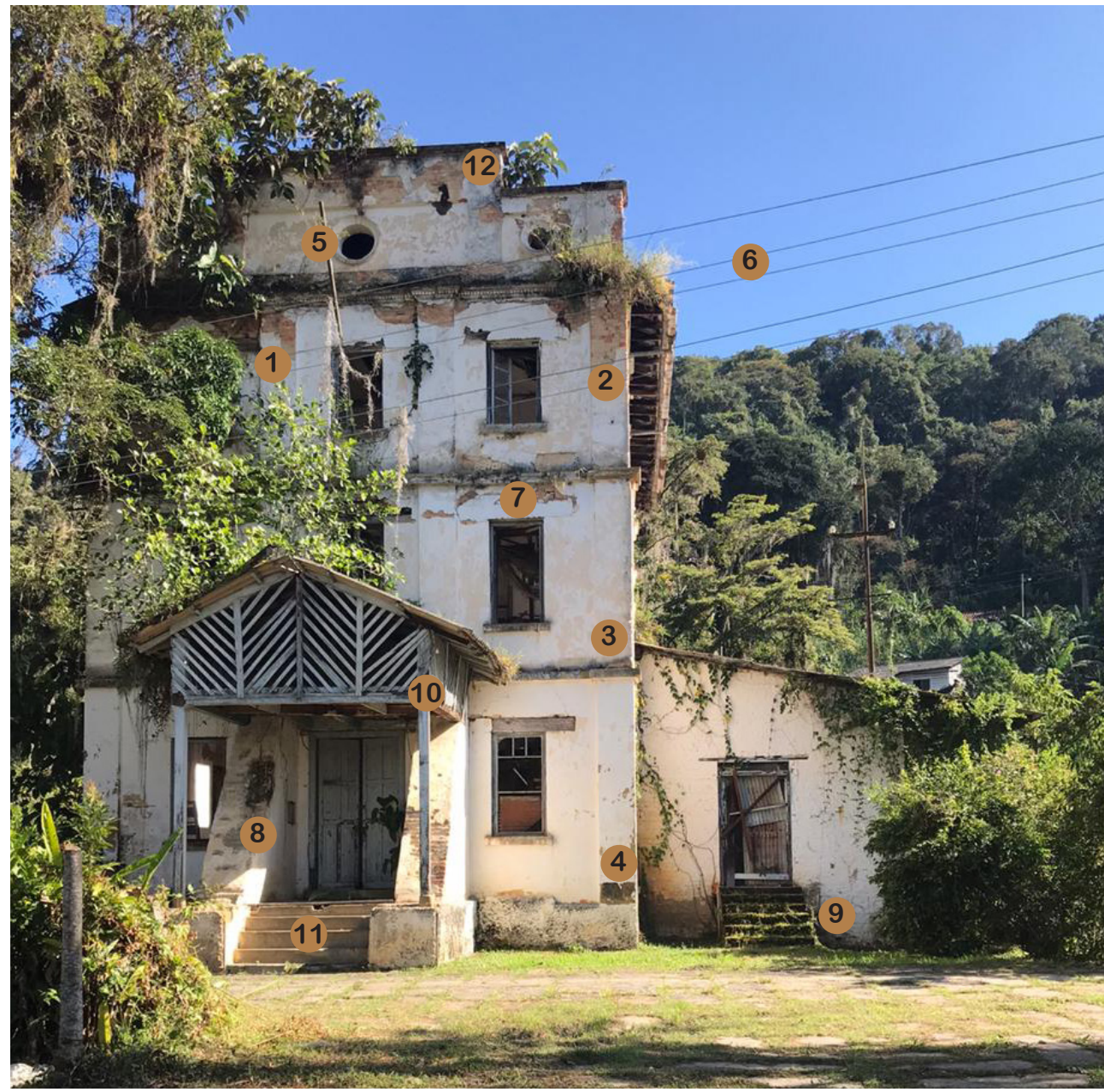
1. EDIFICIO DE ADMINISTRACIÓN (FOTO GENERAL - FACHADA FRONTAL)
