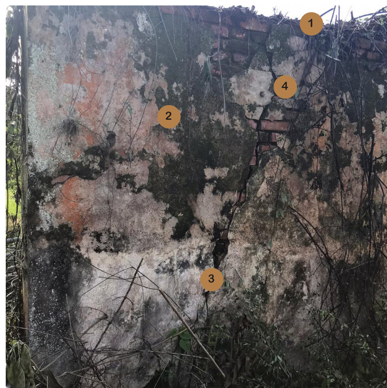
6. EDIFICIO DE ALMACENAMIENTO No. 2 (FOTO GENERAL - FACHADA LATERAL DERECHA)
