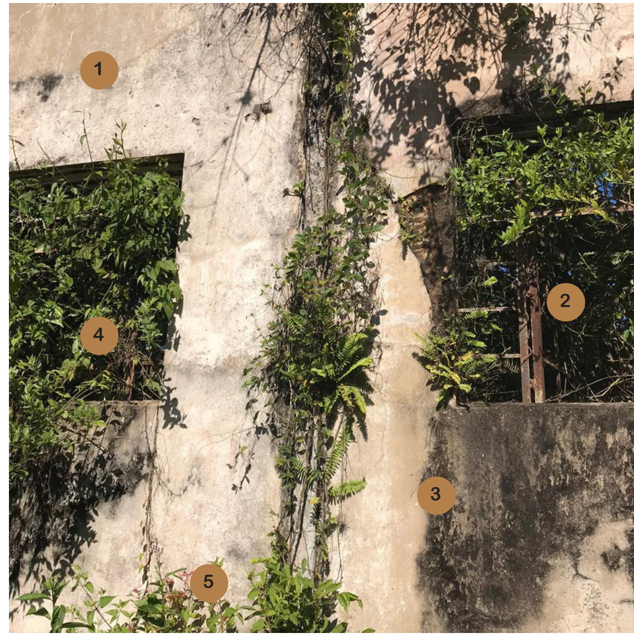
2. EDIFICIO DE HILADOS (FOTO DETALLE)
