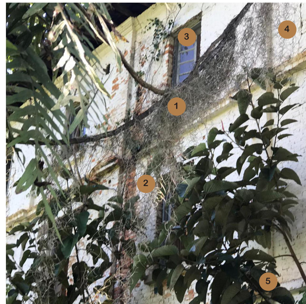
1. EDIFICIO DE ADMINISTRACIÓN (FOTO DETALLE)
