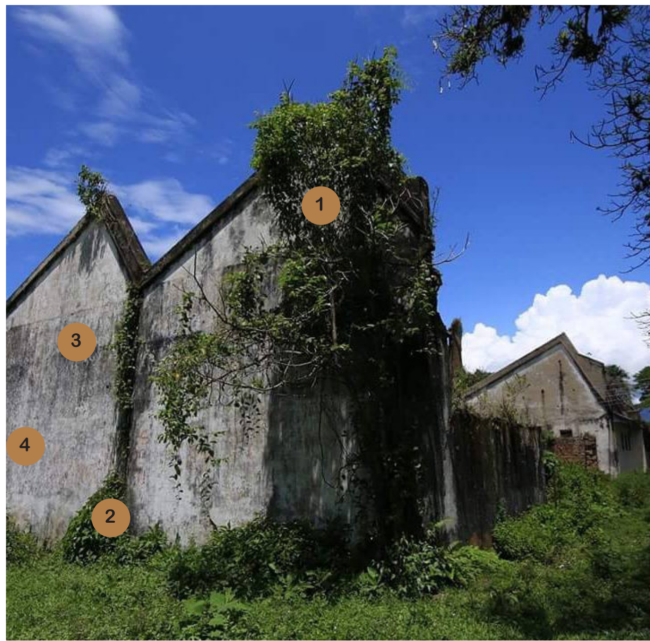
6. EDIFICIO DE ALMACENAMIENTO No. 2 (FOTO GENERAL - FACHADA LATERAL IZQUIERDA)
