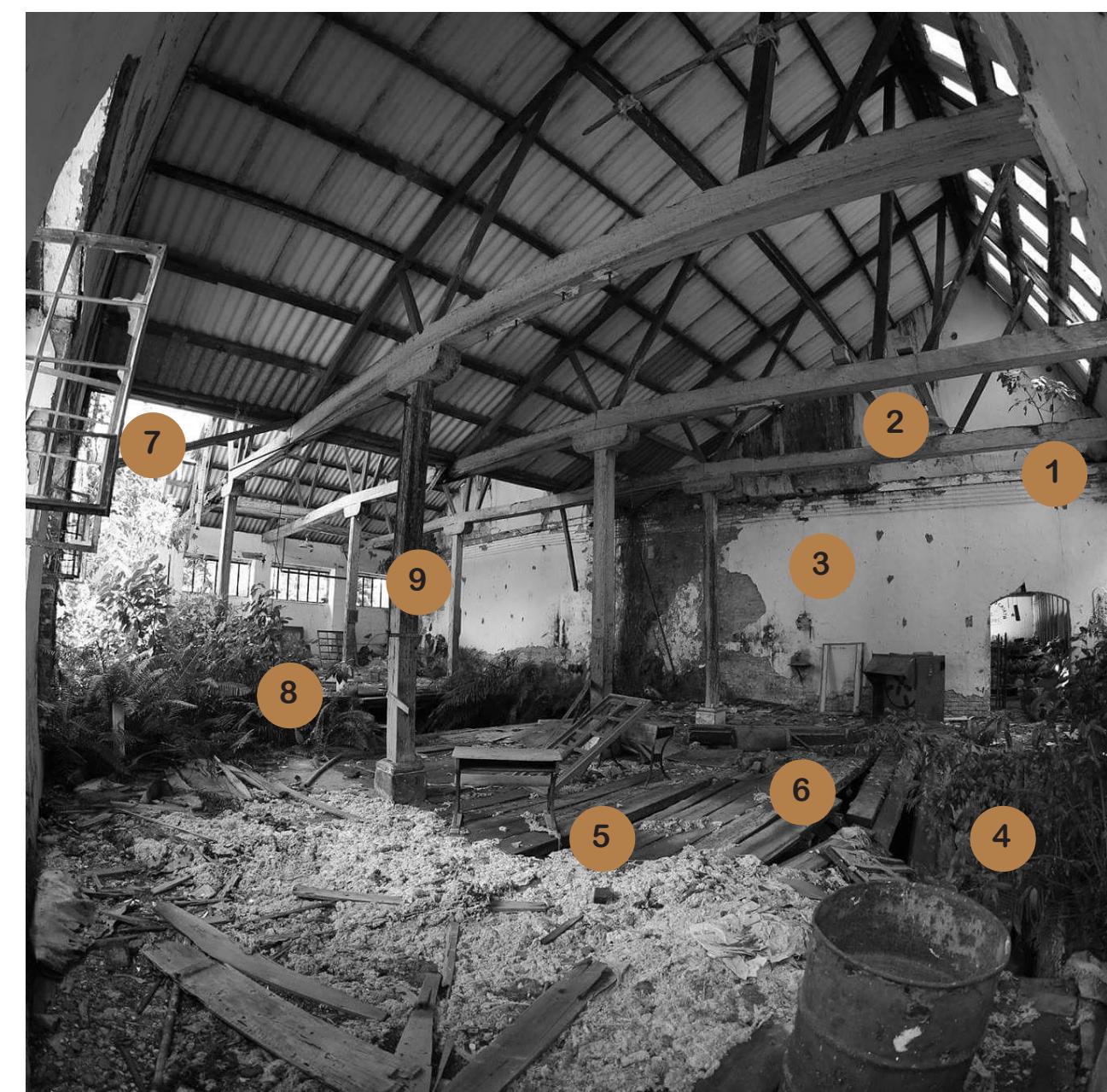
2. EDIFICIO DE HILADOS (FOTO DETALLE - INTERIOR)
