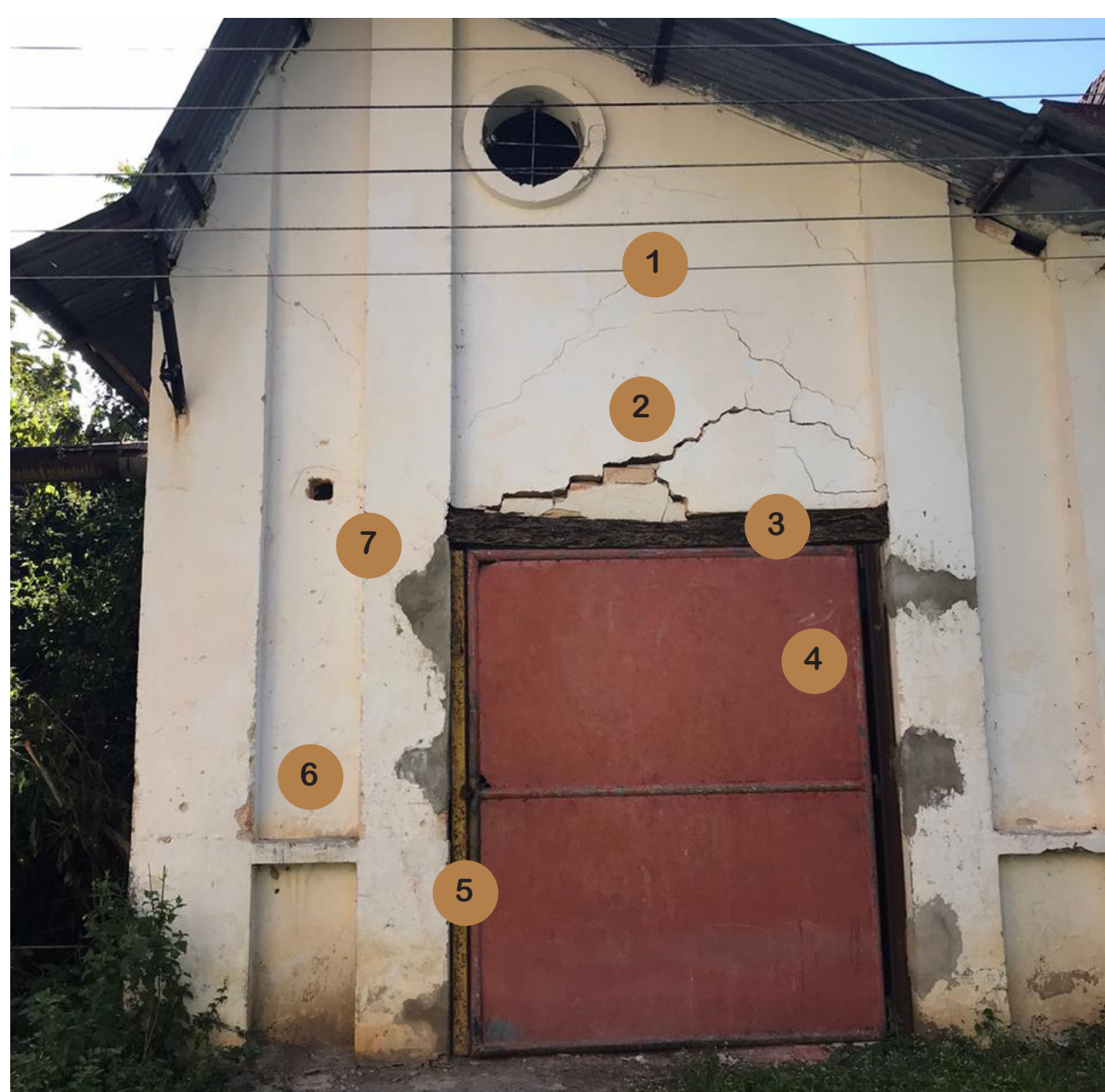
5. EDIFICIO DE ALMACENAMIENTO No. 1 (FOTO DETALLE)
