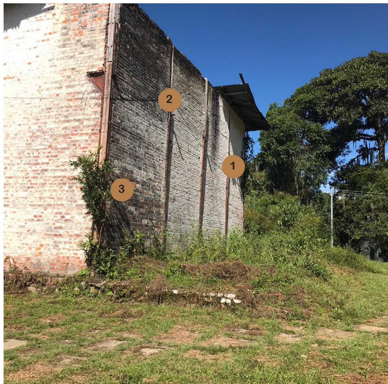
4. EDIFICIO - TIENDA DE ALGODÓN (FOTO DETALLE)
