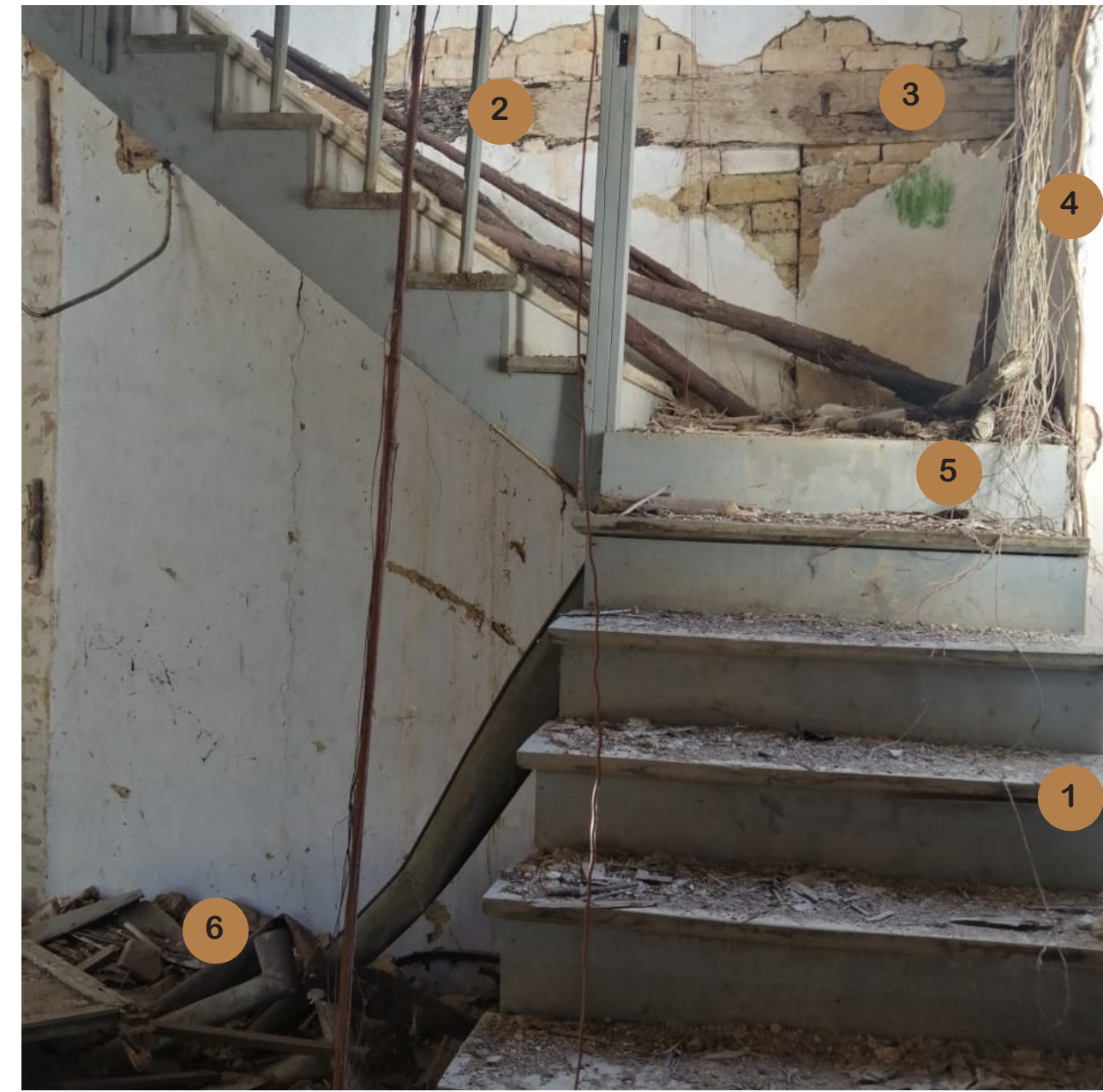
1. EDIFICIO DE ADMINISTRACIÓN (FOTO DETALLE ESCALERAS - INTERIOR)
