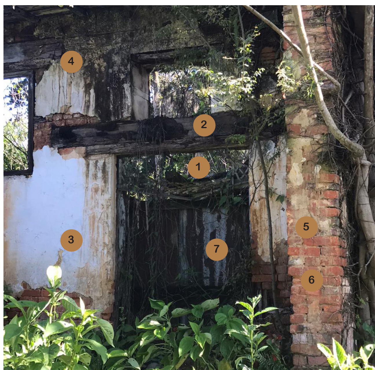
2. EDIFICIO DE HILADOS (FOTO DETALLE)
