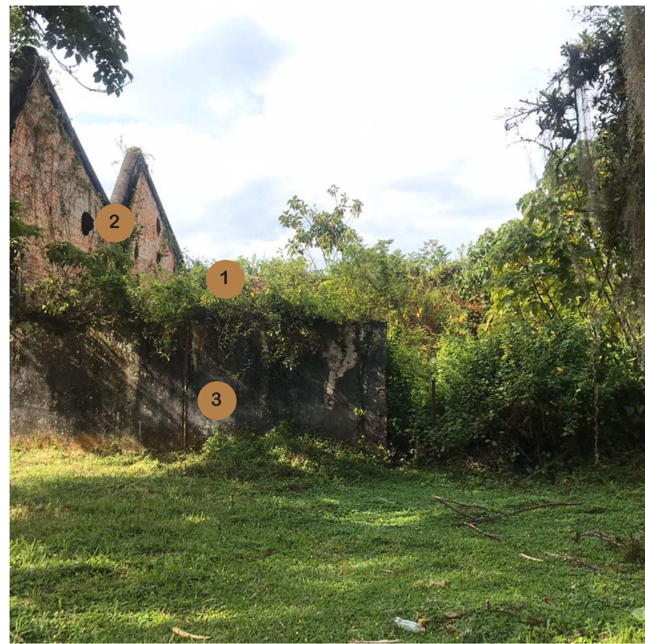
6. EDIFICIO DE ALMACENAMIENTO No. 2 (FOTO GENERAL - FACHADA FRONTAL)
