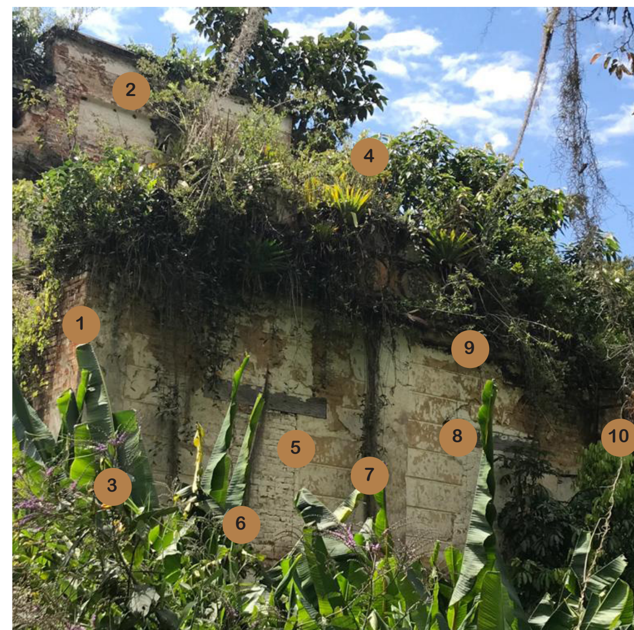
1. EDIFICIO DE ADMINISTRACIÓN (FOTO GENERAL - FACHADA POSTERIOR)
