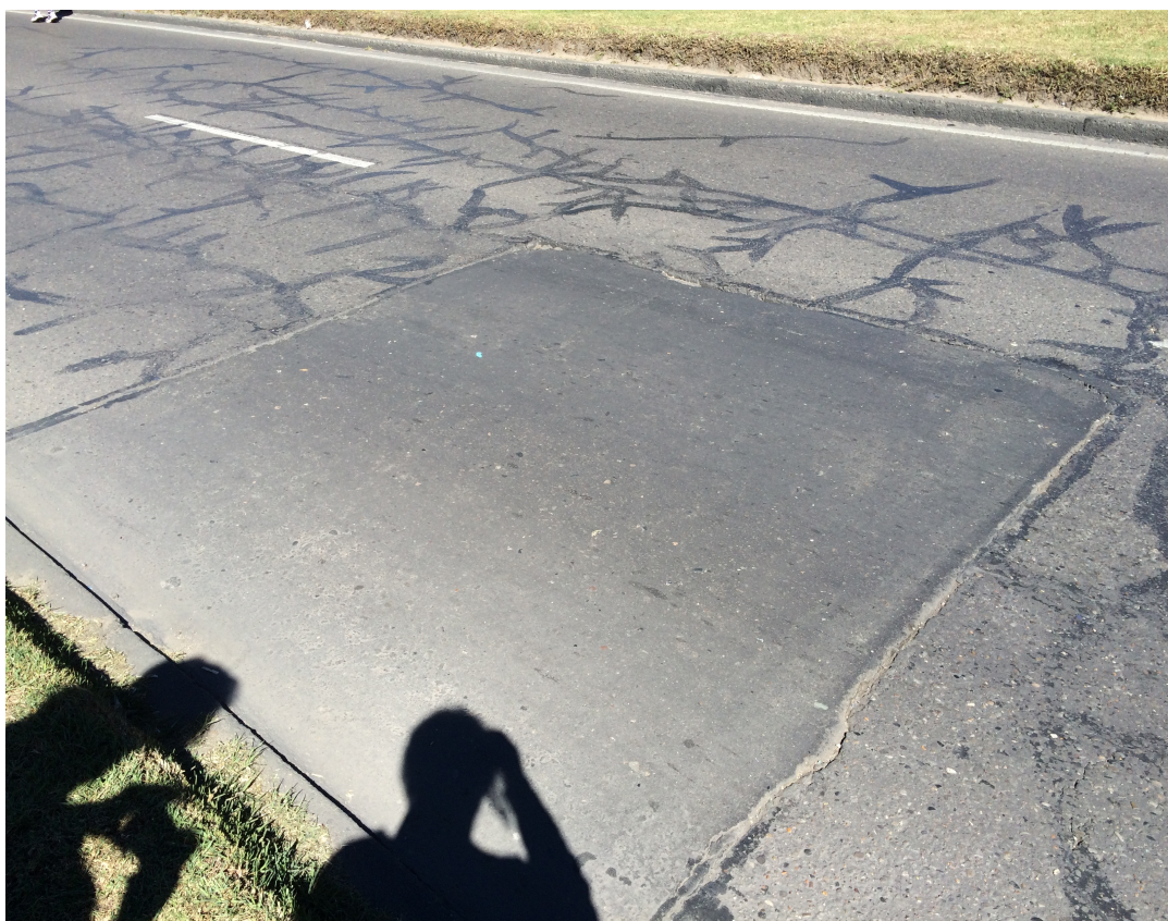
(Discontinuidad de pavimento)
