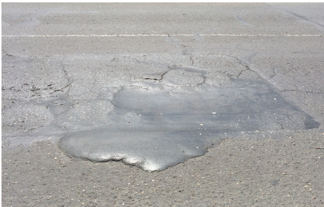
(Discontinuidad de pavimento)
