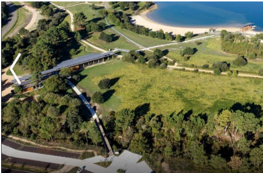
Figura 6: aerofotografía del proyecto. Implantación del proyecto respecto a caminos existentes y configuración del entorno. Tomado de: Castes, N. (2017) Referencia: “Reserva Natural Arjuzanx/Inca Architectes + ALEP Landscape. Anónimo, (2017). Recuperado de: https://www.archdaily.co/868245/reserva-natural-arjuzanx-inca-architectes-plus-alep-landscape
