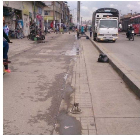
IMAGEN 16 Ausencia del tablero Carrera 86 A - 38 c y Ausencia del soporte Señal SR-02 Señalspc-01 Av. Cali n 38 d -35
