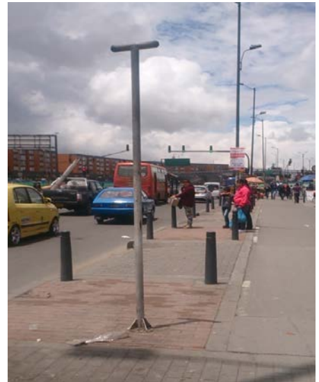
IMAGEN 22 Uso de la SRB-37 y Ausencia de tablero SR-02
