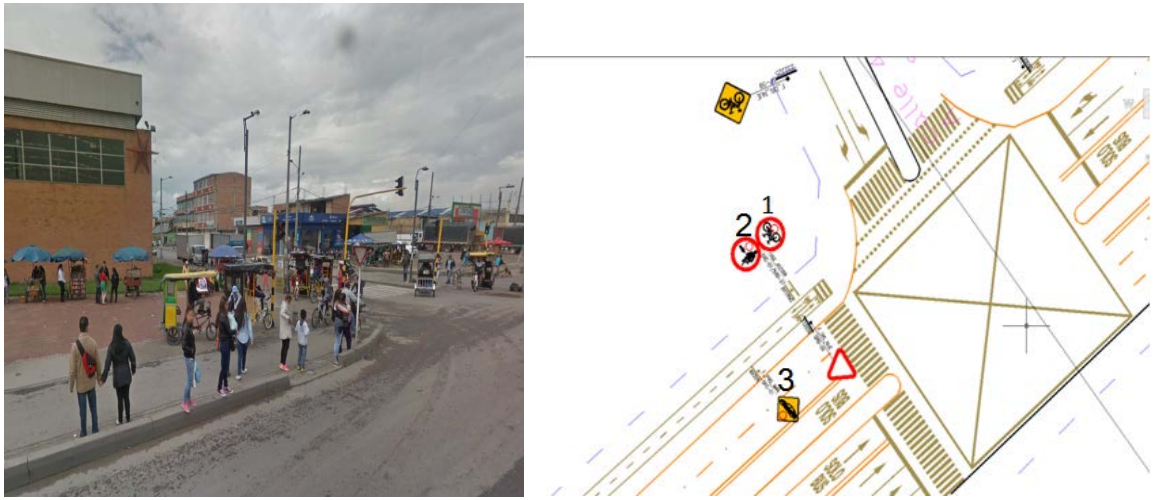
IMAGEN 18 Aproximacion al cruce de la calle 42 A sur
