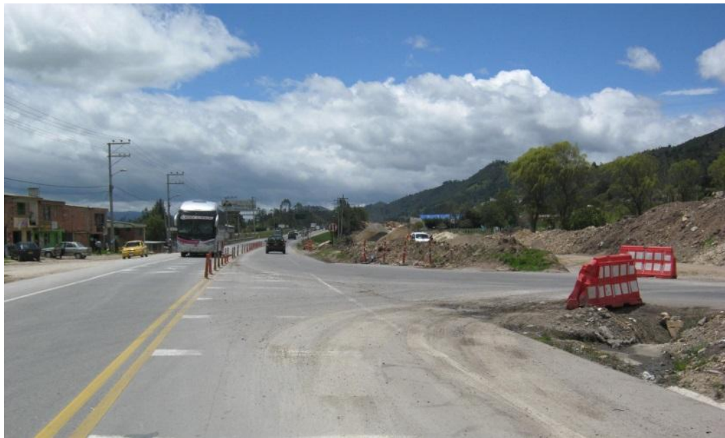
Figura 18 PC1b Tránsito a altas velocidades en zona de mantenimiento en la vía.
