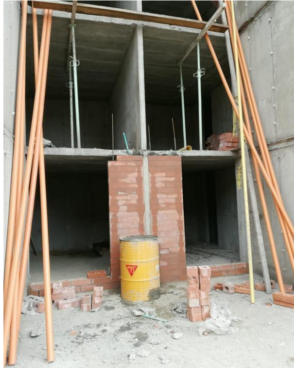
Ilustración 11 Proyecto Manzanares Hacienda Madrid. Se puede ver que en la construcción y levantamiento de un muro se comparte con los tubos de PVC como almacenamiento de estos. Adaptado de estudiante Baquero Luz.
