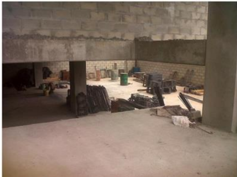
Ilustración 7 El acero que se va a utilizar para armar la cimentación y columnas se encuentra almacenada dentro de la estructura, interfiriendo para la actividad de acabados. Tomado de “Estudio de la planificación del almacenamiento de materiales de construcción en Bucaramanga” por José Alberto Benavides Cadena, 2015. Recuperado de https://repository.usta.edu.co/handle/11634/887
