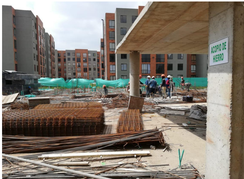
Ilustración 9 Proyecto Manzanares Hacienda Madrid. El acero de las parrillas para fundir los entresijos se encuentra a la exposición del sol y el agua, compartiendo espacio junto con los desperdicios de este. Adaptado de estudiante Baquero Luz.
