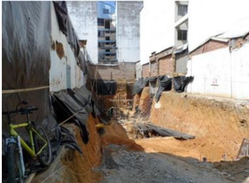
Ilustración 5 Estudio de la planificación del almacenamiento de materiales de construcción en Bucaramanga. La imagen muestra claramente la ausencia de un acopio en el campamento. Recuperado de https://repository.usta.edu.co
