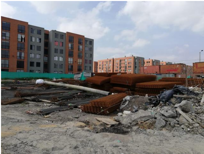
Ilustración 10 Proyecto Manzanares Hacienda Madrid. Se evidencia una falencia en la administración del acero con de los desechos y desperdicios, falta de organización y exposición. Adaptado de estudiante Baquero Luz.
