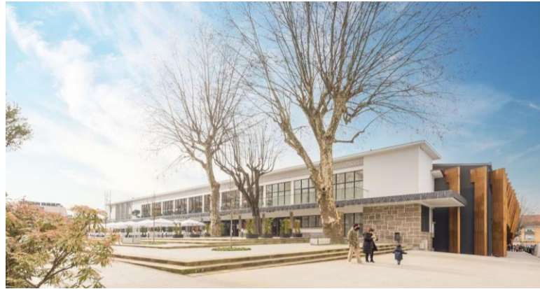
Fotografía exterior del Mercado de Braga
