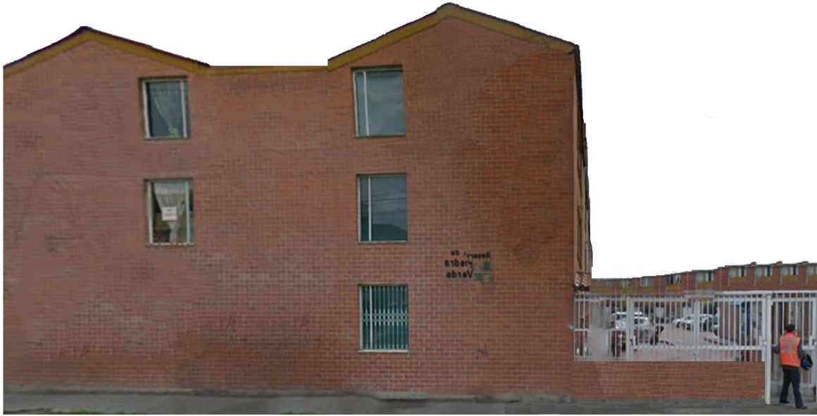
Figura 34 fachada sobre el corredor ambiental y cultural, Fuente Alejandro Salazar
