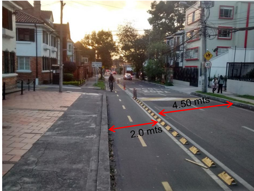
Figura N° 33: Intersección Tramo II
