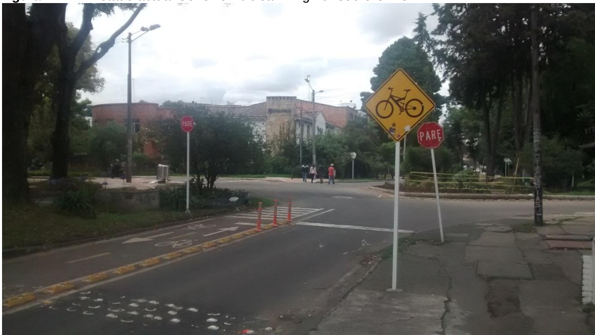
Figura N° 41: Estado actual Conexión bicicarriil Dg 40ª sobre Cr 18
