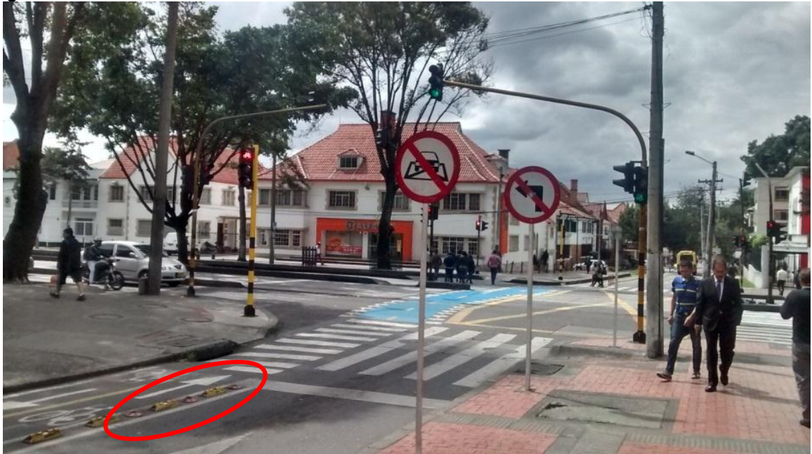
Figura N° 19: Tramo I estado Señalización.
