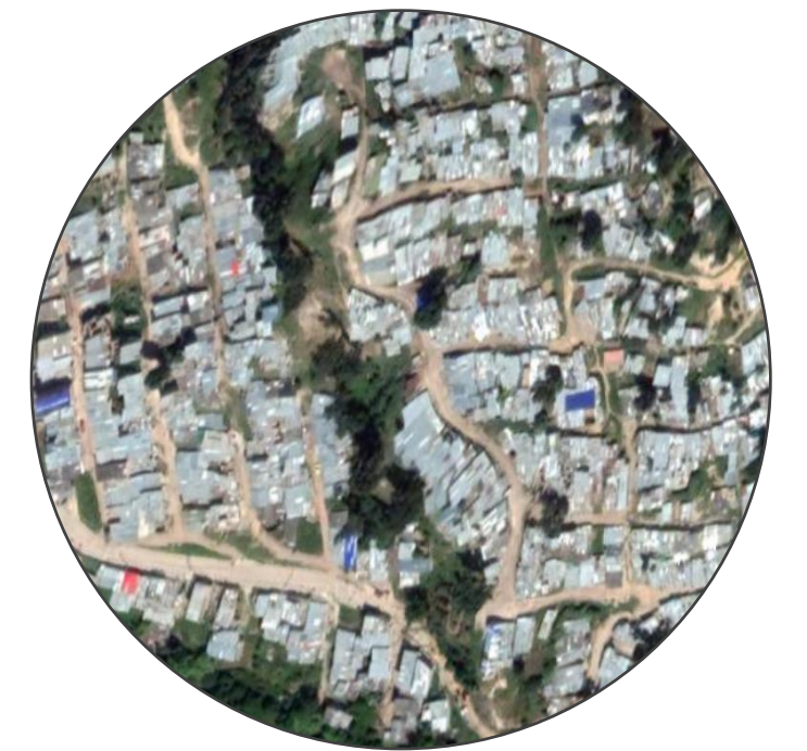
DISPOSICIÓN DESORDENADA DE MALLA
