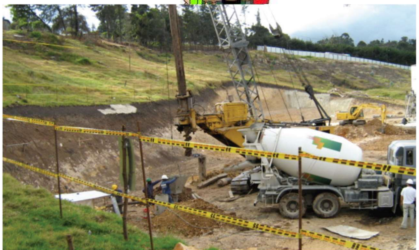
Fuente: Tomada por los autores Colpatría Portón De Santo Domingo Bogotá 2010 Vaciado De Concreto
