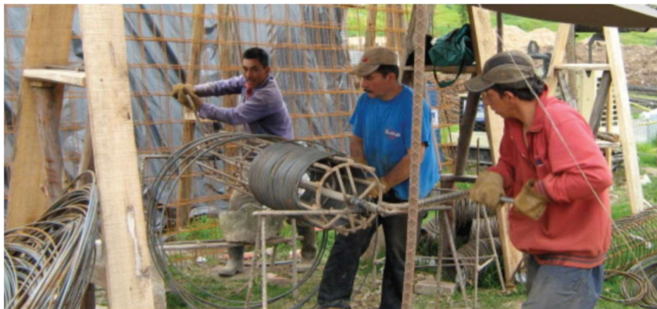
FIGURA 25 Fuente: Tomada por los autores Colpatría Portón De Santo Domingo Bogotá 2010 Fabricación De Espiral Para Canastas
