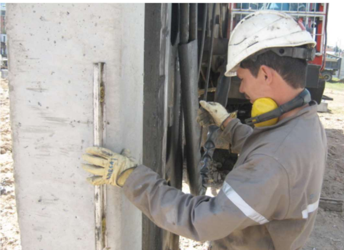
Fuente: Tomada por los autores Colpatría Torres De Santa Lucía I Bogotá 2010 Nivelación Y Verticalidad De Pilotes Antes Y Durante La Hinca
