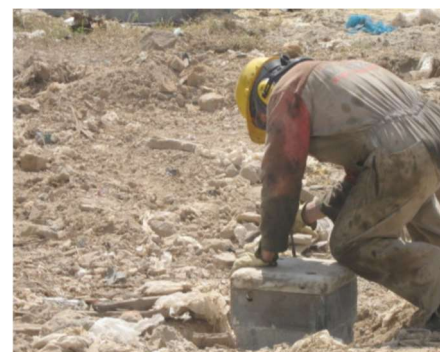
Fuente: Tomada por los autores Colpatria Torres De Santa Lucia I Bogotá 2010 Transporte De Pilotes
