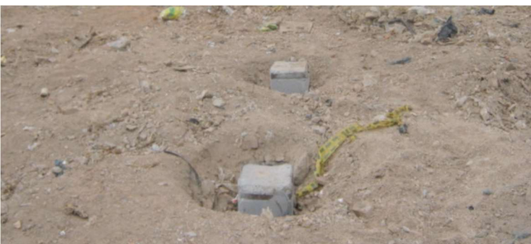
Fuente: Tomada por los autores Colpatría Torres De Santa Lucía I Bogotá 2010 Pilote Hincado
