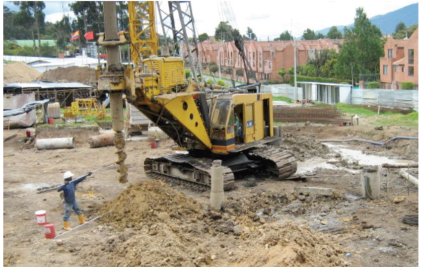
Fuente: Tomada por los autores Colpatría Portón De Santo Domingo Bogotá 2010 Uso De Broca
