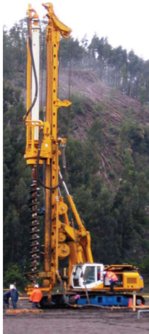
Fuente: Fundaciones Y Pilotajes Máquina Para Pilote De Hélice Continua
