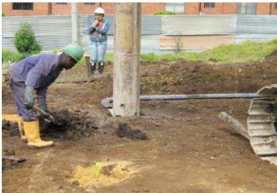
Fuente: Tomada por los autores Colpatría Portón De Santo Domingo Bogotá 2010 Retiro De Arena De Pre Hueco Inicio De Excavación
