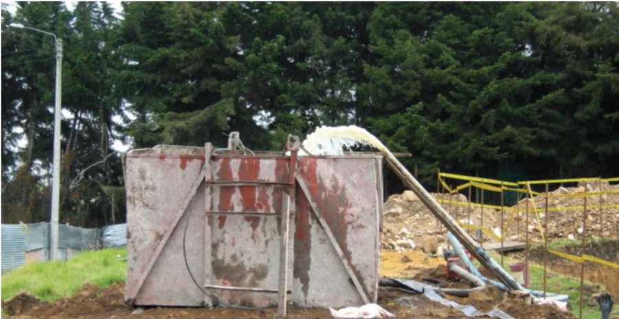
Fuente: Tomada por los autores Colpatría Portón De Santo Domingo Bogotá 2010 Tanques De Agua
