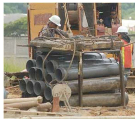
Fuente: Tomada por los autores Oeste de Granada Bogotá 2016 Tubería tremie
