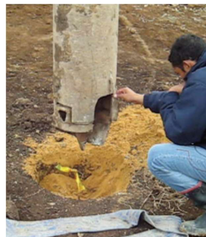
Fuente: Tomada por los autores Colpatría Portón De Santo Domingo Bogotá 2010 Plomar El Balde Con El Centro Del Pilote
