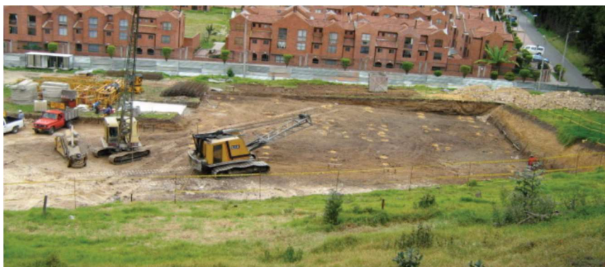
FIGURA 22 Fuente: Tomada por los autores Colpatría Portón De Santo Domingo Bogotá 2010
