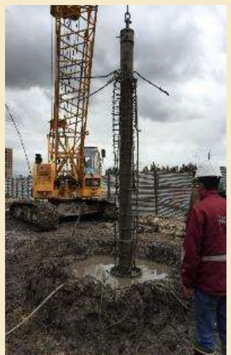
Fuente: Tomada por los autores Oeste de Granada Bogotá 2016 Canasta Atrapada Con La Tubería
