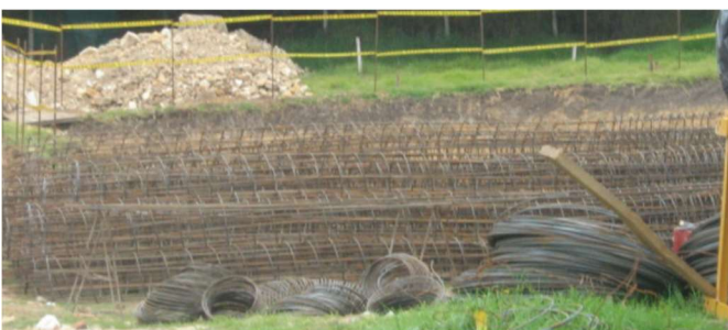
Fuente: Tomada por los autores Colpatría Portón De Santo Domingo Bogotá 2010 Canastas Pilotes Pre Excavados
