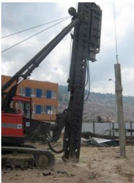
Fuente: Tomada por los autores Colpatria Torres De Santa Lucia I Bogotá 2010 Martinete
