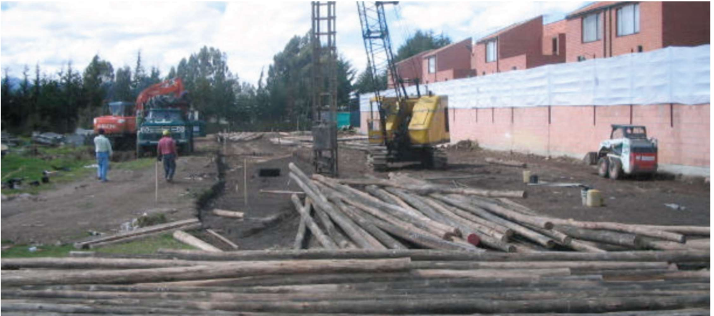
Fuente: Tomada por los autores Colpatría propia Colina de San Fernando Bogotá 2010 Alistamiento pilotes de madera
