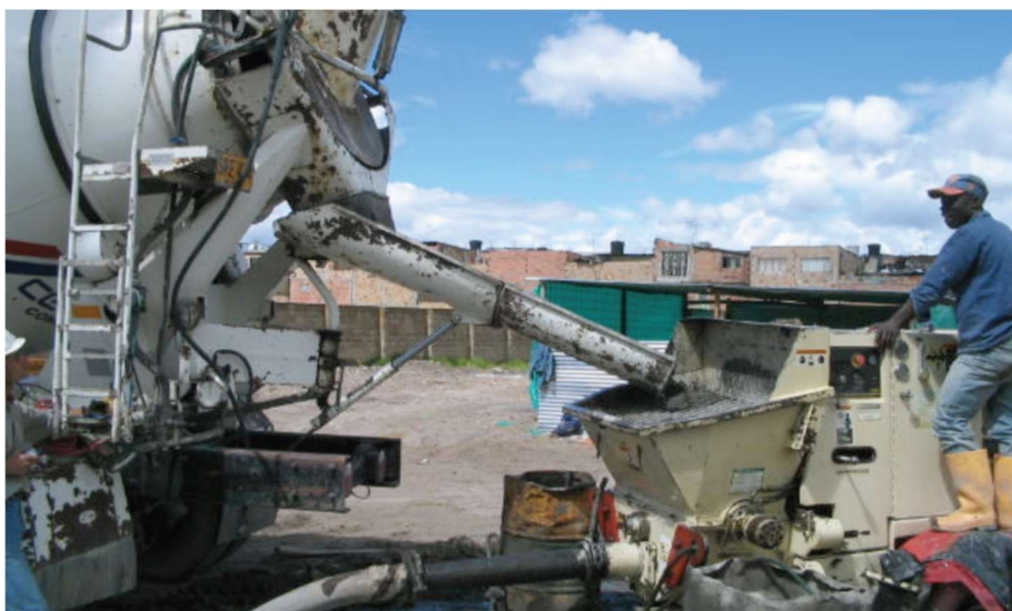
Fuente: Tomada por los autores Colpatria Torres De Santa Lucia II Bogotá 2012 Descargue A La Bomba Estacionaria
