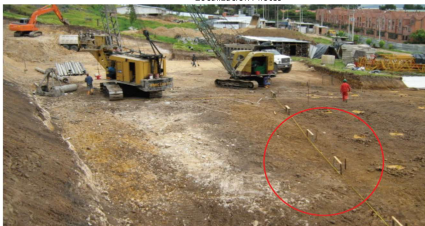
FIGURA 23 Fuente: Tomada por los autores Colpatría Portón De Santo Domingo Bogotá 2010
