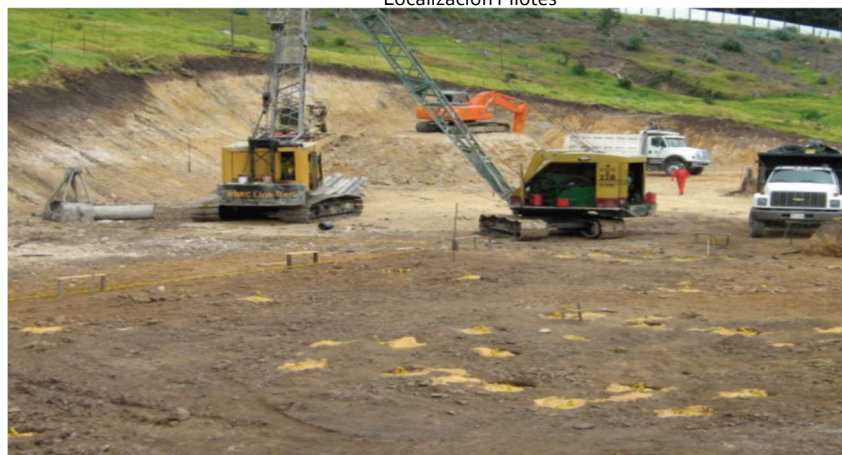
FIGURA 24 Fuente: Tomada por los autores Colpatría Portón De Santo Domingo Bogotá 2010
