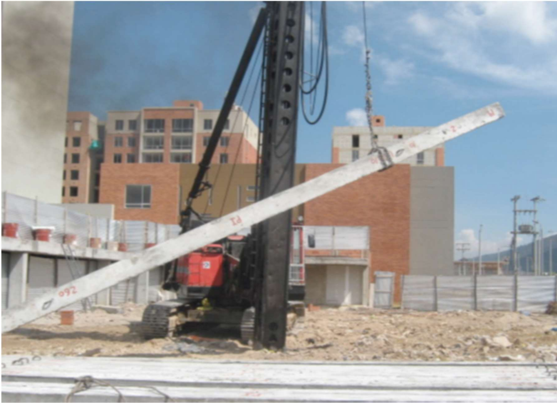
Fuente: Tomada por los autores Colpatría Torres De Santa Lucía I Bogotá 2010 Alistamiento Para La Hinc
