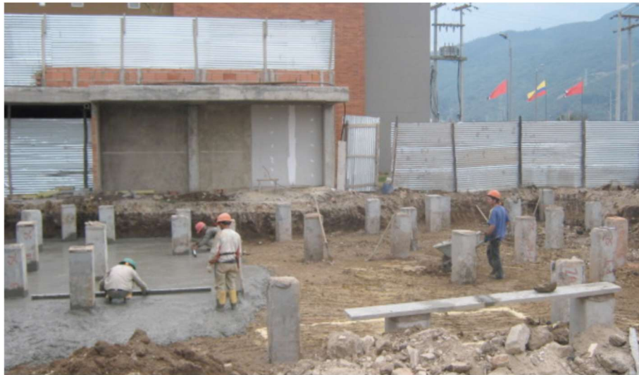
Fuente: Tomada por los autores Colpatria Torres De Santa Lucia I Bogotá 2010 Concreto De Limpieza Antes Del Descabece De Pilotes
