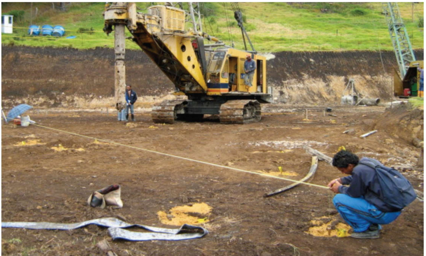
Fuente: Tomada Por Los Autores Portón De Santo Domingo Bogotá 2010 Localización Piloteadora Se hace una verificación de las distancias entre centros de pilote en el pre-hueco antes de iniciar el proceso de excavación.
