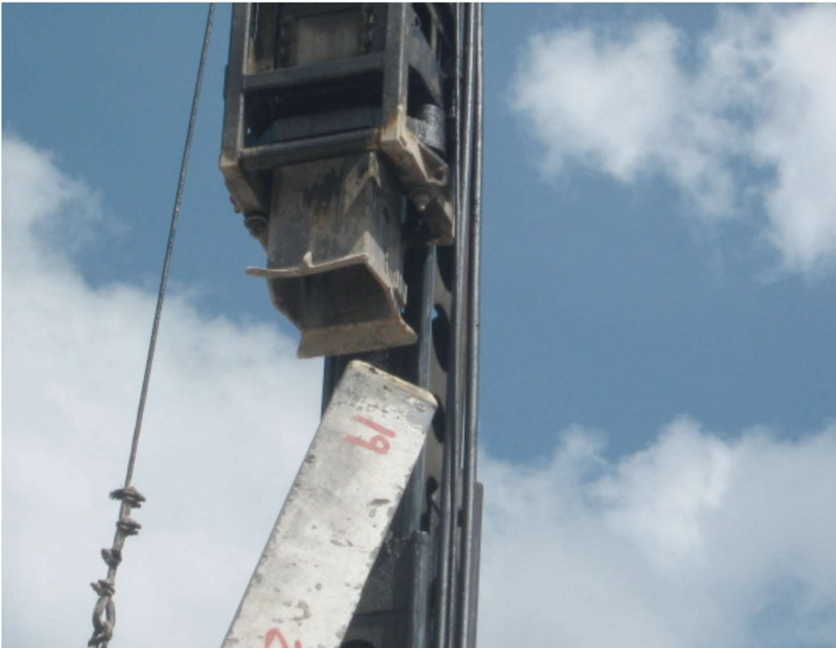
Fuente: Tomada por los autores Colpatría Torres De Santa Lucia I Bogotá 2010 Acople Del Pilotes Con El Martinete
