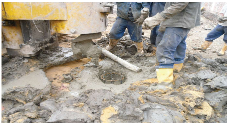
Fuente: Tomada por los autores Colpatría Torres De Santa Lucía II Bogotá 2012 Fin Del Vaciado
