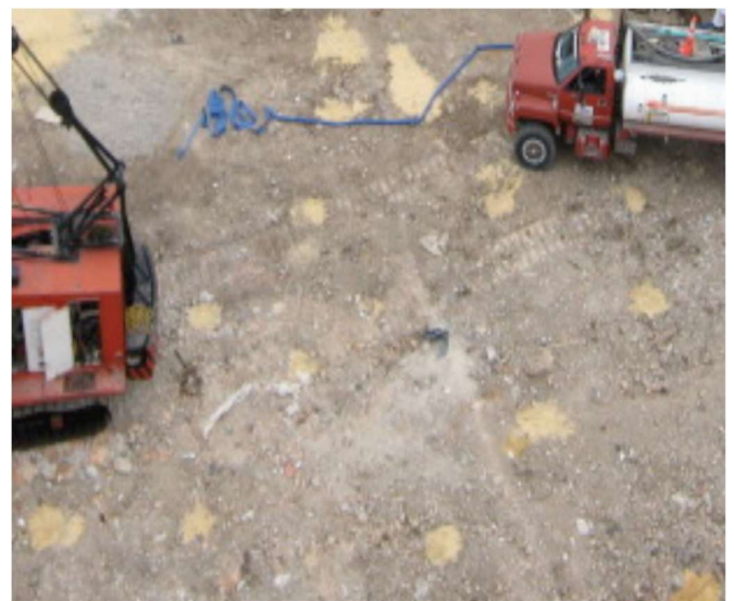
Fuente: Tomada por los autores Colpatria Torres De Santa Lucia II Bogotá 2012 Localización De Pilotes Y Llenados Con Arena
