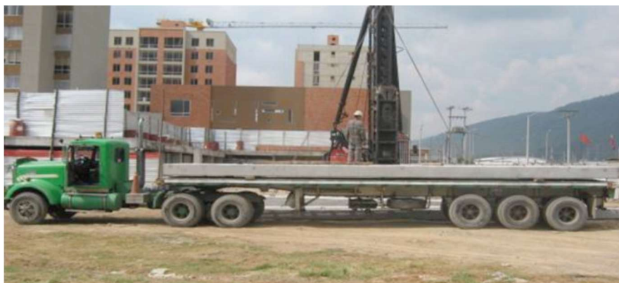
Fuente: Tomada por los autores Colpatria Torres De Santa Lucia I Bogotá 2010 Transporte De Pilotes
