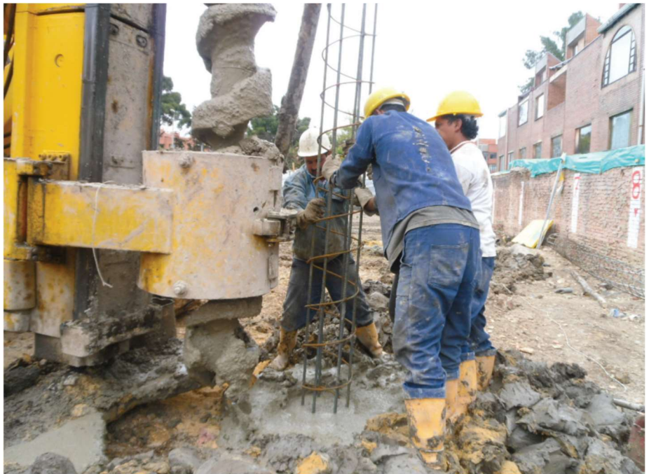
Fuente: Tomada por los autores Colpatría Torres De Santa Lucía II Bogotá 2012 Ingreso De Canasta
