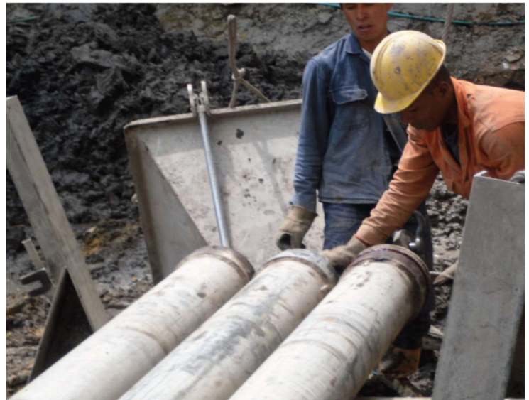
Fuente: Tomada por los autores Colpatría Portón De Santo Domingo Bogotá 2010 Limpieza De Tubería
