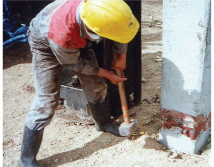
Fuente: Tomada por los autores Colpatría Torres De Santa Lucía I Bogotá 2010 Anclaje De Pernos Y Platinas En Uniones Del Pilote
