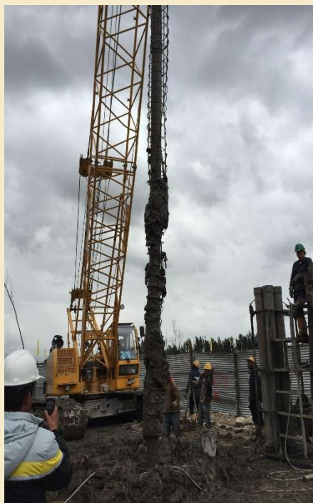
Fuente: Tomada por los autores Oeste de Granada Bogotá 2016 Canasta Atrapada Con La Tubería
