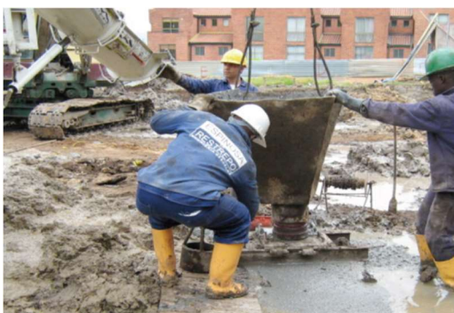
Fuente: Tomada por los autores Oeste de Granada Bogotá 2016 Retiro de tubería
