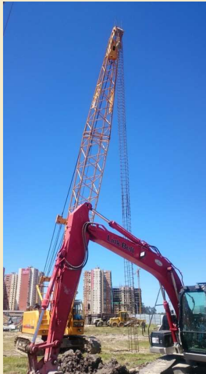
Fuente: Tomada por los autores Oeste de Granada Bogotá 2016 Pilote hélice hasta 30 metros de profundidad - Izaje de canasta
