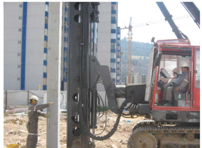
Fuente: Tomada por los autores Colpatría Torres De Santa Lucía I Bogotá 2010 Nivelación Y Verticalidad De Pilotes Antes Y Durante La Hinca
