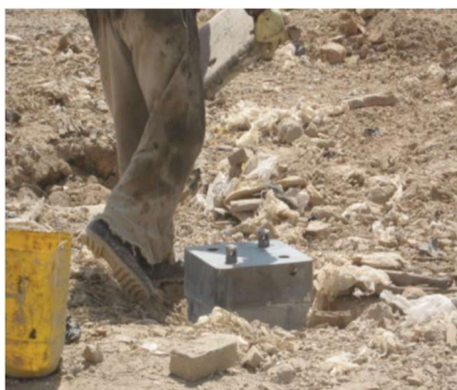
Fuente: Tomada por los autores Colpatria Torres De Santa Lucia I Bogotá 2010 Retiro De Protectores De Cabeza Los Cuales Protegen Durante La Hincia
