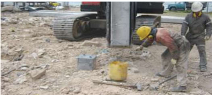
Fuente: Tomada por los autores Colpatría Torres De Santa Lucía I Bogotá 2010 Localización Centro De Pilote
