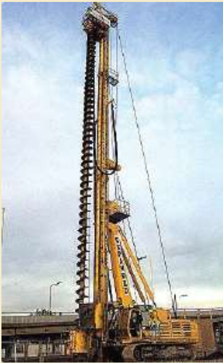
Fuente: Tomada por los autores Oeste de Granada Bogotá 2016 Pilote hélice hasta 30 metros de profundidad - Izaje de canasta
