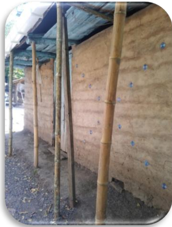
Fuente: Elaboración propia. Pared pañetada con boñiga de caballo
