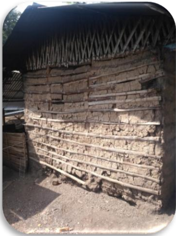
Fuente: Elaboración propia. Pared de bahareque embutido
