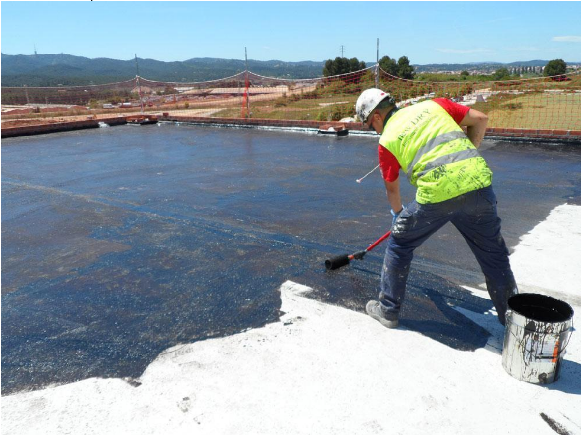
Ilustración 9 Impermeabilización de cubierta
