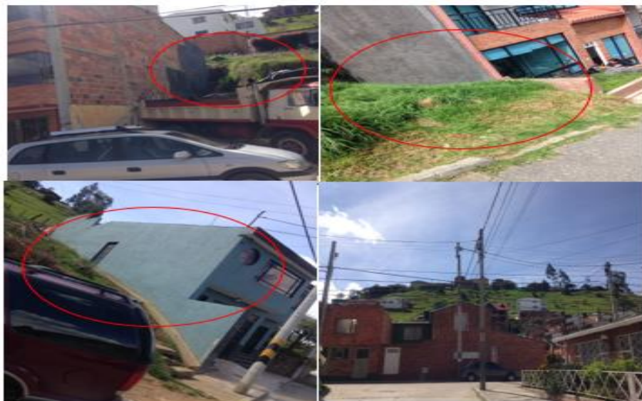
Ilustración 10 Construcciones en altas pendientes
