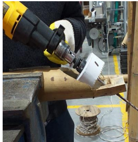
Proceso constructivo - terminación de corte tipo flauta con copa
