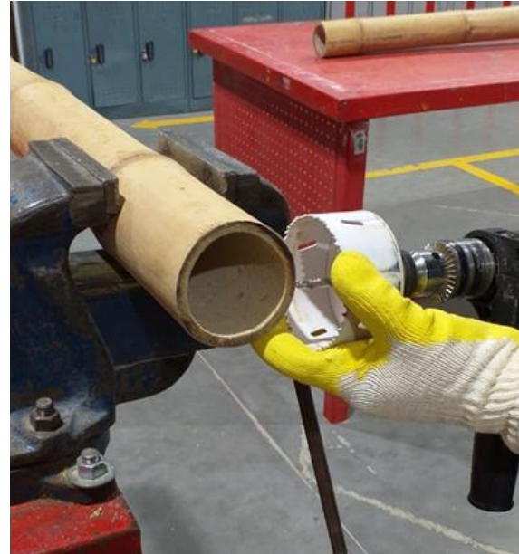
Proceso constructivo - corte tipo flauta con copa
