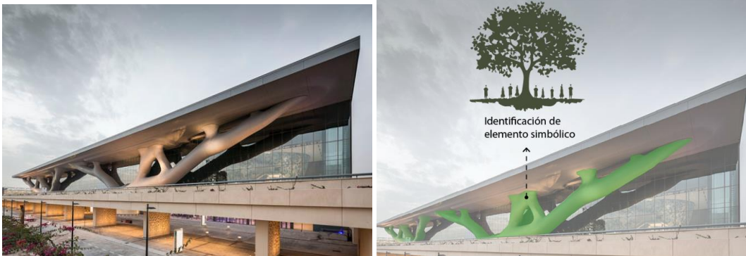
Figura 13. Centro Nacional de Convenciones Qatar
