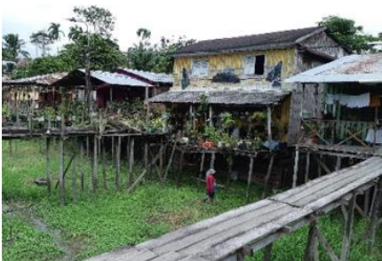
Nota. Sendero calle 10ª. Solares de fachada. Fragilidad de estacones. a. Ver descriptor color en Figura 177. Elaboración propia.
