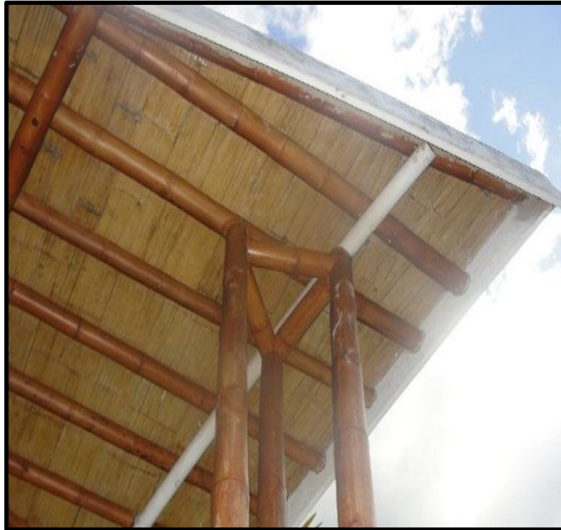
Figura 3. Afectación de Pilar por Fotodegradación Casa Chinauta. Fuente: Propia
