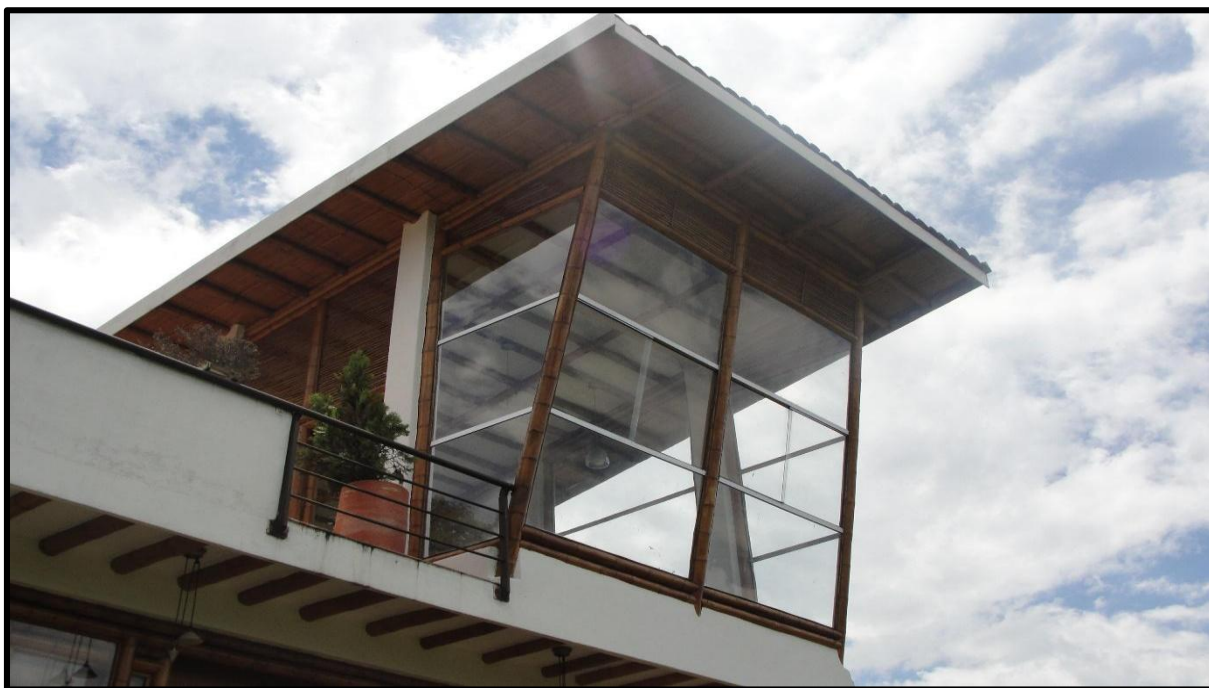
Figura 7. Restauración Realizada en Casa Ojeda Silvania. Fuente: Propia.
