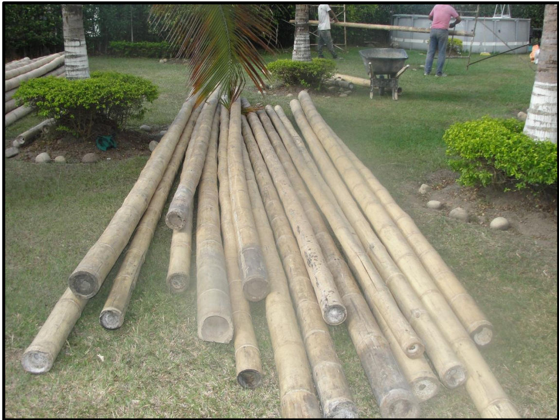
Figura 10. Casa Chinauta, empleo de Guadua Cepa para Reemplazo de Piezas. Fuente Propia.
