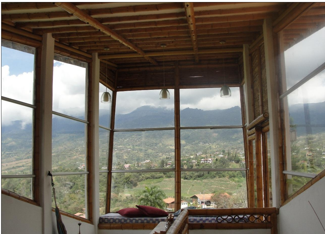
Figura 16. Detalle Proceso de Restauración Casa Ojeda Silvania. Fuente: Propia.
