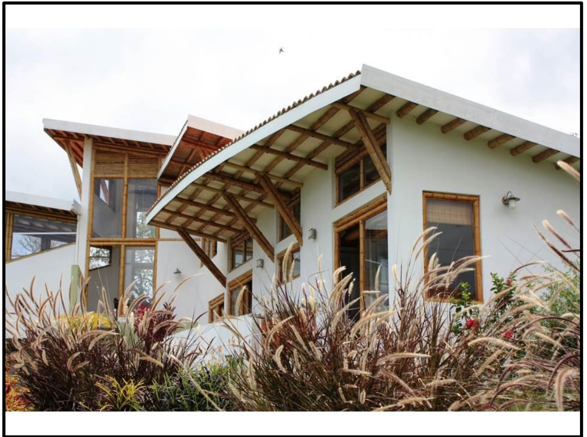
Figura 9. Casa Ojeda Silvania, Guadua Restaurada con Impranol. Fuente: Propia.
