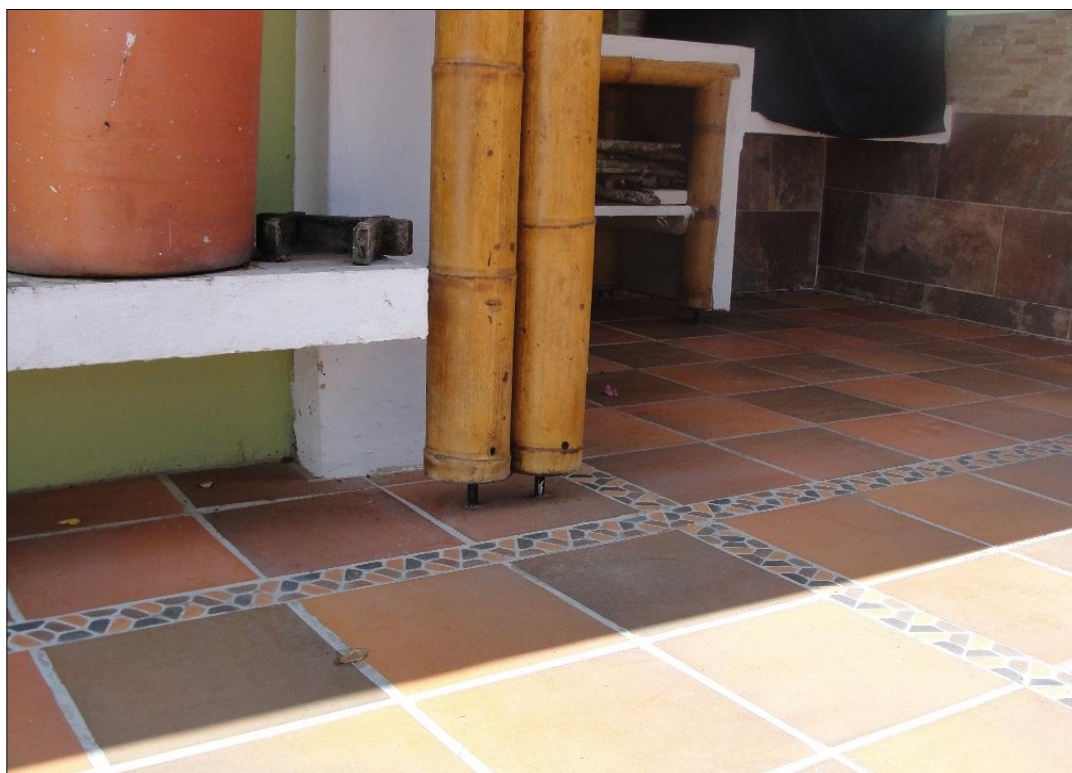
Figura 5. Aislamiento del Suelo con Platina Metálica Casa Ojeda. Fuente: Propia.
