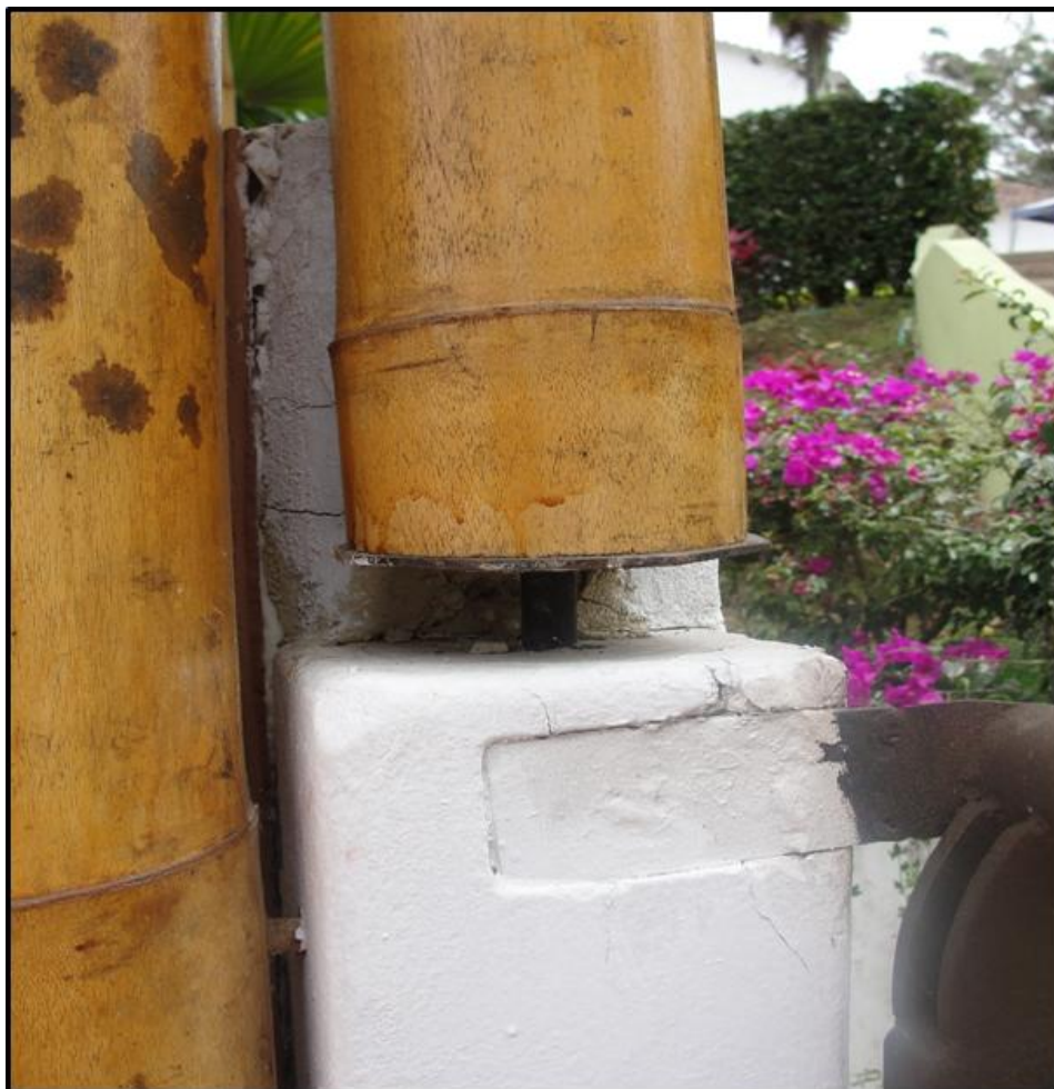
Figura 12. Elemento Estructural Casa Ojeda Silvania sobre Platina. Fuente: Propia.
