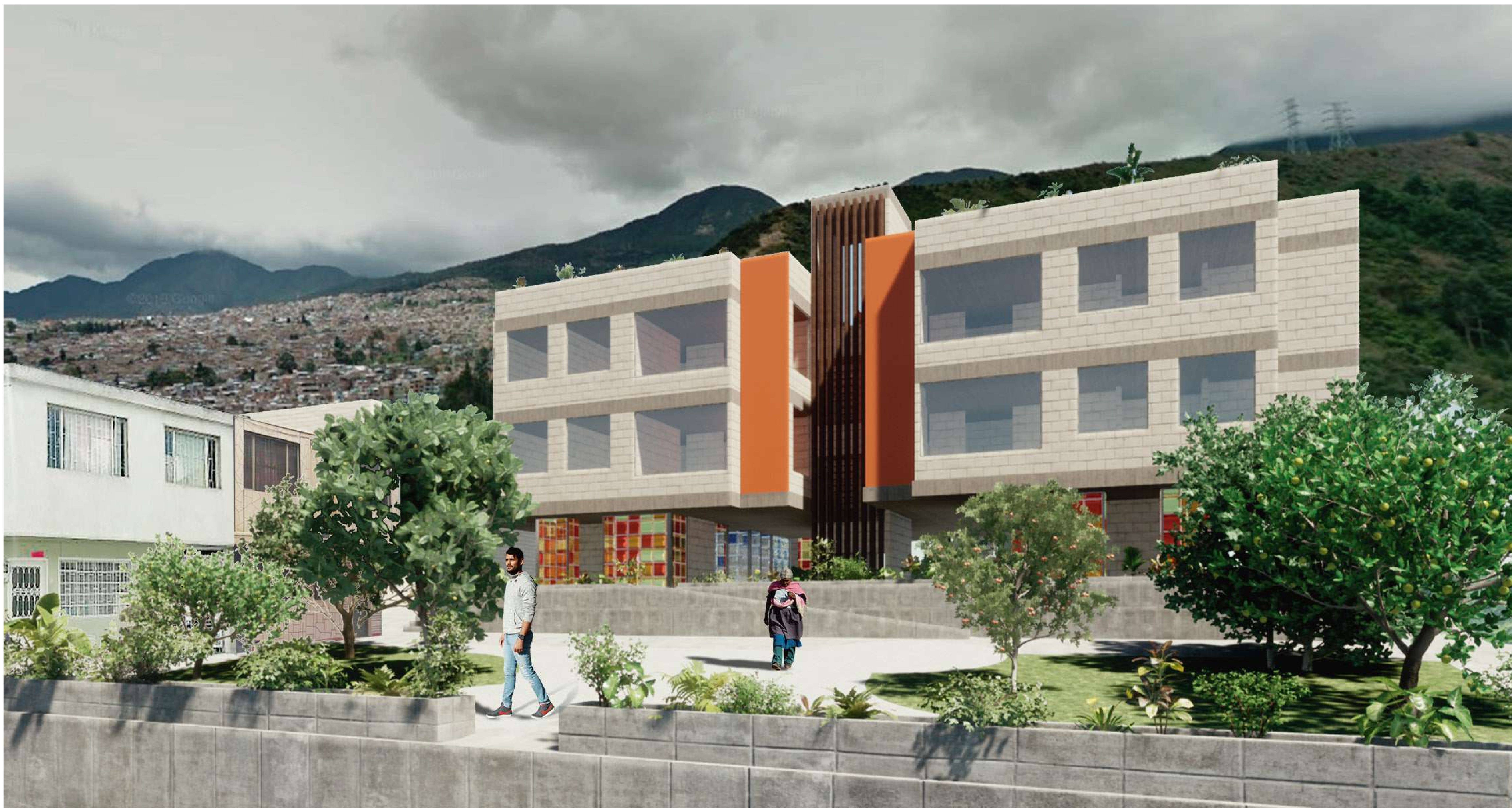
R IMAGEN EXTERIOR VIVIENDA HORIZONTAL
