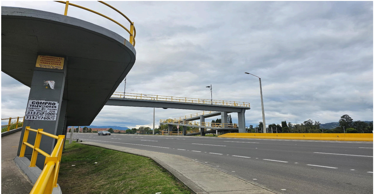
Figura 11 Puente salida Chia.
