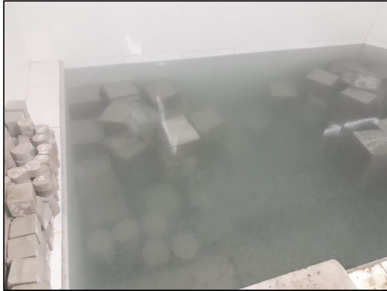
Figura 13: Curado de concreto.
