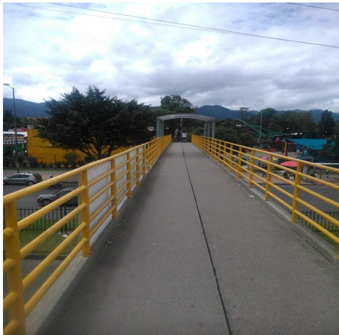
Ilustración 5. Losa puente peatonal en estudio.
