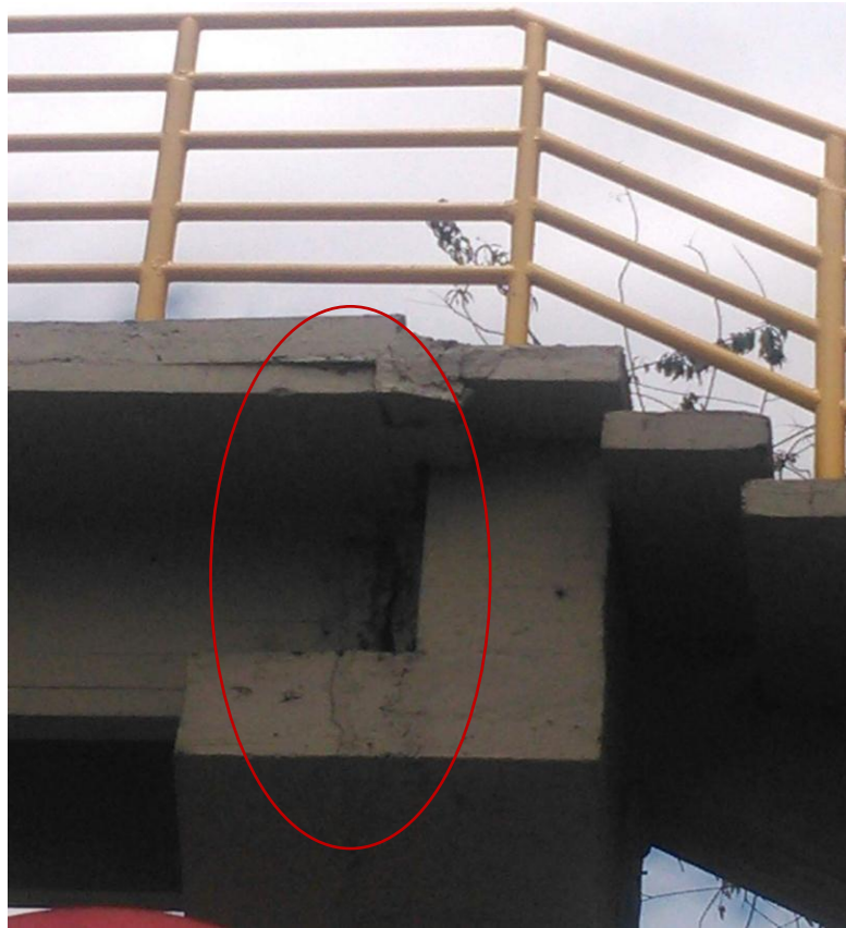
Ilustración 2. Grieta en el concreto estructural del puente peatonal en estudio.
