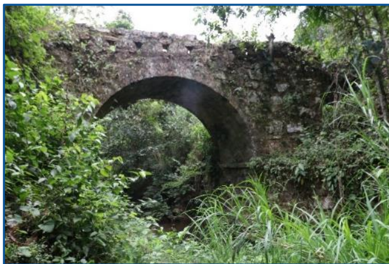
Imagen 105. Puente Manuel Ortiz fuente: propia
