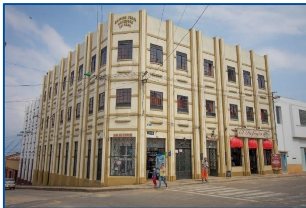
Imagen 100. Edificio Vesga fuente: propia
