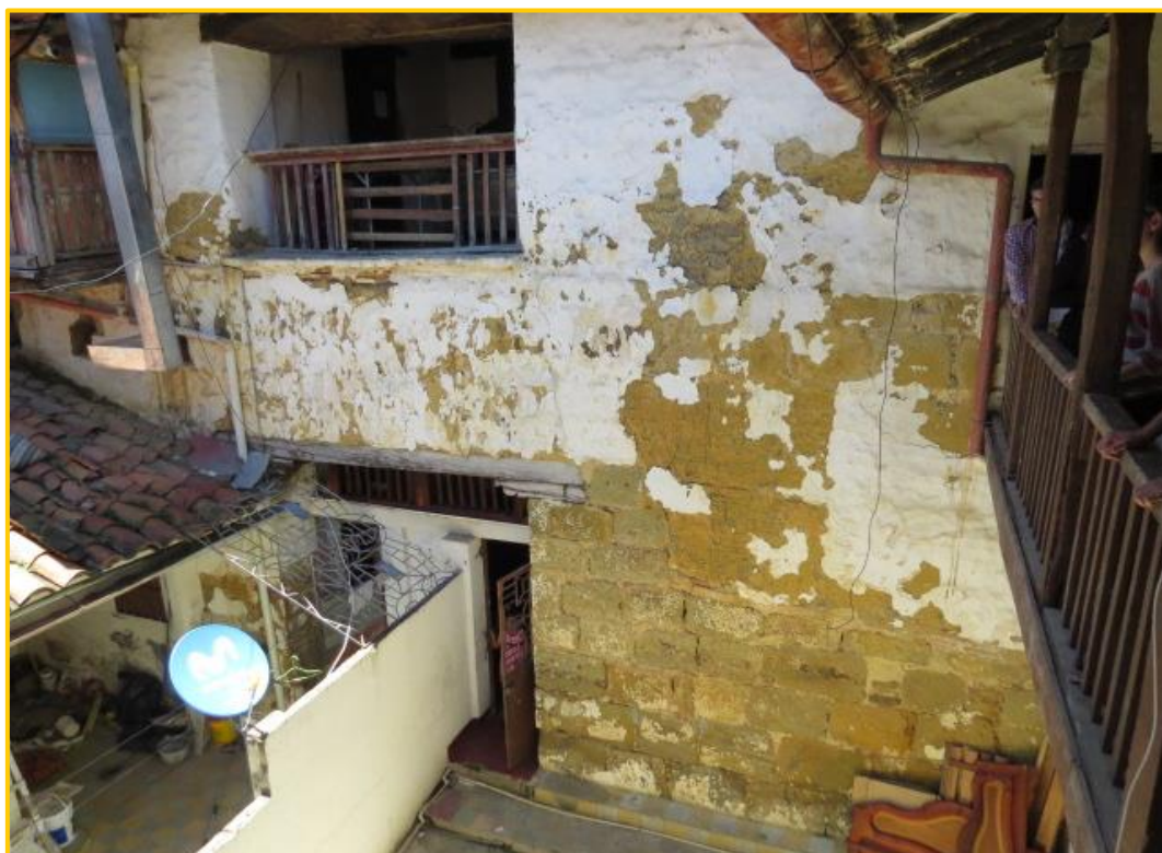
Imagen 68 Detalle muro de patio central, primer piso en calicanto, segundo piso en tapia pisada Casa del hospital, sector español Fuente: propia
