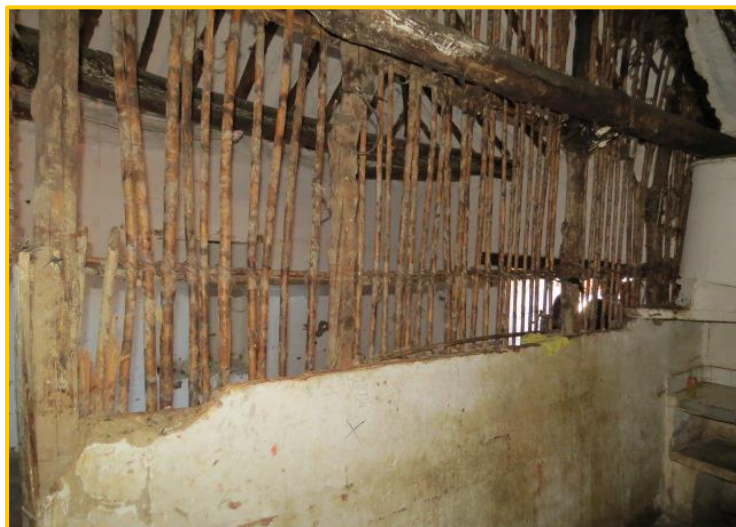
Imagen 67 Muro divisorio en Bahareque Casa del hospital, sector español
