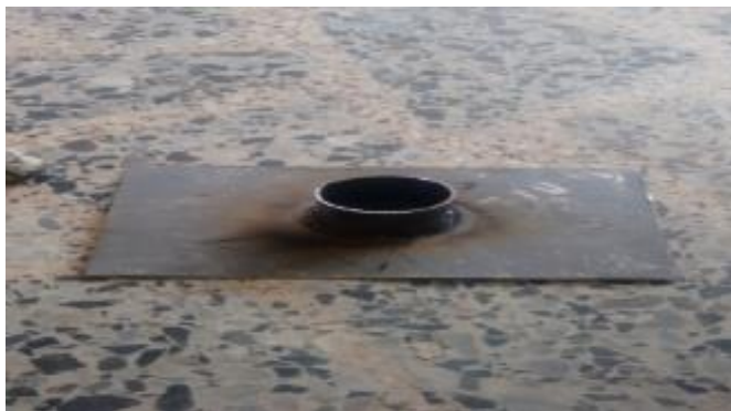
Imagen 23. Corte del eje giratorio.
