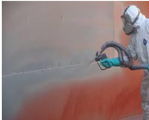
Foto 10. Impermeabilización de tanque con poliurea
