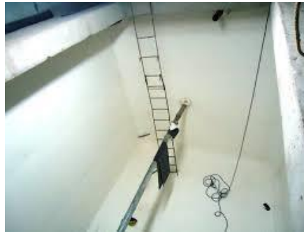
Foto 7. Impermeabilización de tanque mediante membrana de PVC.
