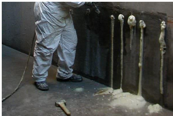
Foto 31. Aplicación de inyecciones de poliuretano Sikafix HH
