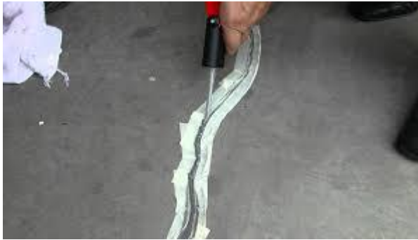
Foto 26. Aplicación de masilla
