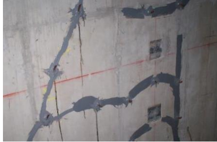
Foto 25. Aplicación de inyecciones epoxicas
