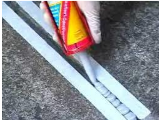
Foto 4. Aplicación de masilla en junta
