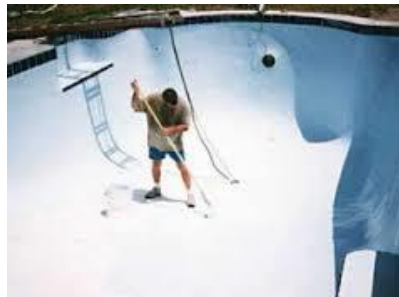
Foto 8. Impermeabilización de piscina con materiales epóxicos.
