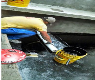
Foto 13. Impermeabilización mediante (Igol®Imprimante - Igol®Denso )
