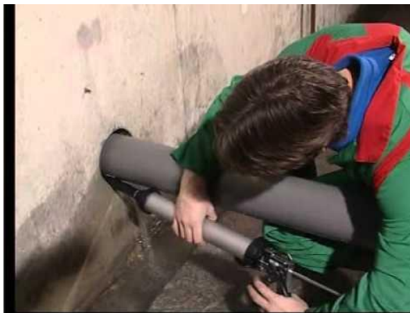
Foto 6. Sello de pase muros mediante masilla.
