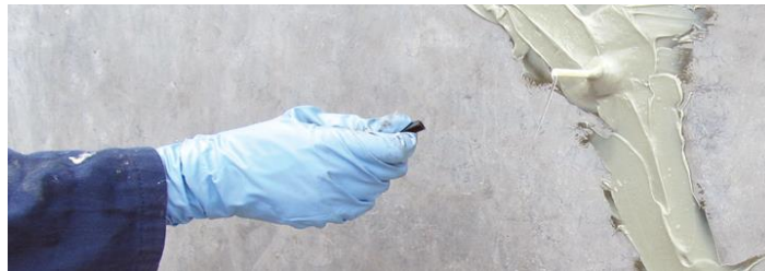
Foto 24. Aplicación de inyecciones de poliuretano.
