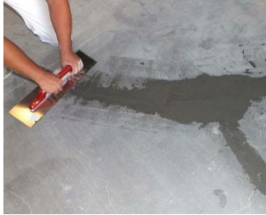
Foto 23. Reparación de juntas mediante el uso de morteros.
