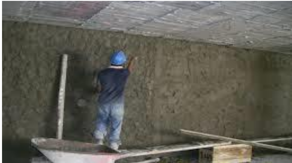
Foto 5. Aplicación de pañete en el interior de un tanque
