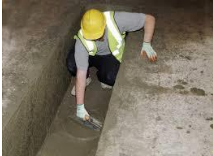
Foto 9. Impermeabilización de tanque con materiales cementantes.
