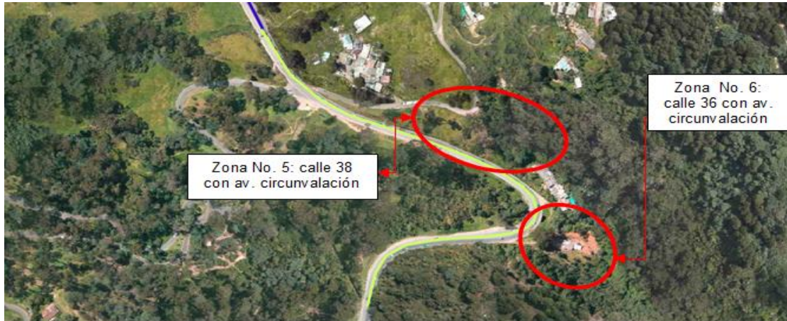
Figura 19: Zonas con posibles movimientos No. 5 y No. 6.
