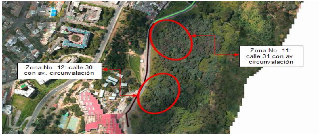
Figura 23: Zonas con posibles movimientos No. 11 y No. 12
