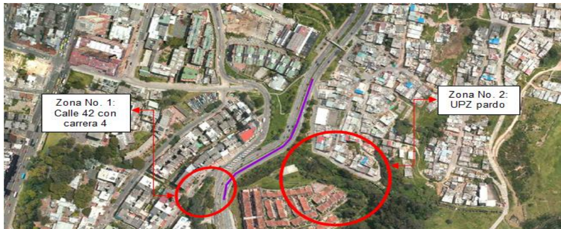
Figura 16: Zonas con posibles movimientos No. 1 y No. 2
