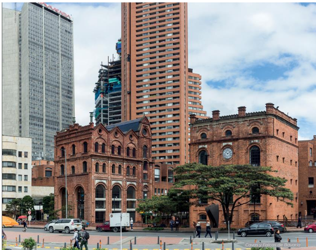
Ilustración 25: Edificios Falcas y Cavas - Parque Central Bavaria
