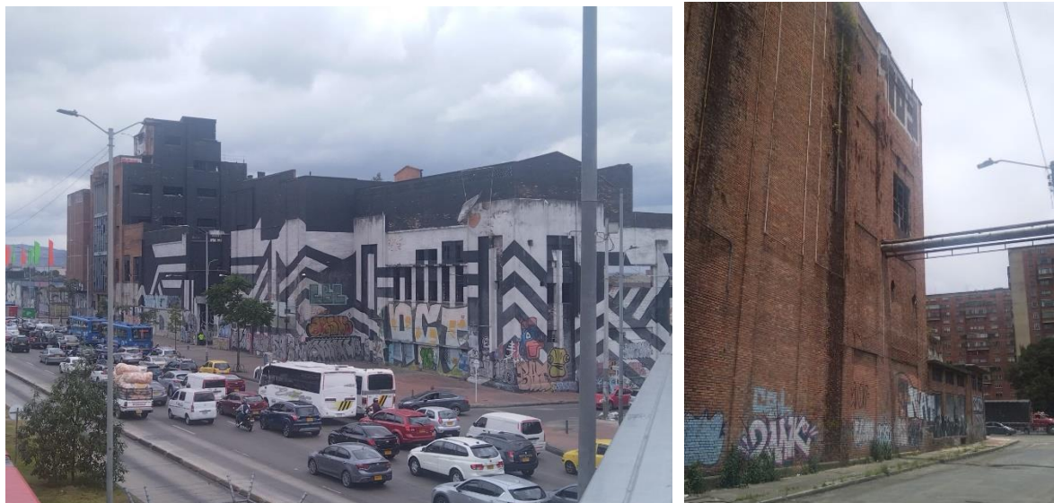
Ilustración 11: Estado actual de edificaciones.
