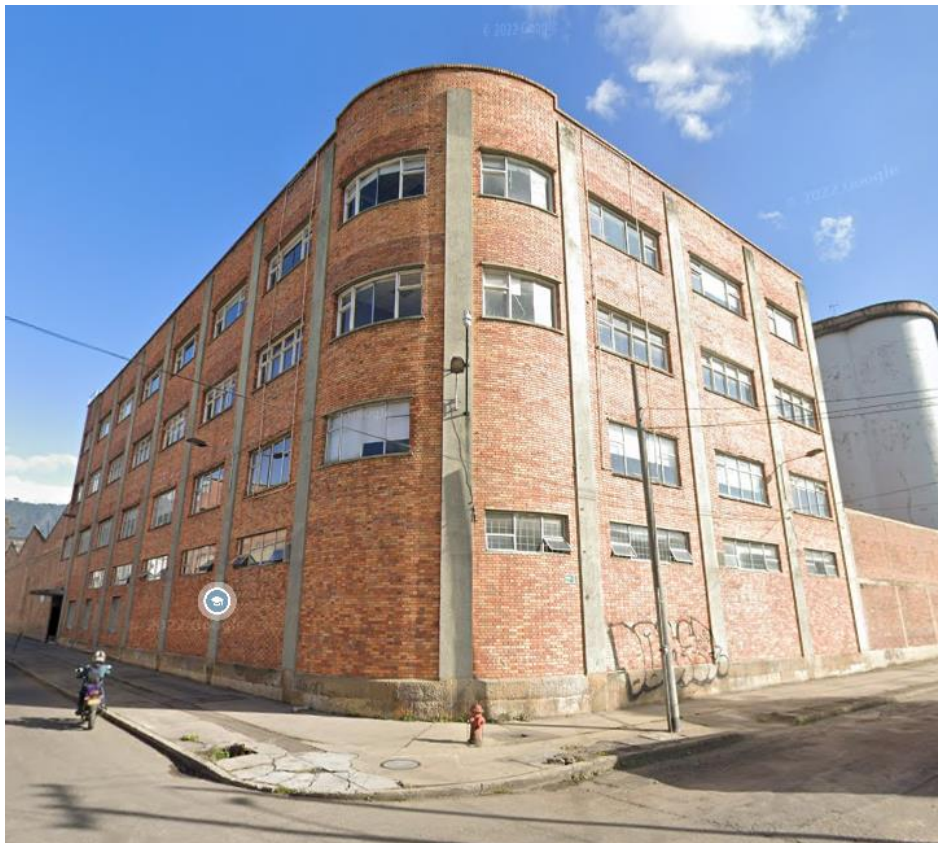
Ilustración 19: Vista posterior Edificio A
