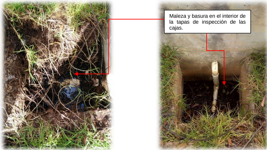
Figura 17. Cajas de inspección del desarenador.
