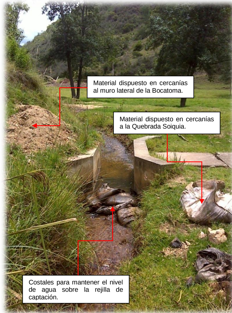
Figura 10. Bocatoma de fondo.
