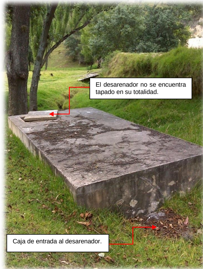
Figura 16. Desarenador.
