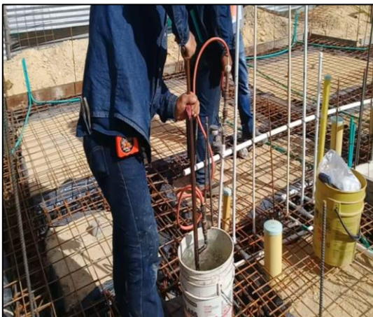
Fig. 79 y 80 prueba de presión
