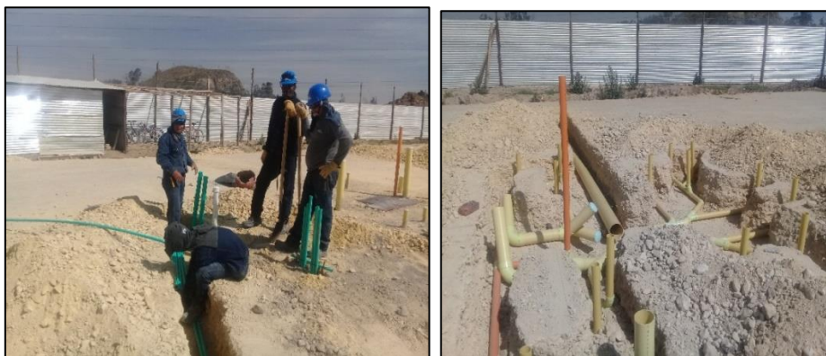
FIG 25 EXCAVACIÓN E INSTALACIÓN RED ELÉCTRICAS Y DESAGUES
