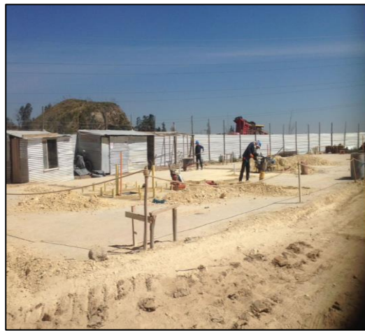
FIG 22 Y 23 LLENO Y COMPACTACION DE RECEBO SOBRE TUBERIAS CON CANGURO Y VIBROCOMPACTADORA MANUAL (RANA) Registro fotográfico de obra Giovanni Hernández inspector de interventoría vivienda
