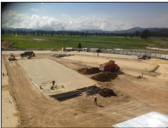
FIG 10 INSTALACION DE GEOTEXTIL NTC 2500
