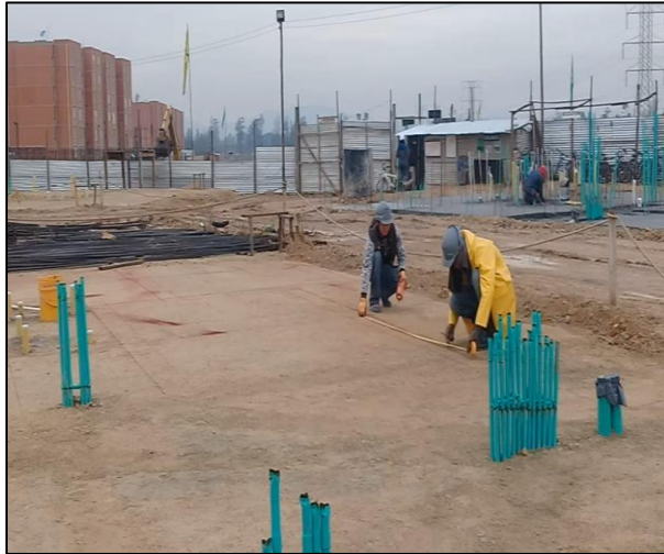
FIG 18 REPLANTEO DE EJES DE CIMENTACIÓN
