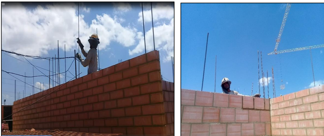
FIG 1115 – 116 Y 117 INSTALACIÓN DE REFUERZO VERTICAL
