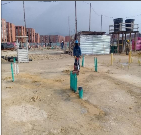
FIG 22 Y 23 LLENO Y COMPACTACION DE RECEBO SOBRE TUBERIAS CON CANGURO Y VIBROCOMPACTADORA MANUAL (RANA) Registro fotográfico de obra Giovanni Hernández inspector de interventoría vivienda
