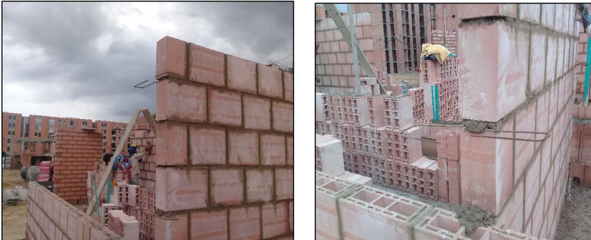
Registro fotográfico de obra Giovanni Hernández inspector de interventoría vivienda
