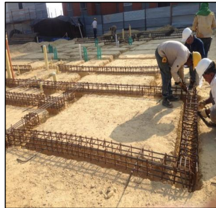
FIG 39 Y 40 SE REALIZA AMARRE DE ACEROS, ESTRIBOS Y ACEROS PRINCIPALES SEGÚN ESPECIFICACIÓN DE PLANOS ES 53- ES 54 – ES 55
