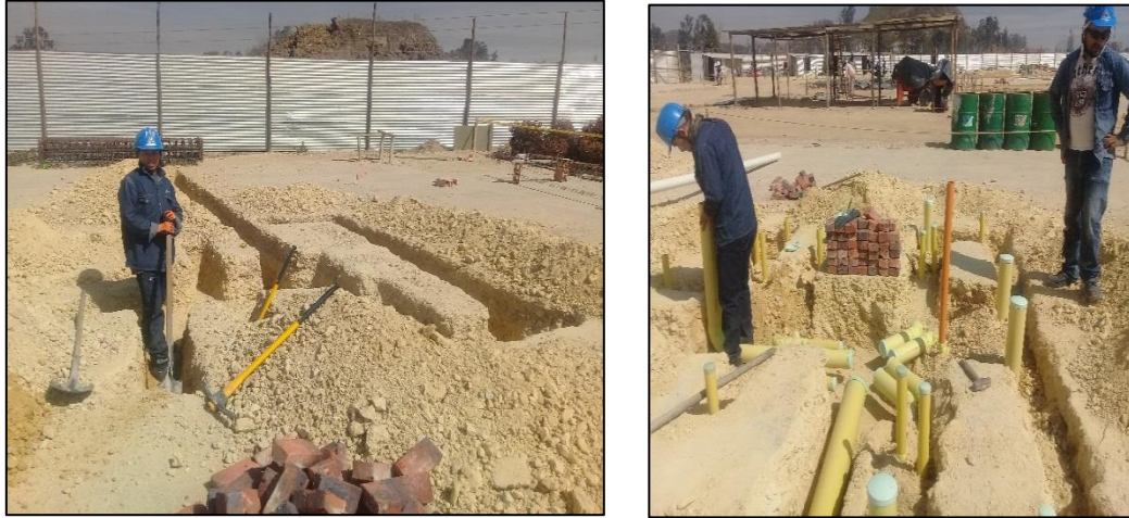
FIG 27 Y 28 EXCAVACIÓN E INSTALACIÓN TUBERÍA SANITARIA Y VENTILACIÓN. Registro fotográfico de obra Giovanni Hernández inspector de interventoría vivienda
