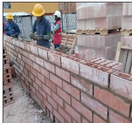
FIG 111 LEVANTAMIENTO MUROS EN MAMPOSTERÍA INSTALACIÓN DE REFUERZO HORIZONTAL GRAFIL
