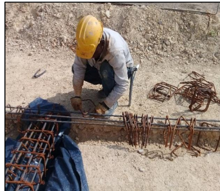
FIG 50, 51 y 52 SE REALIZA AMARRE DE ACEROS PARA VIGAS
