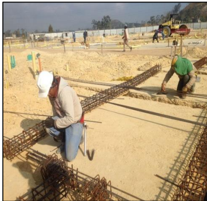
FIG 39 Y 40 SE REALIZA AMARRE DE ACEROS, ESTRIBOS Y ACEROS PRINCIPALES SEGÚN ESPECIFICACIÓN DE PLANOS ES 53- ES 54 – ES 55
