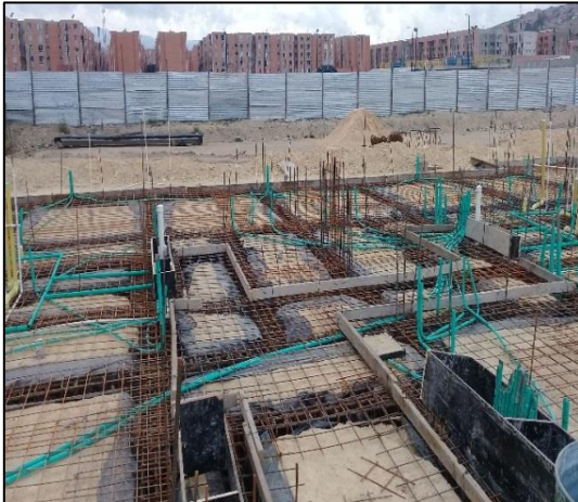
FIG 77 y 78 INSTALACIONES DE REDES EN PLACA DE CONTRAPISO.
