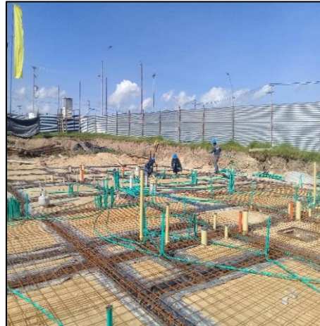
FIG 77 y 78 INSTALACIONES DE REDES EN PLACA DE CONTRAPISO.
