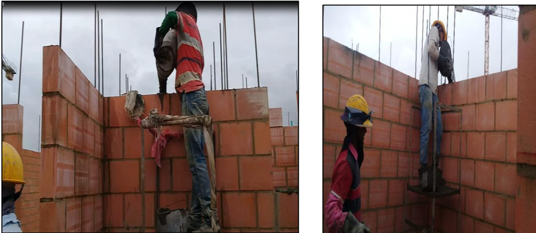
FIG 122 – 123 – 124 – y 125 FUNDIDA DE DOVELAS CON GROUTIN DE PLANTA CEMEX DE 1500 PSI
