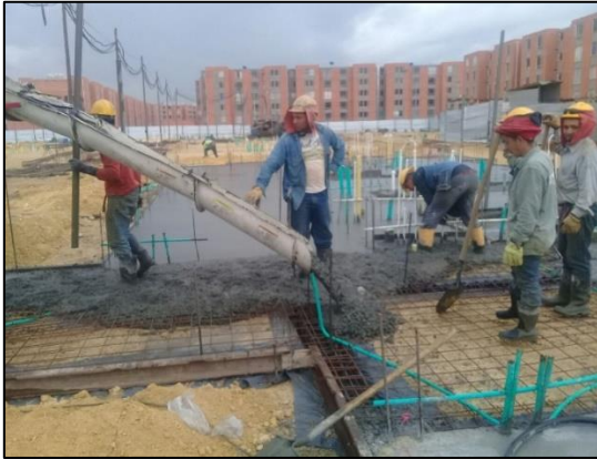
FIG 88 FUNDIDA DE CIMENTACION
