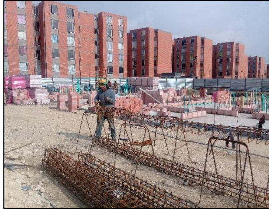
FIG 37 Y 38 SE REALIZA AMARRE DE ACEROS PARA VIGAS SECUNDARIAS SOBRE BURROS PARA POSTERIOR MENTE LLEVARLAS Y AMARRARLAS EN SITU CON LAS VIGAS PRINCIPALES.
