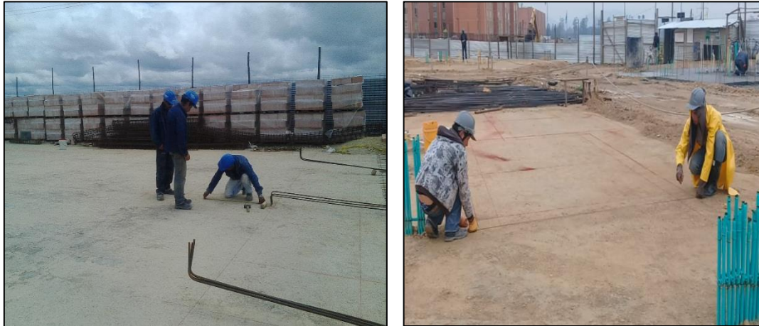
FIG 31 Y 32 REPLANTEO DE EJES DE CIMENTACIÓN
