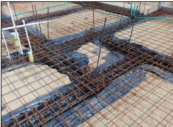
FIG 62 – 63 – 64 Y 65 SE REALIZA TENDIDO DE MALLA SEGÚN PLANO ESTRUCTURAL ES 07 – ES 08
