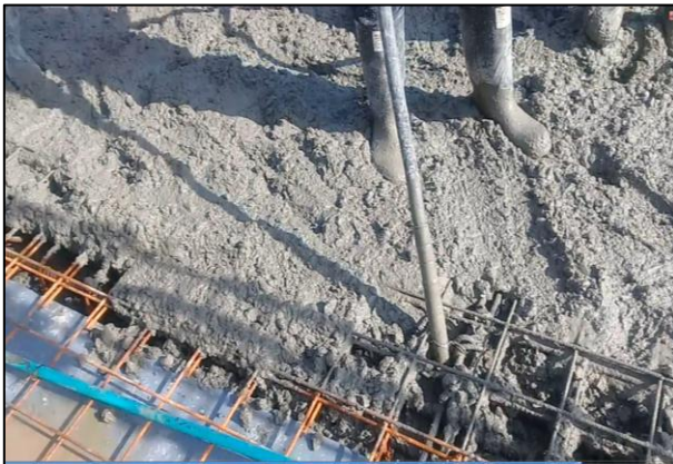
FIG 90 FUNDIDA DE CIMENTACION
