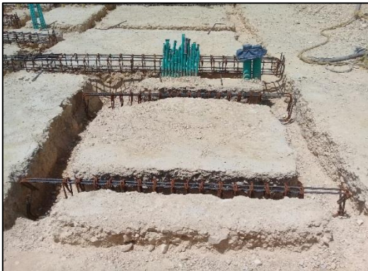
FIG 50, 51 y 52 SE REALIZA AMARRE DE ACEROS PARA VIGAS
