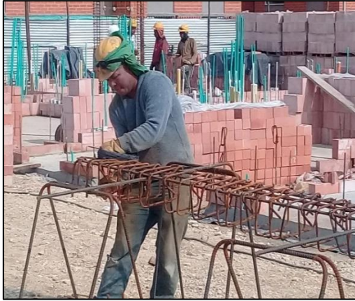
FIG 37 Y 38 SE REALIZA AMARRE DE ACEROS PARA VIGAS SECUNDARIAS SOBRE BURROS PARA POSTERIOR MENTE LLEVARLAS Y AMARRARLAS EN SITU CON LAS VIGAS PRINCIPALES.
