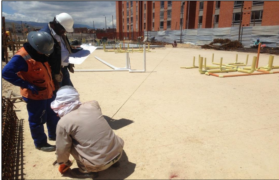
FIG 24 REVISIÓN Y LIBERACIÓN DE MEDIDAS EJES DE CIMENTACION EN ESTA FIGURA SE REALIZA RE CHEQUEO DE ESCUADRA MEDIANTE MEDIDA DE LA DIAGONAL Registro fotográfico de obra Giovanni Hernández inspector de interventoría vivienda
