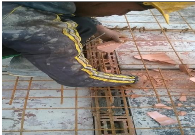
Fig. 135 Registro fotográfico de obra Giovanni Hernández inspector de interventoría vivienda
