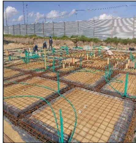
Fig. 73– 74 – 75 y 76 muestra el tendido de tuberías eléctricas, hidráulicas y desagües
