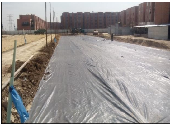
FIG 6 INSTALACION DE GEOTEXTIL NTC
