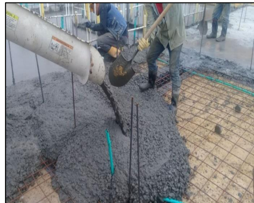
FIG 91 VIBRACIÓN DEL CONCRETO CON VIBRADOR ELÉCTRICO
