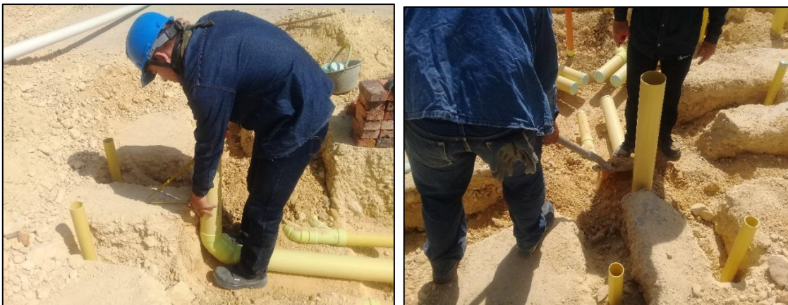
FIG 20 INSTALACIÓN DE ACCESORIOS PARA TUBERÍA SANITARIA
