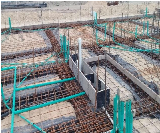
Fig. 73– 74 – 75 y 76 muestra el tendido de tuberías eléctricas, hidráulicas y desagües
