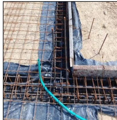
FIG 62 – 63 – 64 Y 65 SE REALIZA TENDIDO DE MALLA SEGÚN PLANO ESTRUCTURAL ES 07 – ES 08
