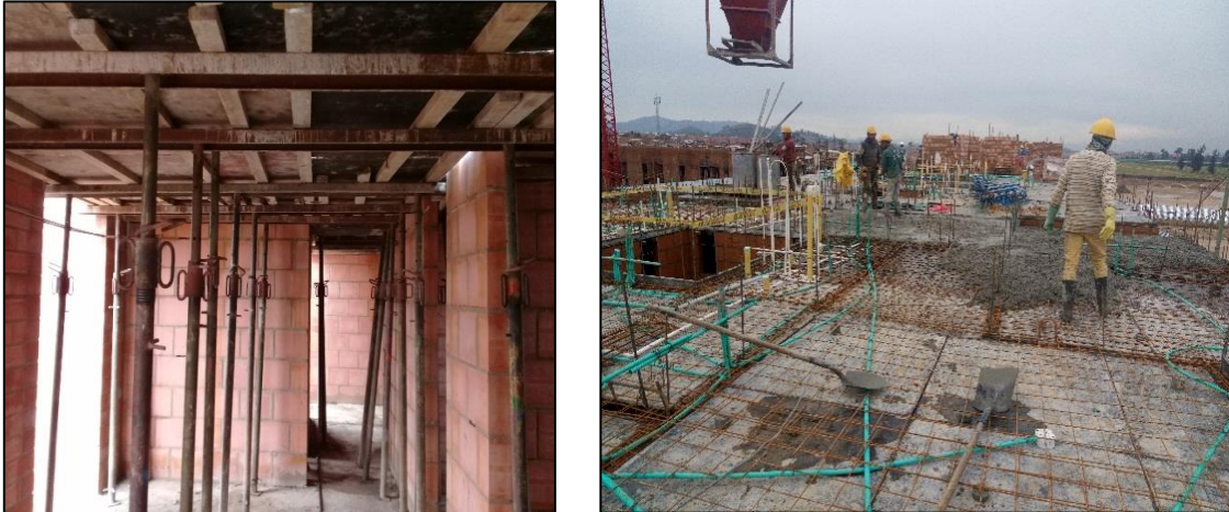
Fig. 136 – 137 Registro fotográfico de obra Giovanni Hernández inspector de interventoría vivienda
