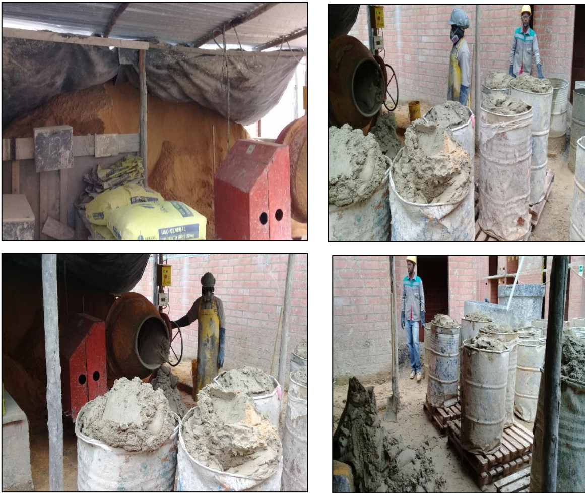
FIG 103 – 104 – 105 y 106 PREPARACIÓN DE MORTERO EN OBRA SEGÚN DISEÑO DE MEZCLAS, SE REALIZO LA CONVERSIÓN DE PESOS EN CANECAS DE 5 GALONES. Registro fotográfico de obra Giovanni Hernández inspector de interventoría vivienda
