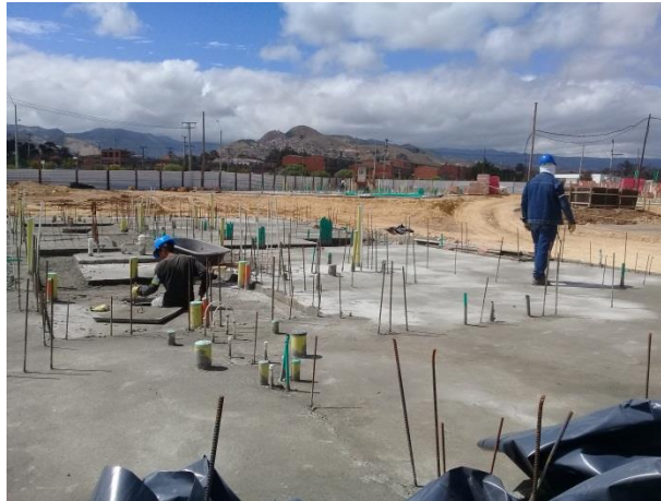
REGISTRO FOTOGRÁFICO DE OBRA GIOVANNY HERNÁNDEZ INSPECTOR DE INTERVENTORÍA VIVIENDA
