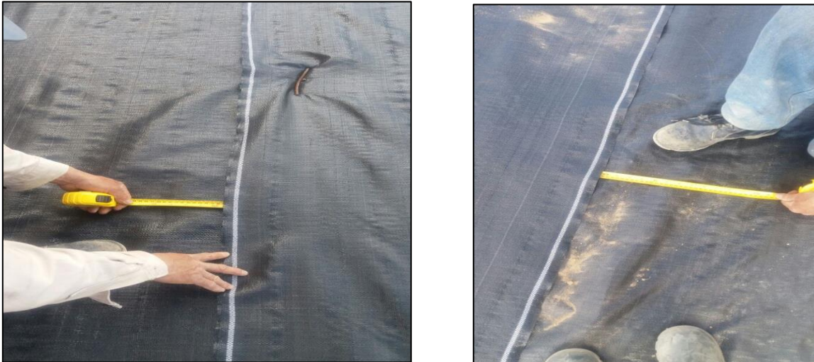
FIG 8 Y 9 REVISION DE MEDIDA DE TRASLAPO DE GEOTEXTIL SEGÚN ESPECIFICACION DE DISEÑADOR 0.30 CM MINIMO Registro fotográfico de obra Giovanni Hernández inspector de interventoría vivienda
