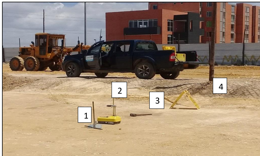
FIG 17 EN LA IMAGEN (1 PLANTILLA GUÍA – 2 DENSÍMETRO NUCLEAR - 3 MACETA DE 3 LIBRAS – 4 AVISO DE ADVERTENCIA DE TOMA DE DENSIDAD) Registro fotográfico de obra Giovanni Hernández inspector de interventoría vivienda
