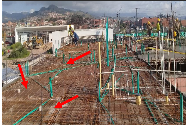
Fig. 134 Registro fotográfico de obra Giovanni Hernández inspector de interventoría vivienda
