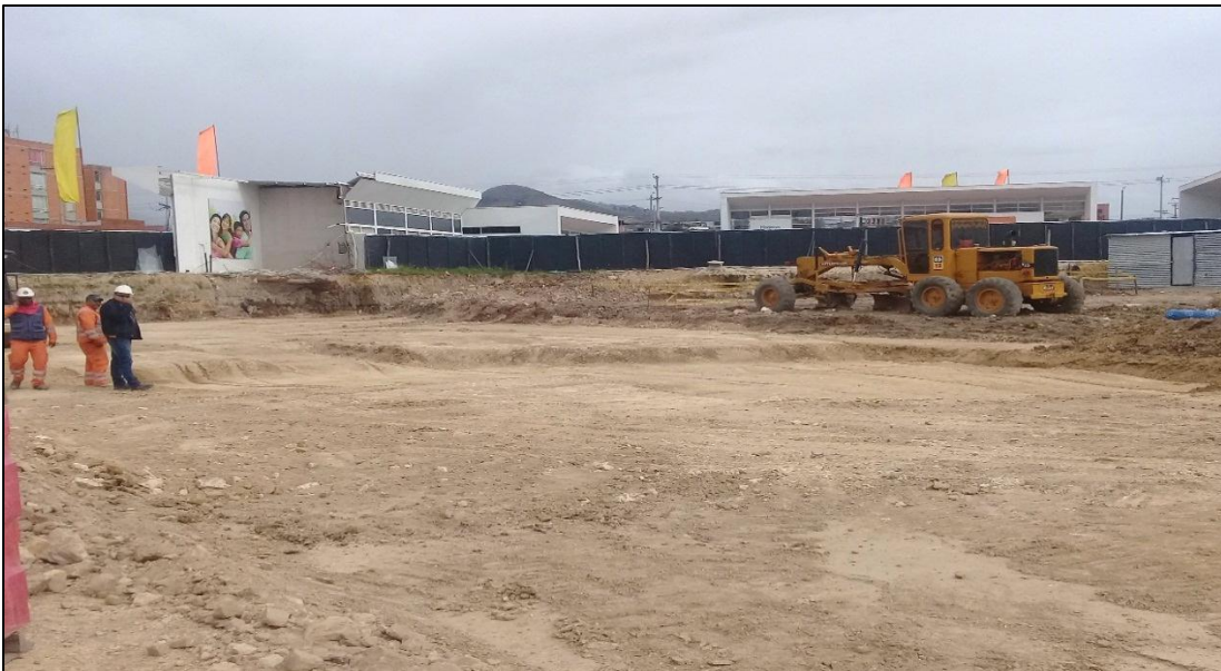
Fig. 5 Registro fotográfico de obra Giovanni Hernández inspector de interventoría vivienda
