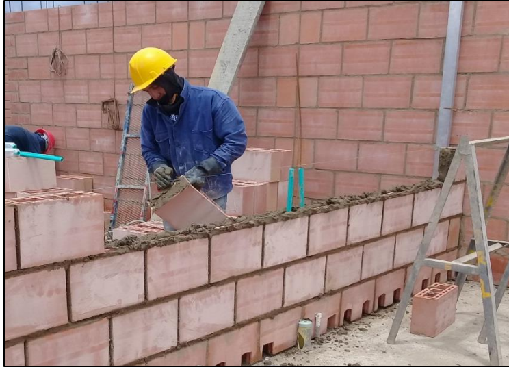
Registro fotográfico de obra Giovanni Hernández inspector de interventoría vivienda
