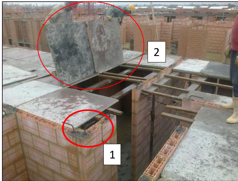
Fig. 129 Registro fotográfico de obra Giovanni Hernández inspector de interventoría vivienda
