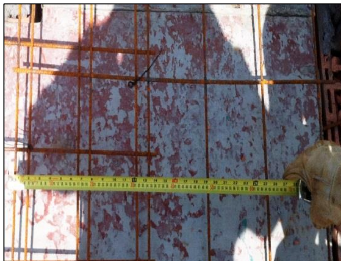
Fig. 133 Registro fotográfico de obra Giovanni Hernández inspector de interventoría vivienda
