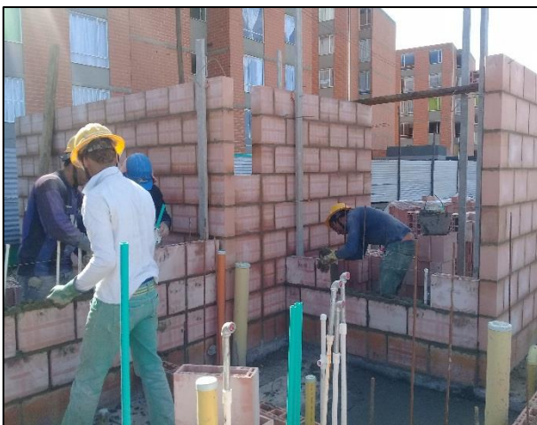
FIG 111 LEVANTAMIENTO MUROS EN MAMPOSTERÍA INSTALACIÓN DE REFUERZO HORIZONTAL GRAFIL
