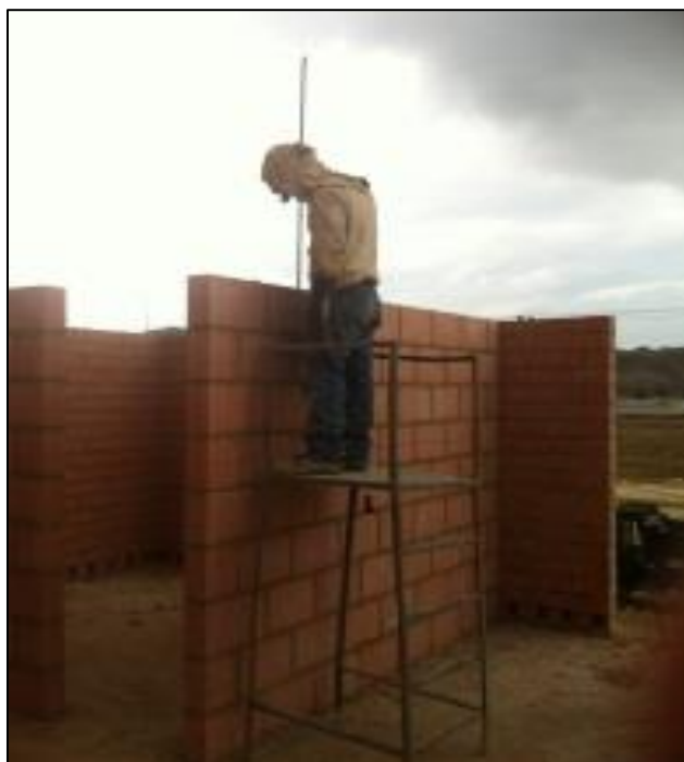
FIG 1115 – 116 Y 117 INSTALACIÓN DE REFUERZO VERTICAL
