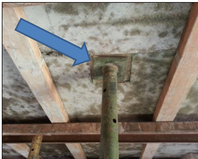
Fig. 131 Registro fotográfico de obra Giovanni Hernández inspector de interventoría vivienda
