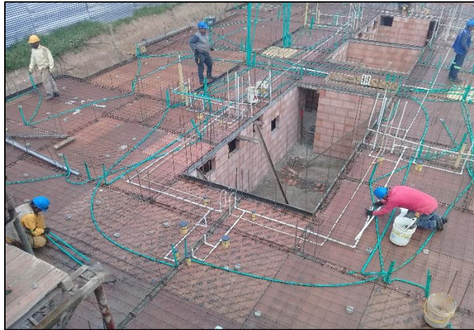
Fig. 132 Registro fotográfico de obra Giovanni Hernández inspector de interventoría vivienda
