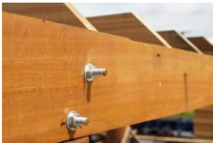
Natapol. (2023). Pernos para sujetar la estructura de la casa de madera en construcción.
