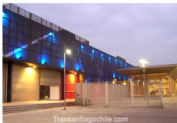
Figura 13 Fachada Estación La Cisterna -Chile
