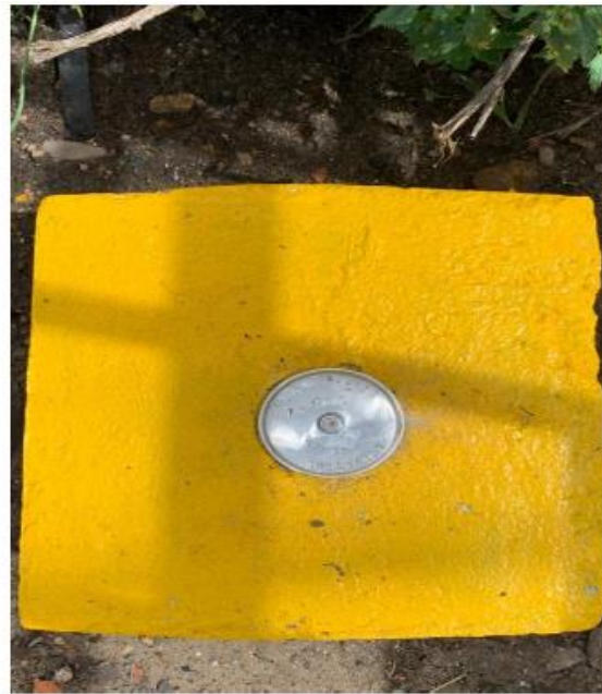
Figura 2-1. Punto de control GCP - Mojón N° 15 (Base). Fuente: Propia.
