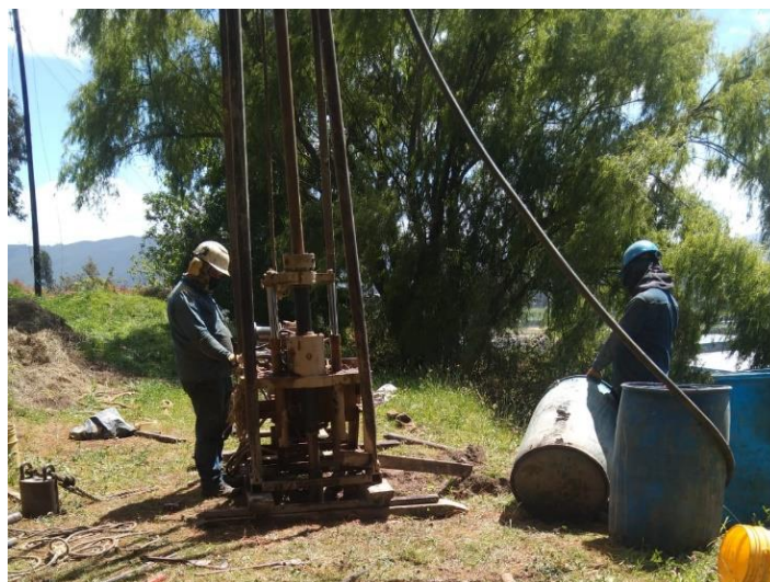
Figura 2-38. Perforación con equipo de rotopercusión tipo Petty.
