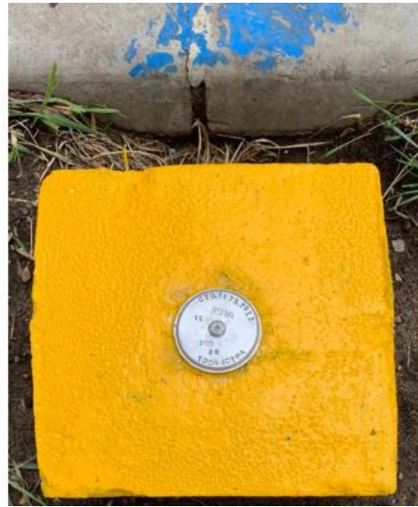
Figura 2-2. Punto de fotocontrol GCP - Mojón N° 12. Fuente: Propia.
