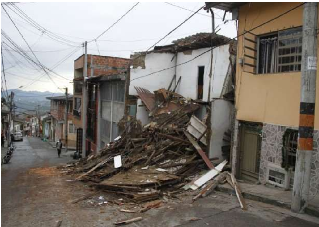
Imagen 9. Colapso de vivienda construida en bahareque y guadua
