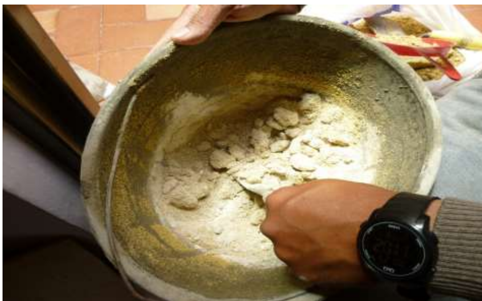
Imagen 23. Mezcla de materiales para la tapia pisada
