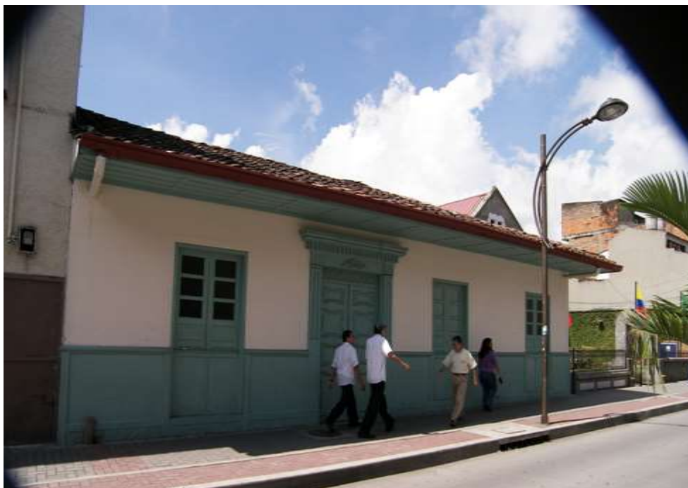
Imagen 8. Casas patrimoniales en Manizales, restauración
