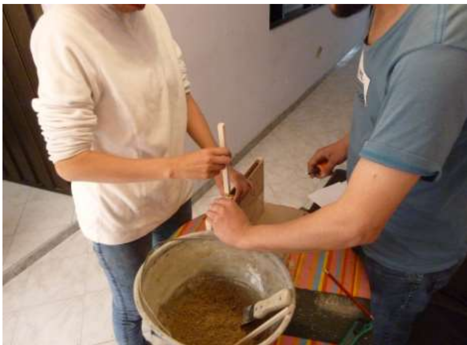
Imagen 28. Proceso de apisonamiento segundo tramo
