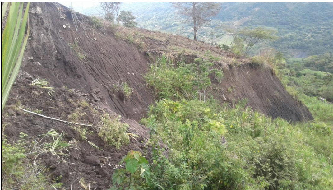
Figura 9. Obsérvese surcos en el escarpe principal del movimiento, pérdida de vegetación y árboles rectos pero inclinados
