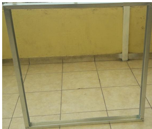
Ilustración 20: Estructura de soporte para base 6 y canal base 6. Fuente: Elaboración propia (2016)
