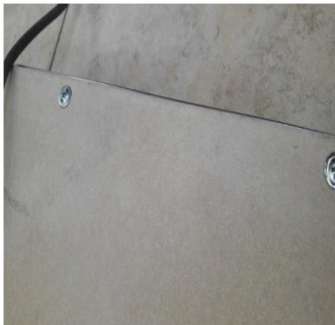
Ilustración 15. El montaje de la estructura de soporte se realizo con placas de fibrocemento de 4 mm y tornillo autorroscante de cabeza extraplana y punta de broca. Fuente: Elaboración propia (2016)
