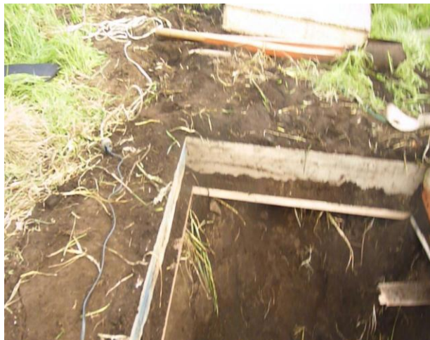
Ilustración 39: Hueco excavado el cual tenía la función de hacer de cámara anecoica. Fuente: Elaboración propia (2016)
