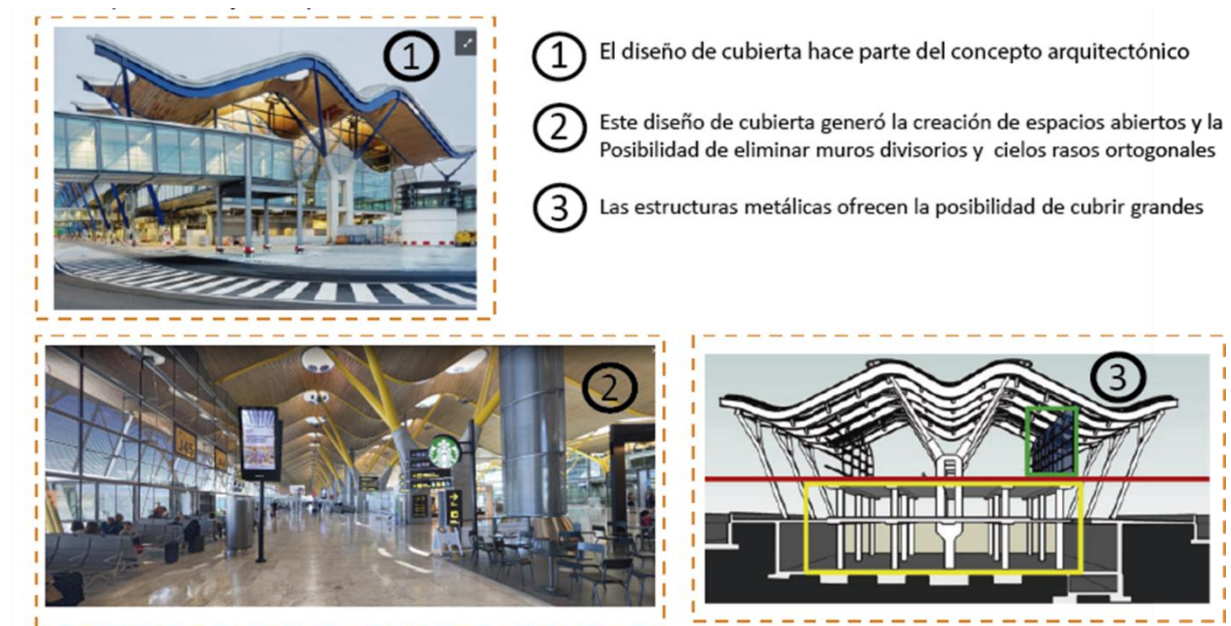
Figura 47. Análisis aeropuerto Barajas. Tomado de Terminal del Aeropuerto Madrid-Barajas / Estudio Lamela & Rogers irk Harbour + Partners (2020) https://www.archdaily.co/co/805961/nueva-area-terminal-del-aeropuerto-madrid-barajas-estudio-lamela-plus-richard-rogers-partnership
