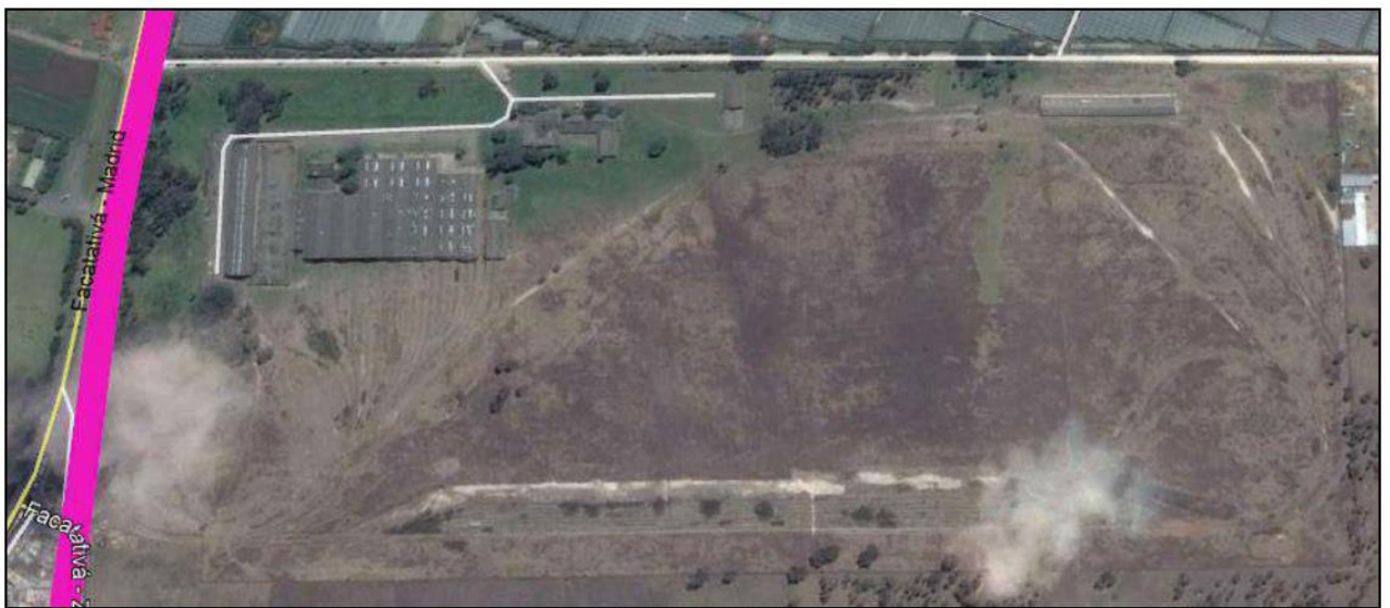
Figura 23. Lote del futuro patio taller el Corzo. Tomado de Documento de Estructuración Técnica Proyecto Regiotram de Occidente .Gobernación de Cundinamarca (2019). Recuperado de https://www.efr-cundinamarca.gov.co/es/contratacion-regiotram
