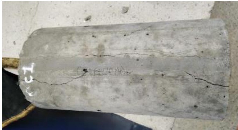
Figura 49 Falla de cilindro patrón a tensión a los 7 días. Elaboración propia
