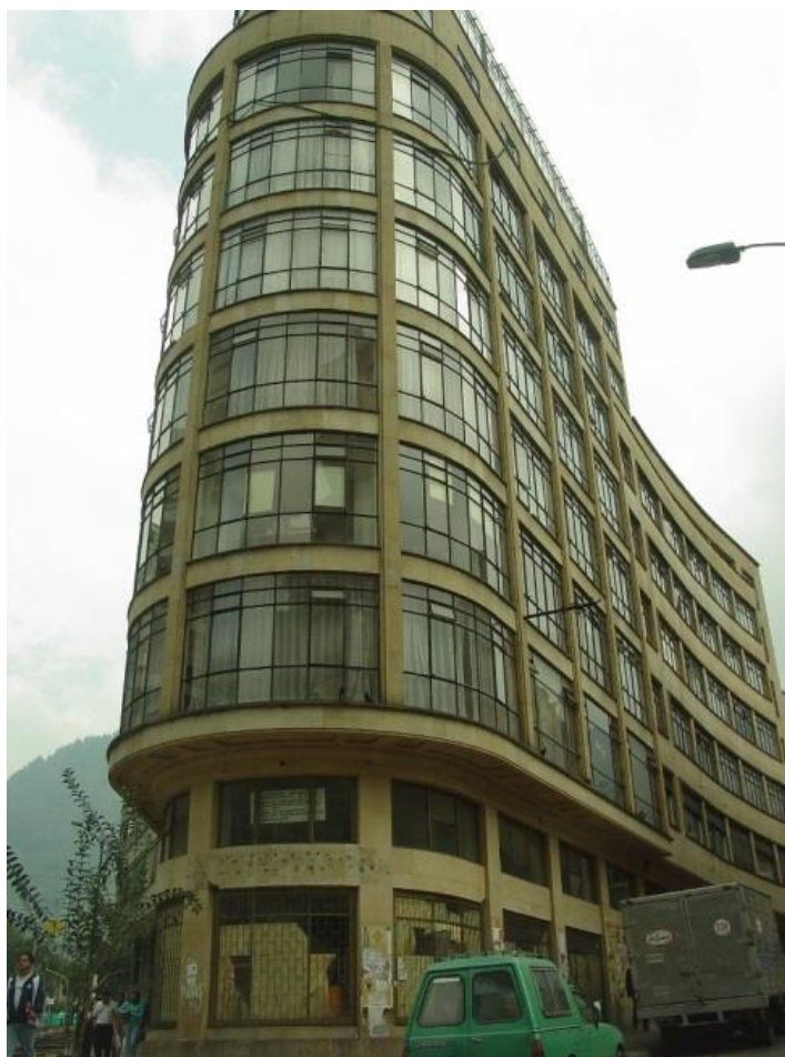
Imagen 29 Edificio Monserrate durante las obras del eje ambiental, Guía del centro histórico, S.A
