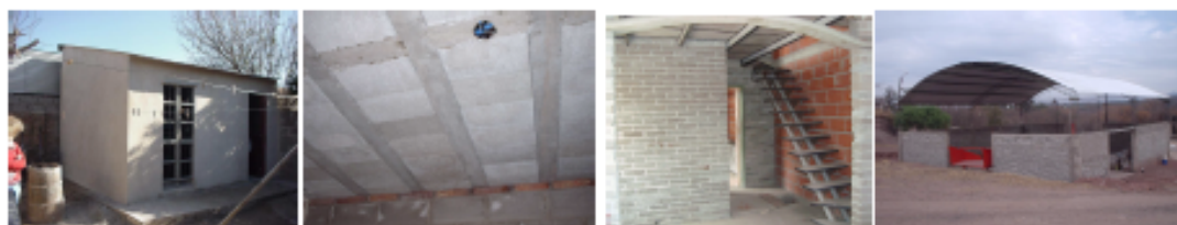
Figuras 5 a 8: Construcciones realizadas con esta tecnología.
