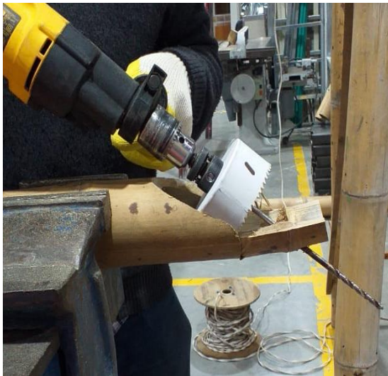
Ilustración 5 Proceso constructivo - terminación de corte tipo flauta con copa
