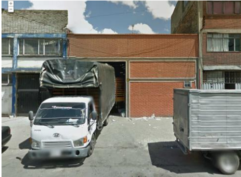
Ilustración 2 Centro de Reciclaje La Pensilvania. Fuente: Street view goolge maps
