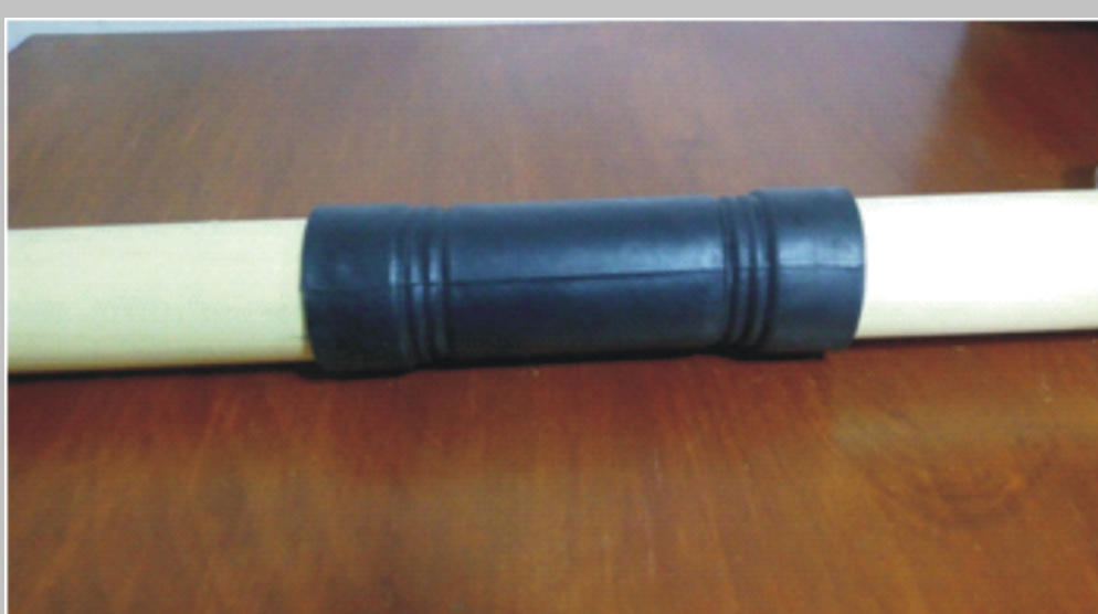
7. Se realiza el ensamble de la tubería, en una longitud de 100 cm.
