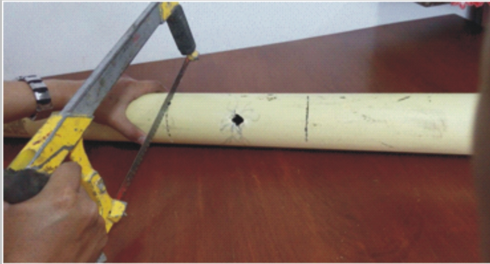
3. Se realiza el ensamble de la tubería, en una longitud de 100 cm.
