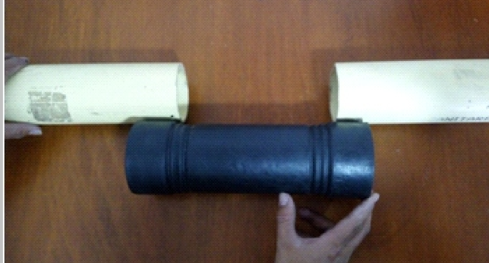
4. Se realiza el ensamble de la tubería, en una longitud de 100 cm.
