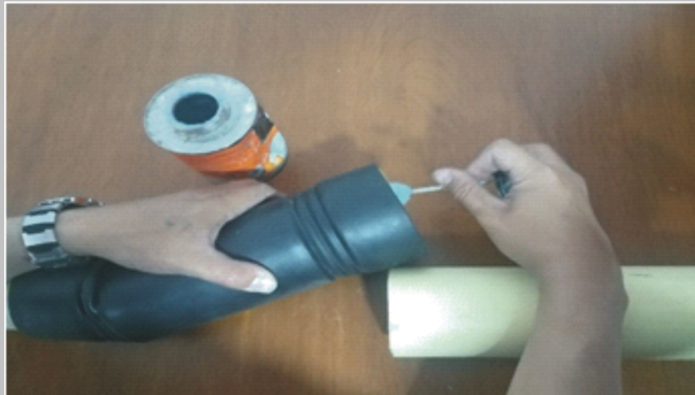
6. Se realiza el ensamble de la tubería, en una longitud de 100 cm.
