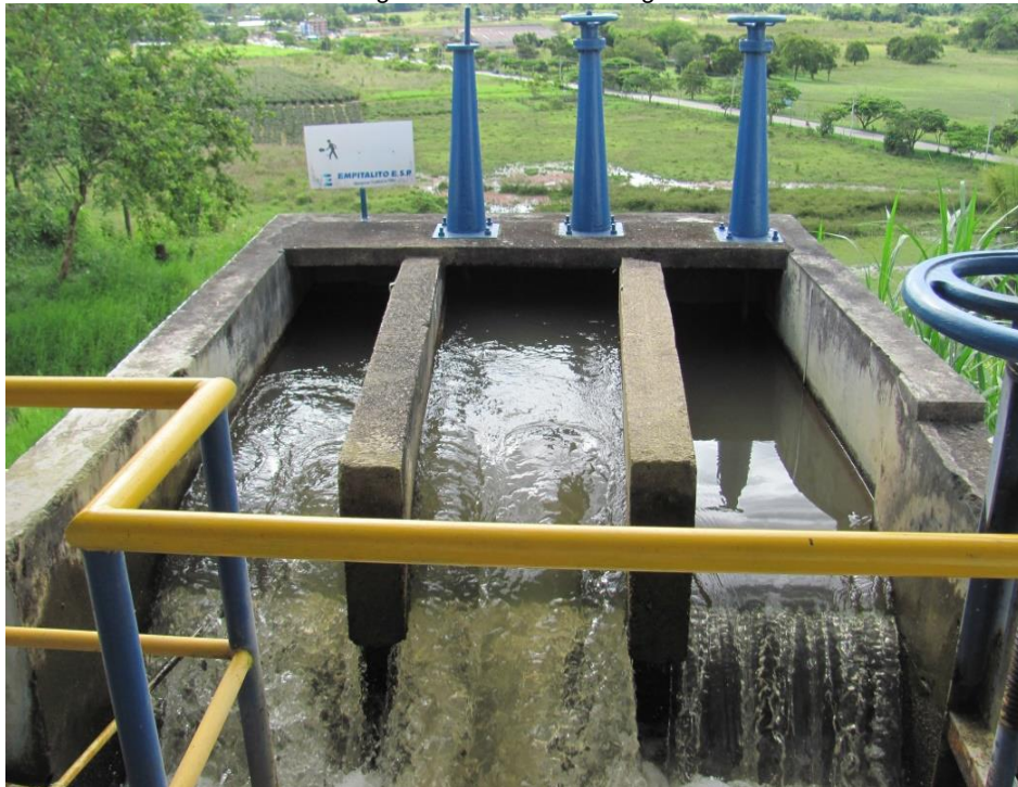
Fotografía 9. Cámara de llegada.
