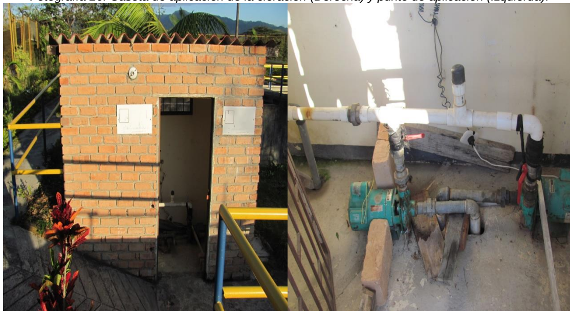
Fotografía 26. Caseta de aplicación de la cloración (Derecha) y punto de aplicación (Izquierda).
