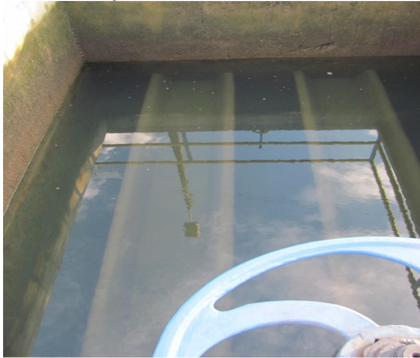
Fotografía 23. Filtro Planta Convencional N°2.
