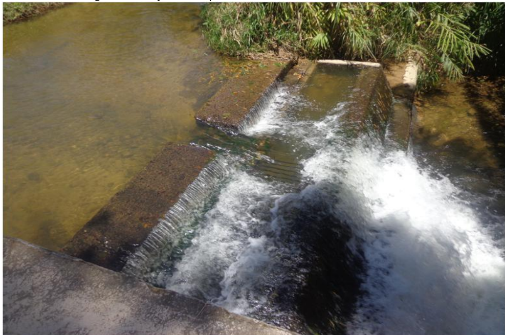
Fotografía 5 .Rejilla de captación existente sobre el Rio Guachicos.
