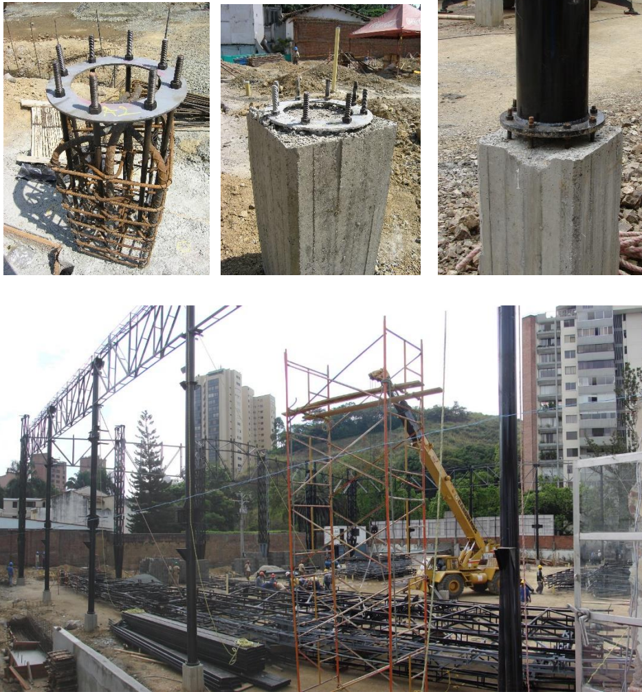
Ilustración 20 Estructura metálica con pedestal en concreto
