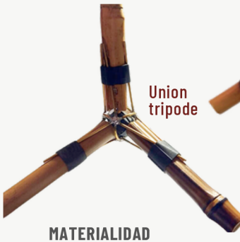
MATERIALIDAD Unión de varilla metálica con barra de bambú
