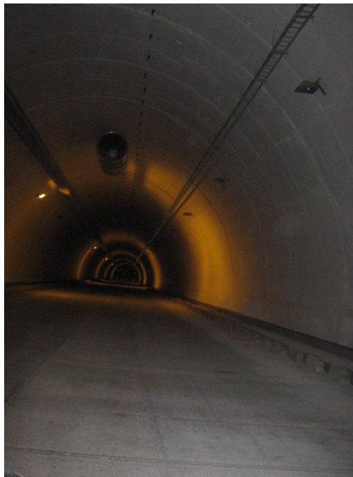
Figura 2. Túnel del Sumapaz.
