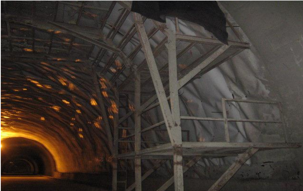
Figura 16. Formaleta de la sección del túnel Guillermo León Valencia.
