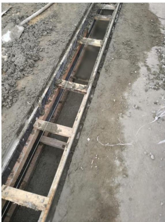
Figura 27: Vaciado de concreto Fuente: propia
