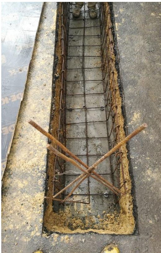
Figura 17: Amarre del acero Fuente: propia
