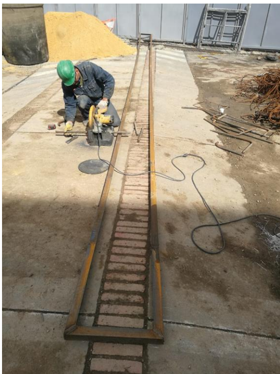
Figura 22: Inicio de instalación marco para rejilla Fuente: propia
