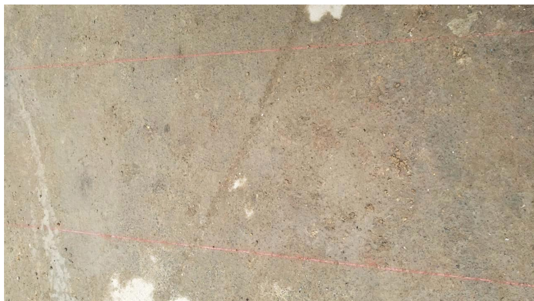
Figura 14: cimbrado del cárcamo en terreno
