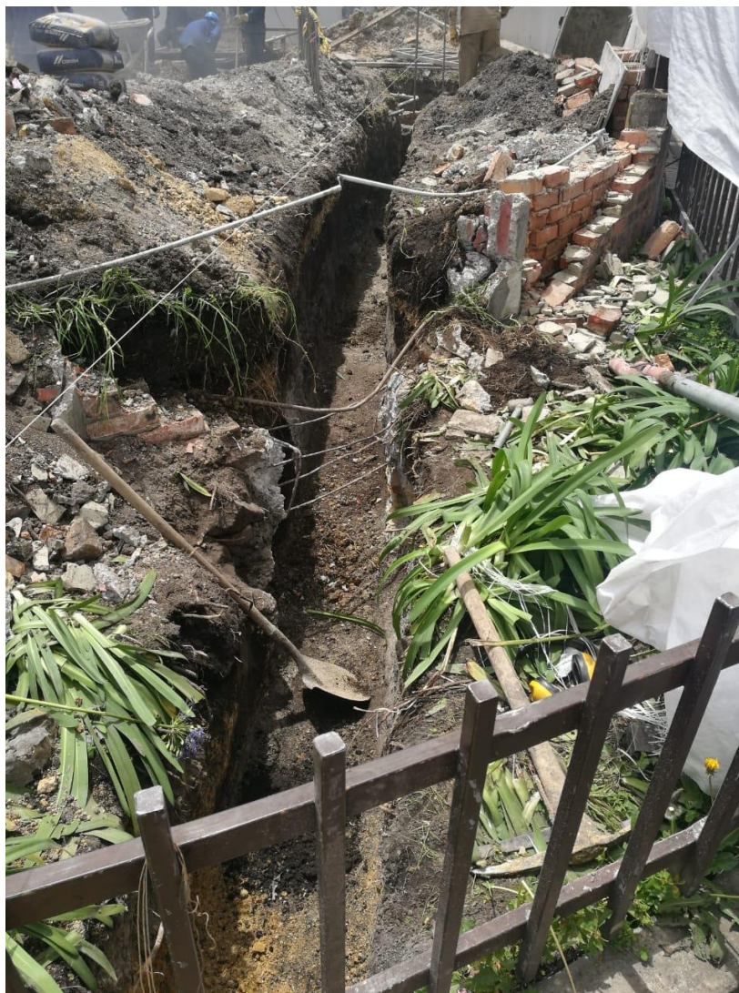
Figura 16: Excavación de la zanja para desagüe. Fuente: propia.
