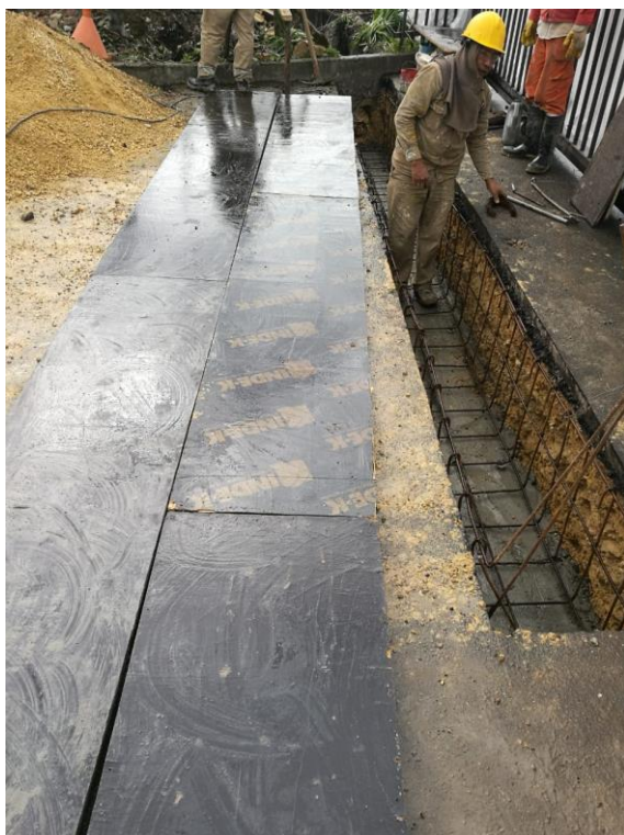
Figura 20 : Inicio instalación de testeros Fuente: propia
