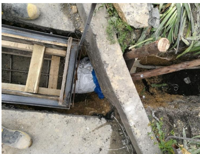
Figura 26: Pase de cárcamo a regata de pozo
