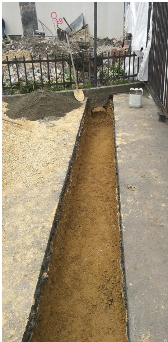
Figura 15: Excavación con dimensiones del cárcamo Fuente: propia, proceso constructivo del cárcamo
