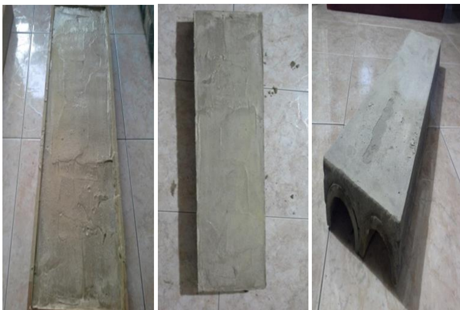
Imagen 27. Fraguado y desencofrado.
