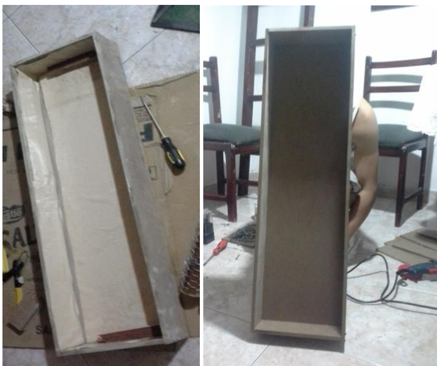
Imagen 21. Vista frontal formaletas para panel tipo I y II.
