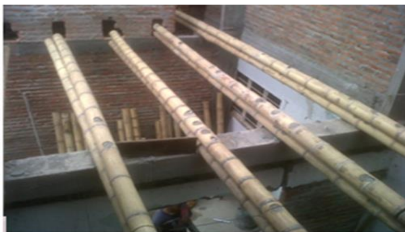
Imagen 7. Instalación de vigas de guadua y laminas
