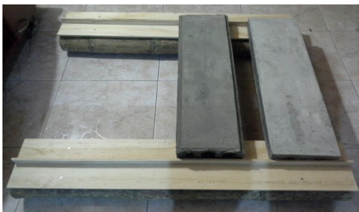
Imagen 38. Paneles sobre vigas.
