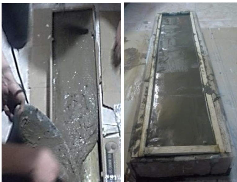
Imagen 30. Vertido de concreto y fraguado.
