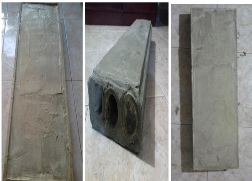
Imagen 31. Desencofrado de panel.
