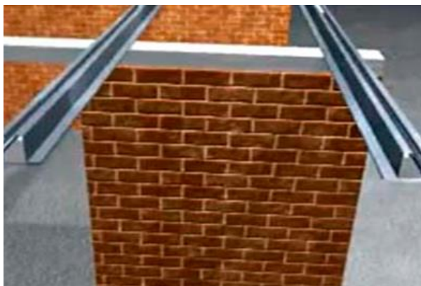
Figura 31. Instalación de bloquelon en estructura en concreto.
