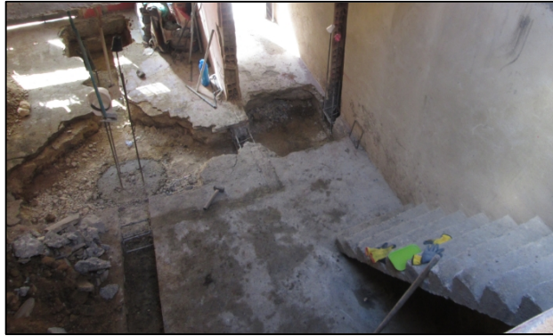
Ilustración 17. Detalle configuración anillos de cimentación (CASA 2).
