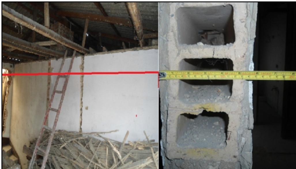
Ilustración 22. Detalle longitud del muro.
