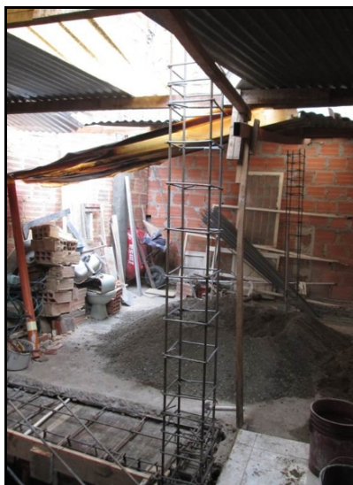
Ilustración 13. Detalle de la cubierta en la vivienda (CASA 1).
