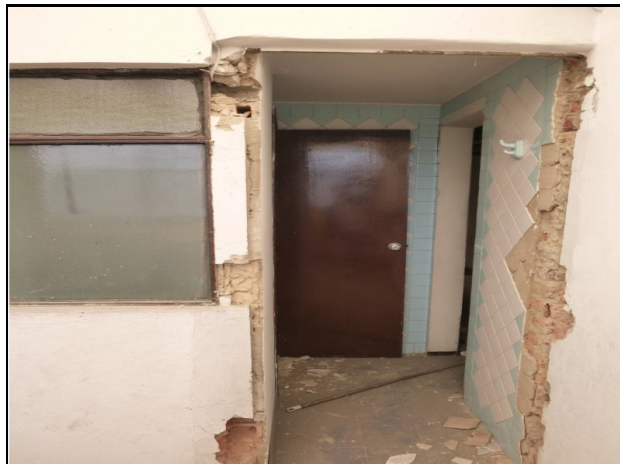
Ilustración 18. Detalle abertura en muro sin refuerzo (CASA 2).
