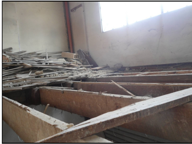
Ilustración 28. Detalle piso vivienda (CASA 2).
