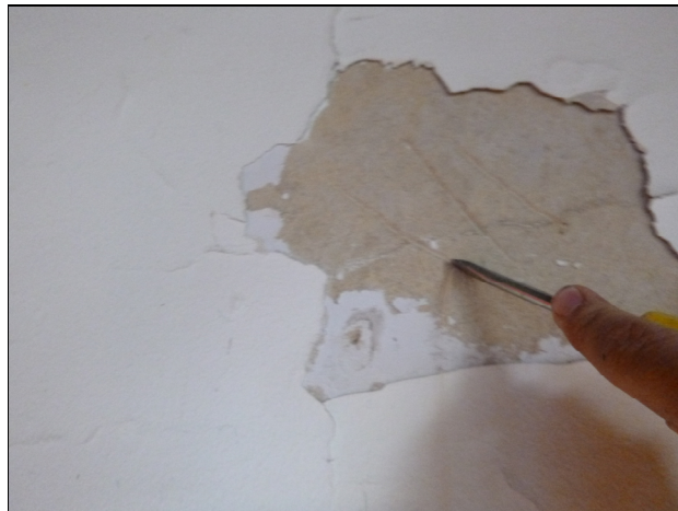
Ilustración 20. Detalle mortero y su resistencia mecánica en la vivienda (CASA 2).
