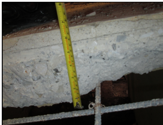
Ilustración 12. Espesor de placa de entrepiso en la vivienda (CASA 1).
