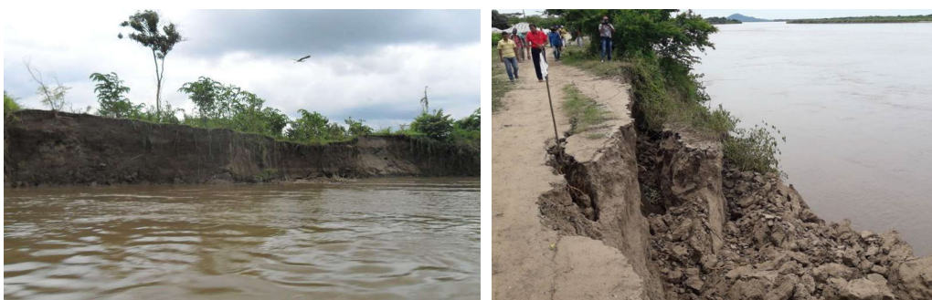
Figura 7 - Erosiones del Rio Magdalena en las riberas del municipio
